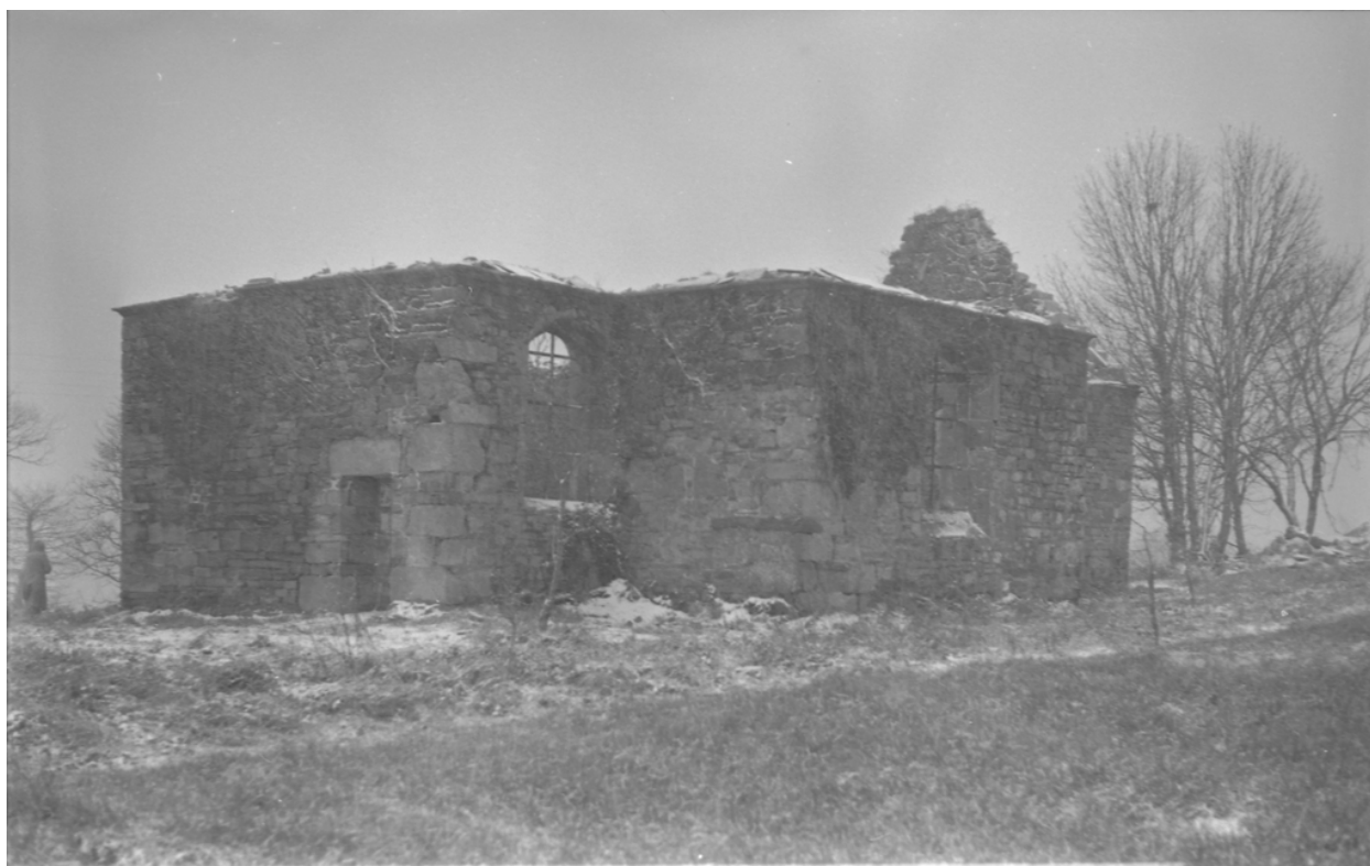
Vue générale prise du nord est
