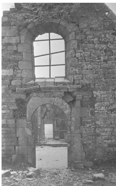
Elévation antérieure ouest Phot. Marie-Madeleine Tugores IVR53_19782200075Z
