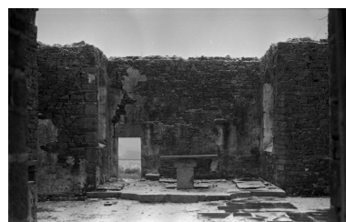
Vue intérieure prise d'est en ouest Phot. Marie-Madeleine Tugores IVR53_19782200076Z
