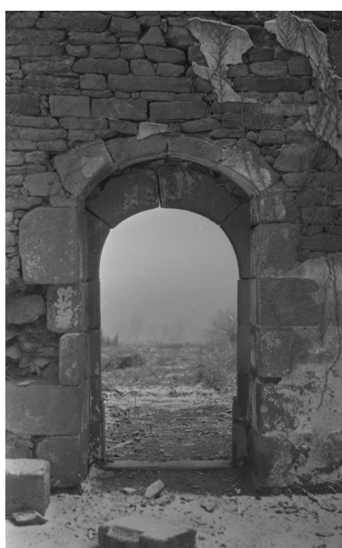
Porte ouest, vue prise de l'intérieur de la nef
