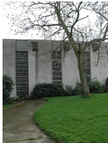
Détail des verrières de la façade nord Phot. Isabelle Barbedor IVR53_20013520637NUCA
