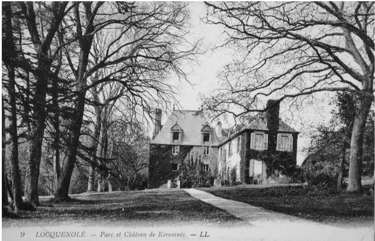
Vue sur un corps de bâtiment latéral
