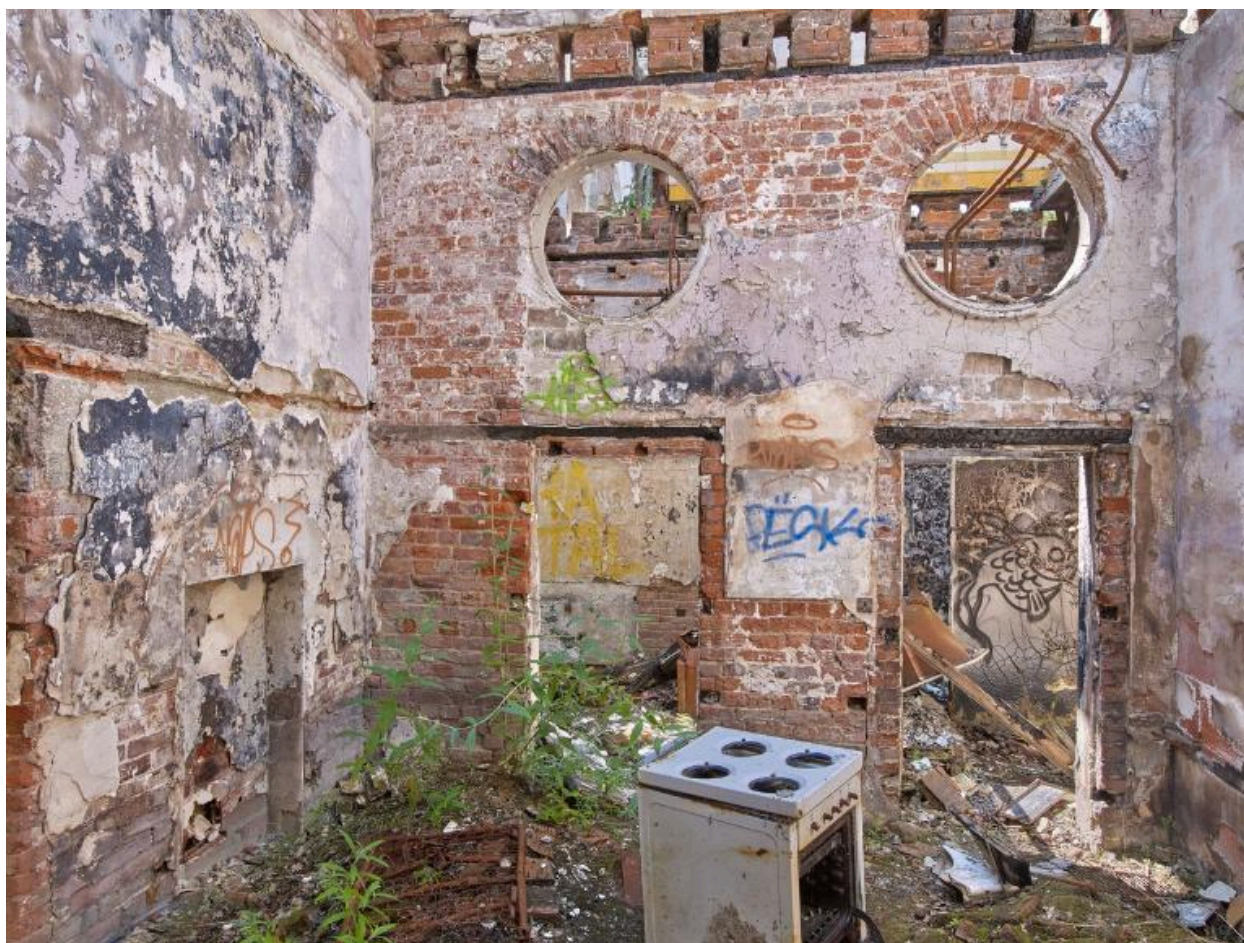
Vue intérieure : deux œils-de-bœuf de forme circulaire donnaient de la lumière en demi-jour à une pièce de service. Les murs intérieurs sont en brique enduit de plâtre avec linteaux en bois
