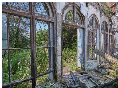
Vue intérieure : grande salle côté Sud-Ouest, vestiges des huisseries, portes-fenêtres en arc plein cintre et vitraux. Sur le mur, papier peint aux motifs floraux Phot. Bernard Bègne IVR53_20232200475NUCA
