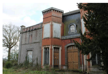
Vue de l'élévation orientée vers le Nord-est (état en 2013) Phot. Kev22 IVR53_20232205349NUCA
