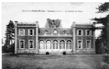
Vue de l'élévation orientée vers le Sud-ouest, carte postale (éditions J. Sorel, Rennes) Phot. Auteur inconnu
