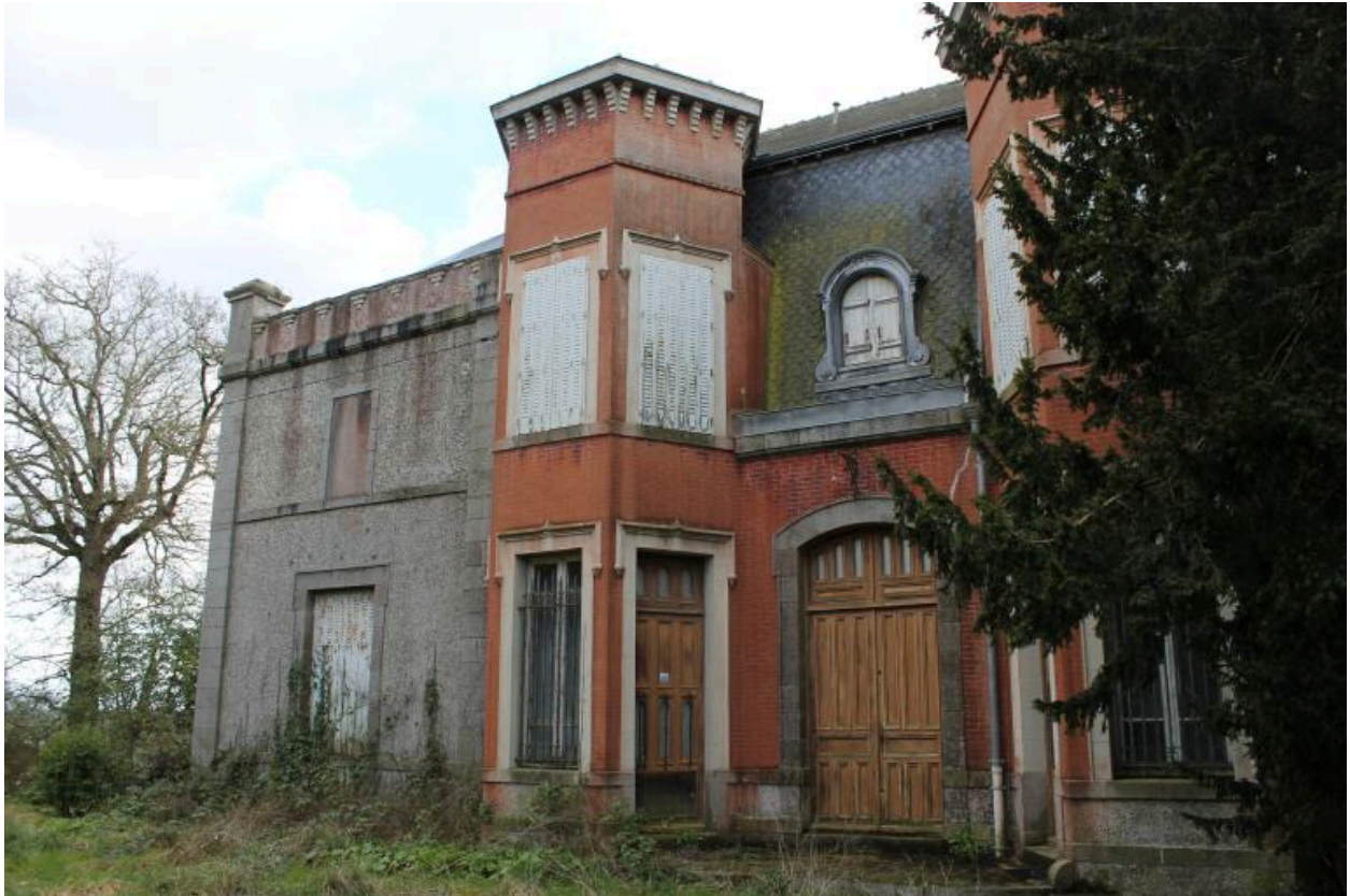
Vue de l'élévation orientée vers le Nord-est (état en 2013)
