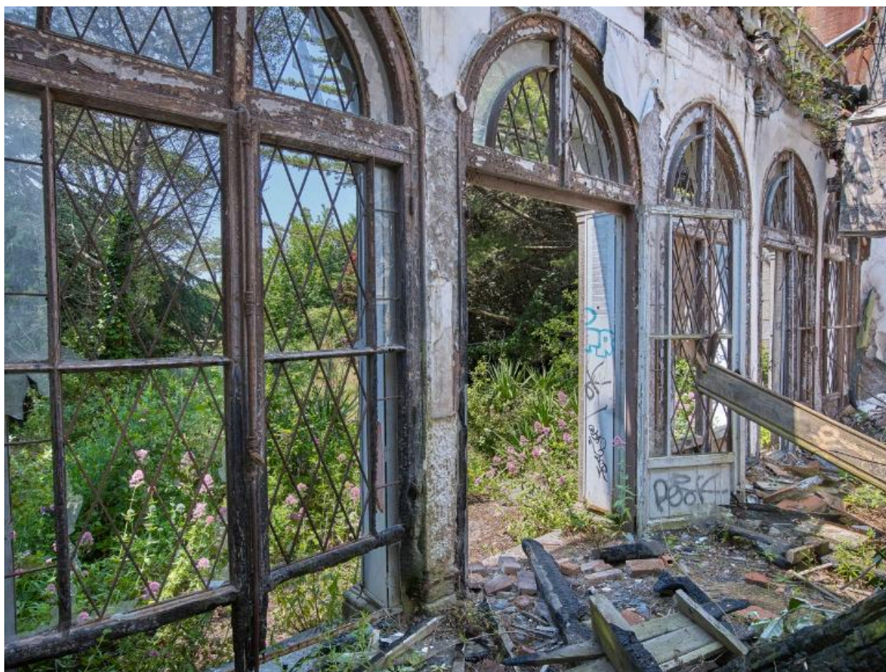
Vue intérieure : grande salle côté Sud-Ouest, vestiges des huisseries, portes-fenêtres en arc plein cintre et vitraux. Sur le mur, papier peint aux motifs floraux
