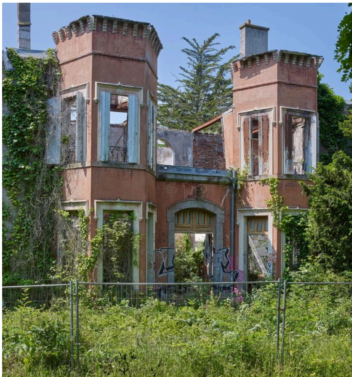
Vue de l'élévation Nord-est : partie centrale comprenant l'entrée encadrée par deux tourelles
