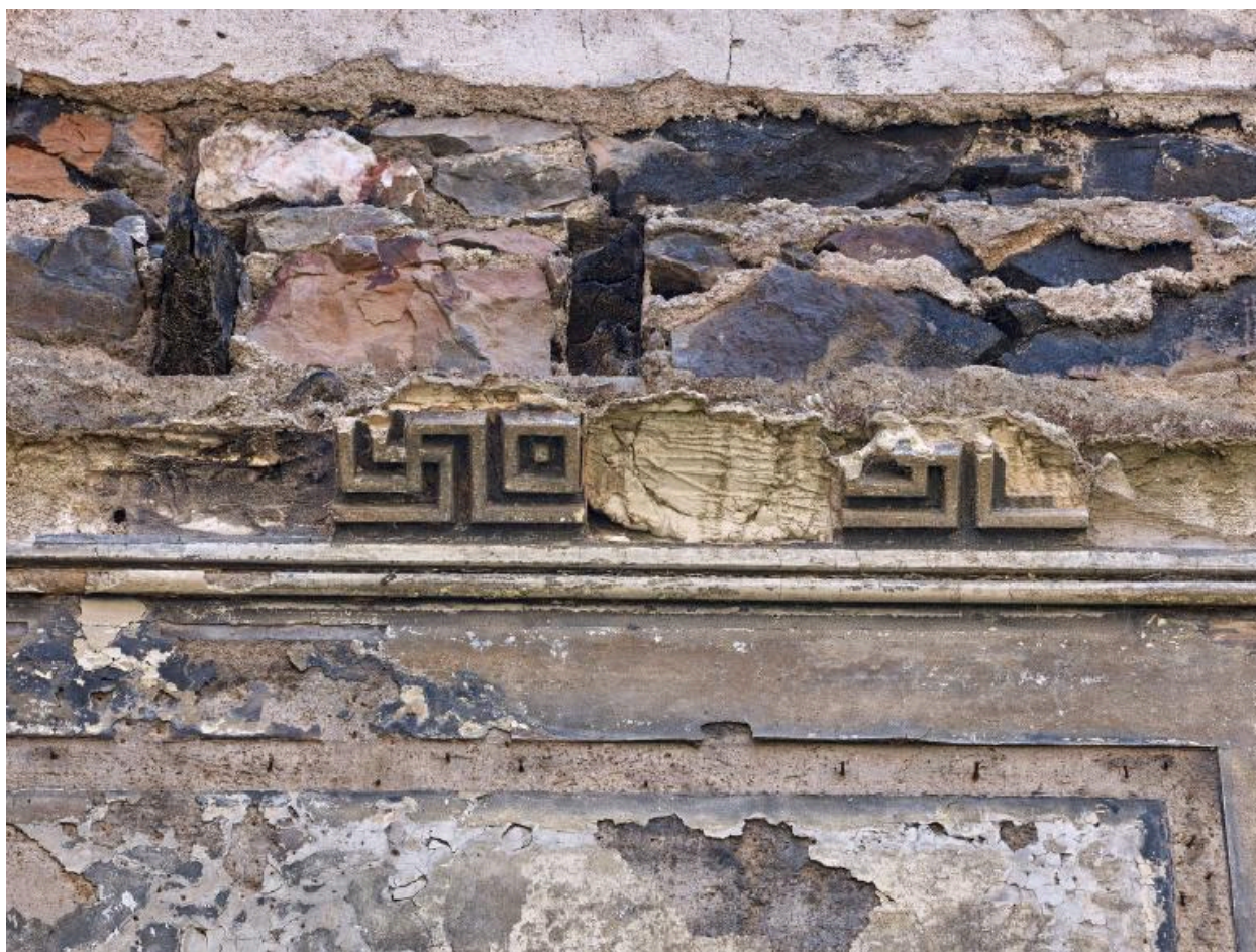
Vue intérieure : salle située au Sud-ouest, vestiges d'une frise de style greco-romain en staff (plâtre) et traces de boiseries
