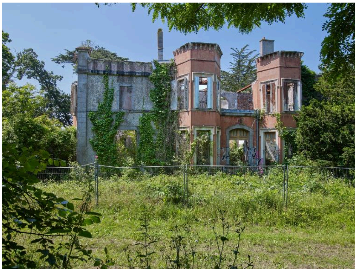
Vue générale de l'élévation Nord-est
