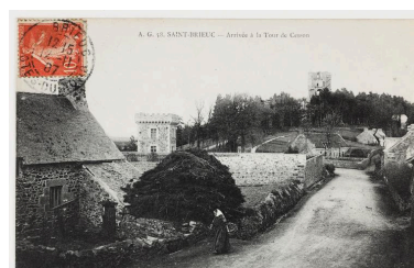
Vue des environs de l'entrée du Domaine de la Tour de Cesson, carte postale (éditions André Garnon, Orléans). A gauche, surmontée de crénelage et de faux mâchicoulis, la conciergerie (logement du concierge / gardien). Au centre, le logis de la ferme-modèle et la tour Phot. Auteur inconnu IVR53_20232205329NUCA
