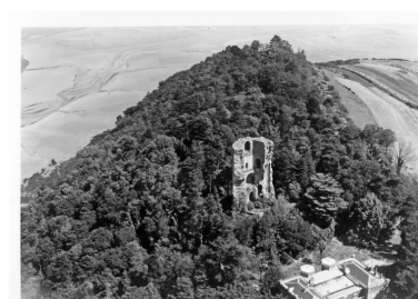
Vue aérienne oblique de la tour et de la demeure (datée vers 1945-1975). Les deux tourelles de la demeure ont perdu leur couverture en poivrière ; les deux ailes sont couvertes en pavillon (en ardoise) ; le corps central est couvert en ardoise et en zinc Phot. Roger Henrard IVR53_20232205311NUCA
