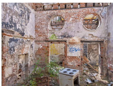
Vue intérieure : deux œils-de-bœuf de forme circulaire donnaient de la lumière en demi-jour à une pièce de service. Les murs intérieurs sont en brique enduit de plâtre avec linteaux en bois Phot. Bernard Bègne IVR53_20232200479NUCA
