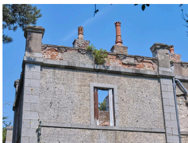
Vue de l'élévation Sud-est : chaînages (faisant pinacles) et bandeau en granite gris viennent souligner l'architecture tout comme les consoles en pyramide inversée qui ornent la partie sommitale et les souches de cheminées en terre cuite Phot. Bernard Bègne IVR53_20232200465NUCA
