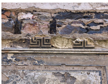
Vue intérieure : salle située au Sud-ouest, vestiges d'une frise de style greco-romain en staff (plâtre) et traces de boiseries
