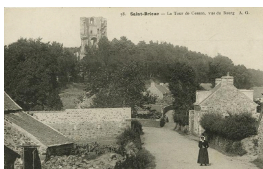
Vue des environs de l'entrée du Domaine de la Tour de Cesson, carte postale (A. G.). A travers les arbres, on aperçoit l'une des deux tourelles couvertes en poivrière de la demeure Phot. Auteur inconnu IVR53_20232205337NUCA
