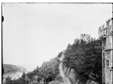
Vue du Domaine de la Tour de Cesson et de ses abords immédiats. A droite, la conciergerie (logement du concierge / gardien). Un chemin longe le mur de clôture (faisant soutènement) du domaine jusqu'à la Tour Malakoff, belvédère sur le Légué. A gauche, l'embouchure du Gouët Phot. Henri Deneux IVR53_20232205308NUCA
