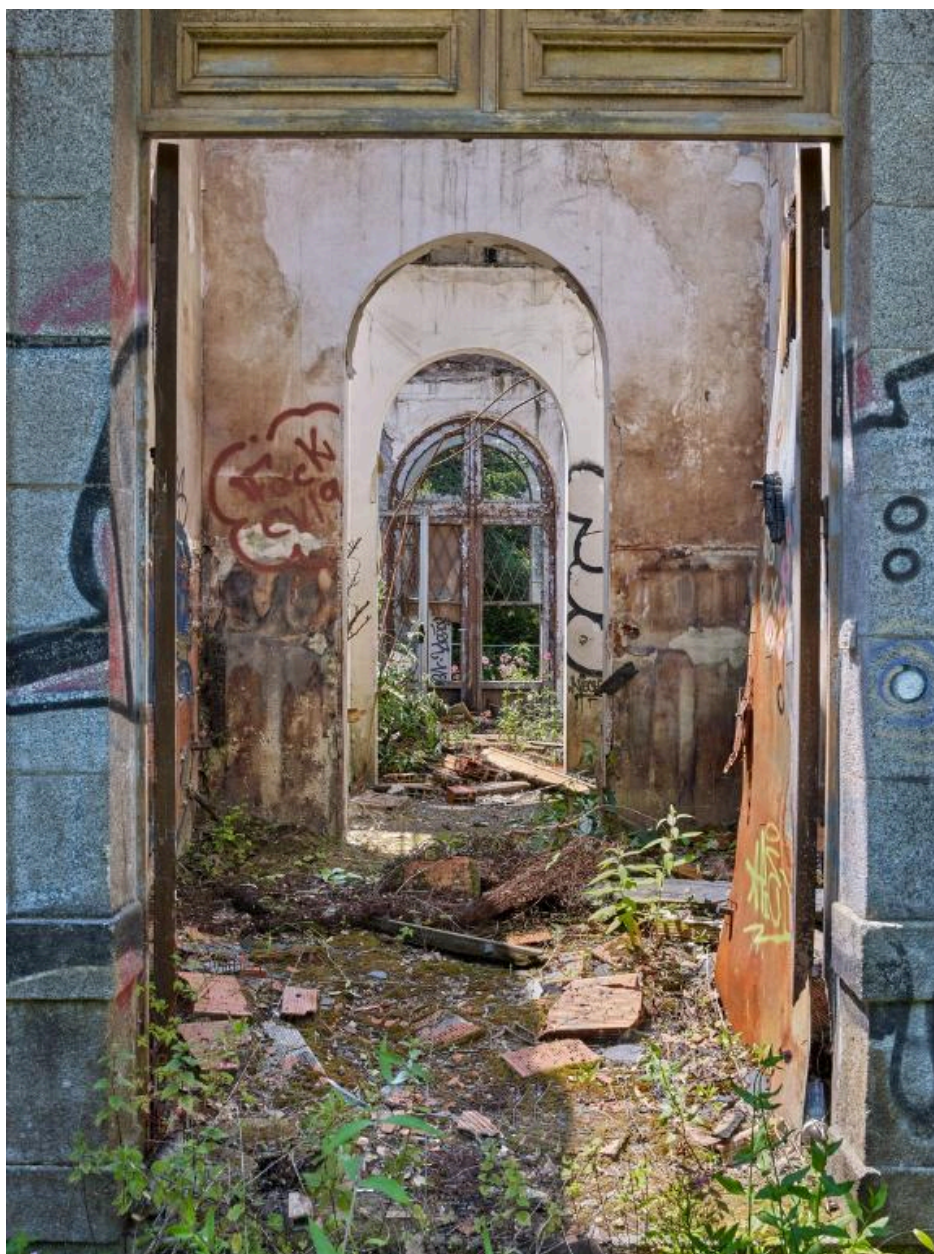
Vue de l'entrée principale (aménagée au centre de l'élévation Nord-est) et des murs de refend du Nord-est vers le Sud-Ouest
