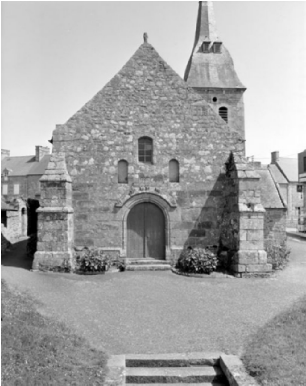
Elévation Ouest : vue générale
