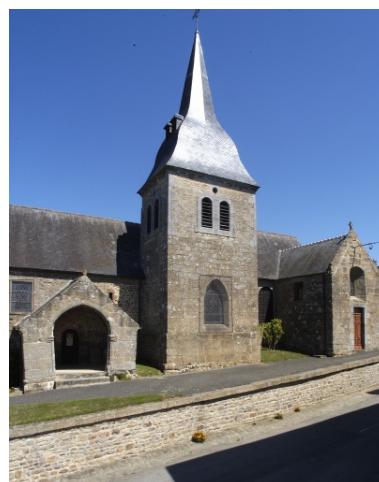
Elévation sud, porche et clocher Phot. Norbert Lambart IVR53_20053502404NUCA
