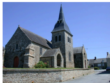
Vue générale sud-ouest Phot. Marie Pottecher IVR53_20053517347NUCA
