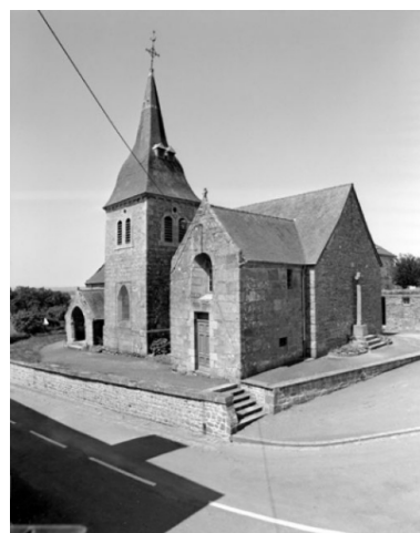
Elévation Sud-Est : vue générale Phot. Guy Artur, Phot. Norbert Lambart IVR53_19943500966X
