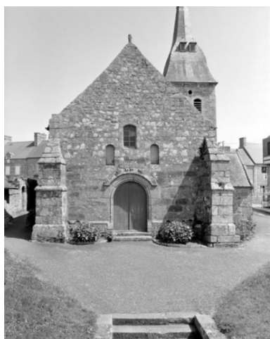
Elévation Ouest : vue générale Phot. Guy Artur, Phot. Norbert Lambart IVR53_19943500969X
