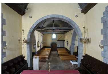
Vue intérieure prise du choeur vers la nef Phot. Bernard Bègne IVR53_20053502236NUCA
