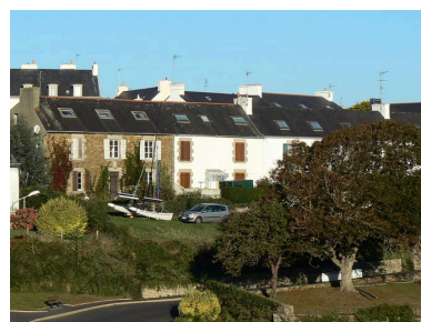
Partie gauche de l'ancienne conserverie Peyron côté quai Phot. Johan Vincent IVR53_20072909004NUCA
