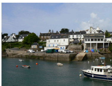
Ancienne conserverie Peyron vue de la ria de Doëlan Phot. Julien Amghar IVR53_20082908557NUCA
