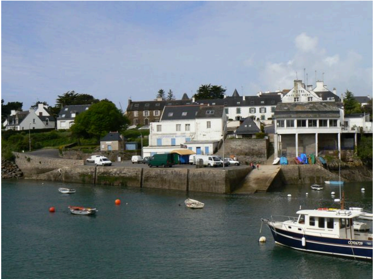
Ancienne conserverie Peyron vue de la ria de Doëlan
