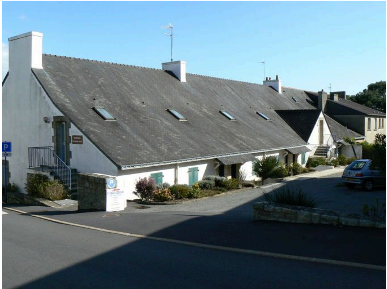
Arrière de l'ancienne conserverie Peyron
