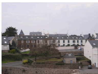
Vue générale de l'ancienne conserverie Peyron actuellement Résidence Capitaine Cook Phot. Florence Despretz IVR53_20072909003NUCA
