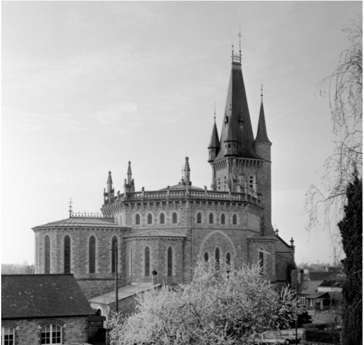
Elévation Nord-Est : vue générale
