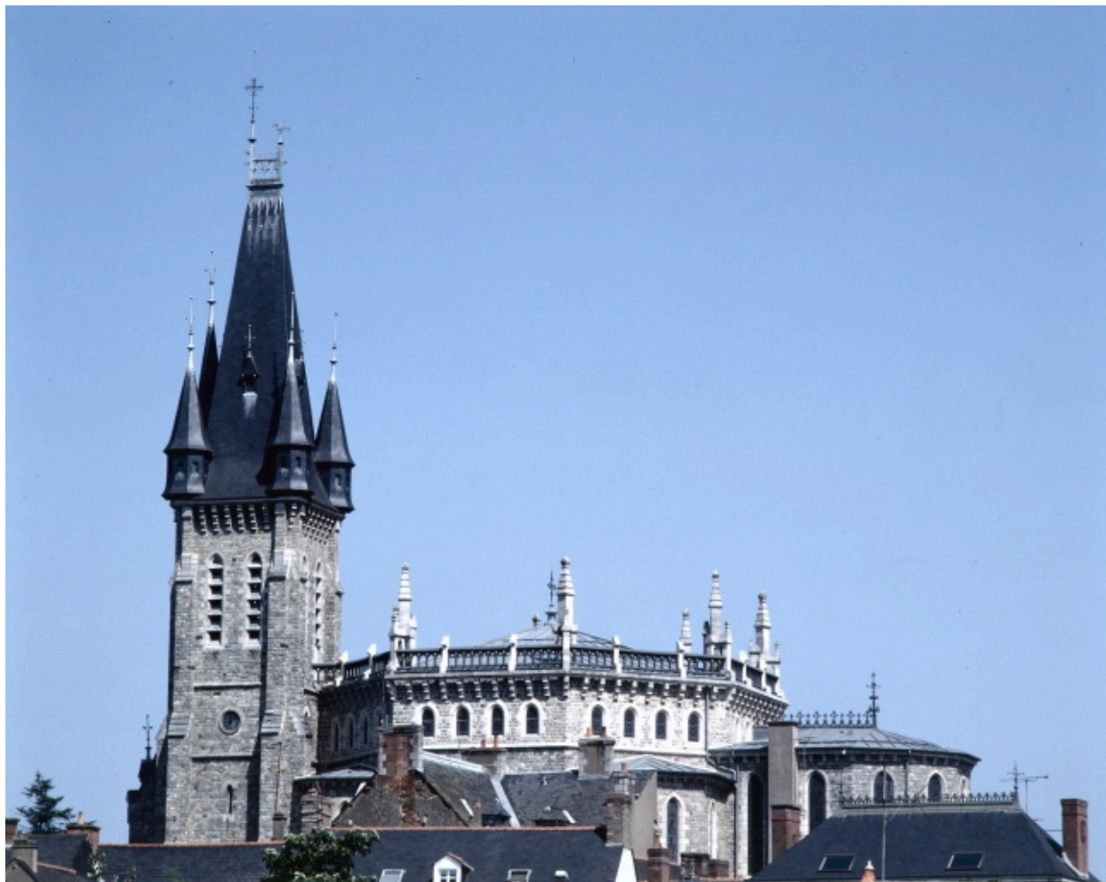
Elévation Nord : vue générale
