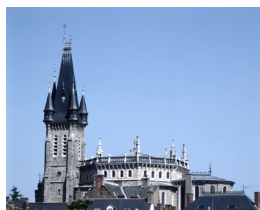
Elévation Nord : vue générale Phot. Guy Artur, Phot. Norbert Lambart IVR53_19923500677XA
