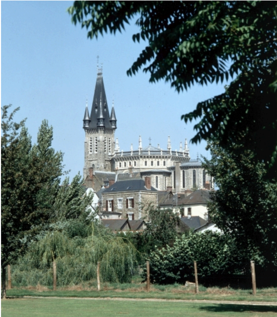
Elévation Sud : vue de situation
