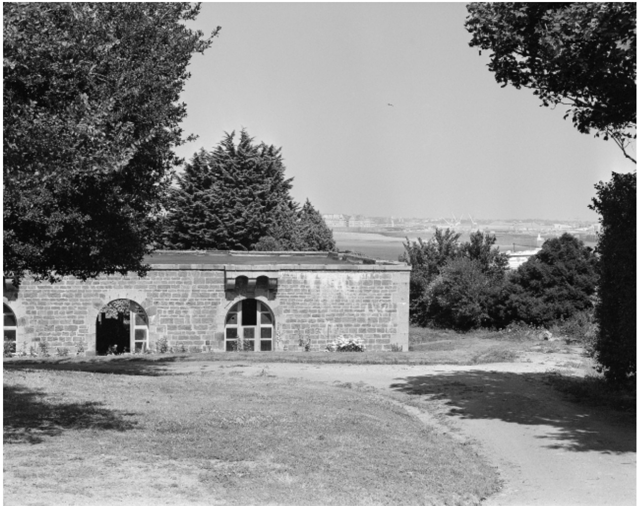
Vue de l'élévation ouest (état en 1996). Les baies sont élargies et le parapet de la plate-forme est arasé : seuls les corbeaux des mâchicoulis de pied des bretèches sont visibles. En arrière-plan, la Rance et Saint-Malo
