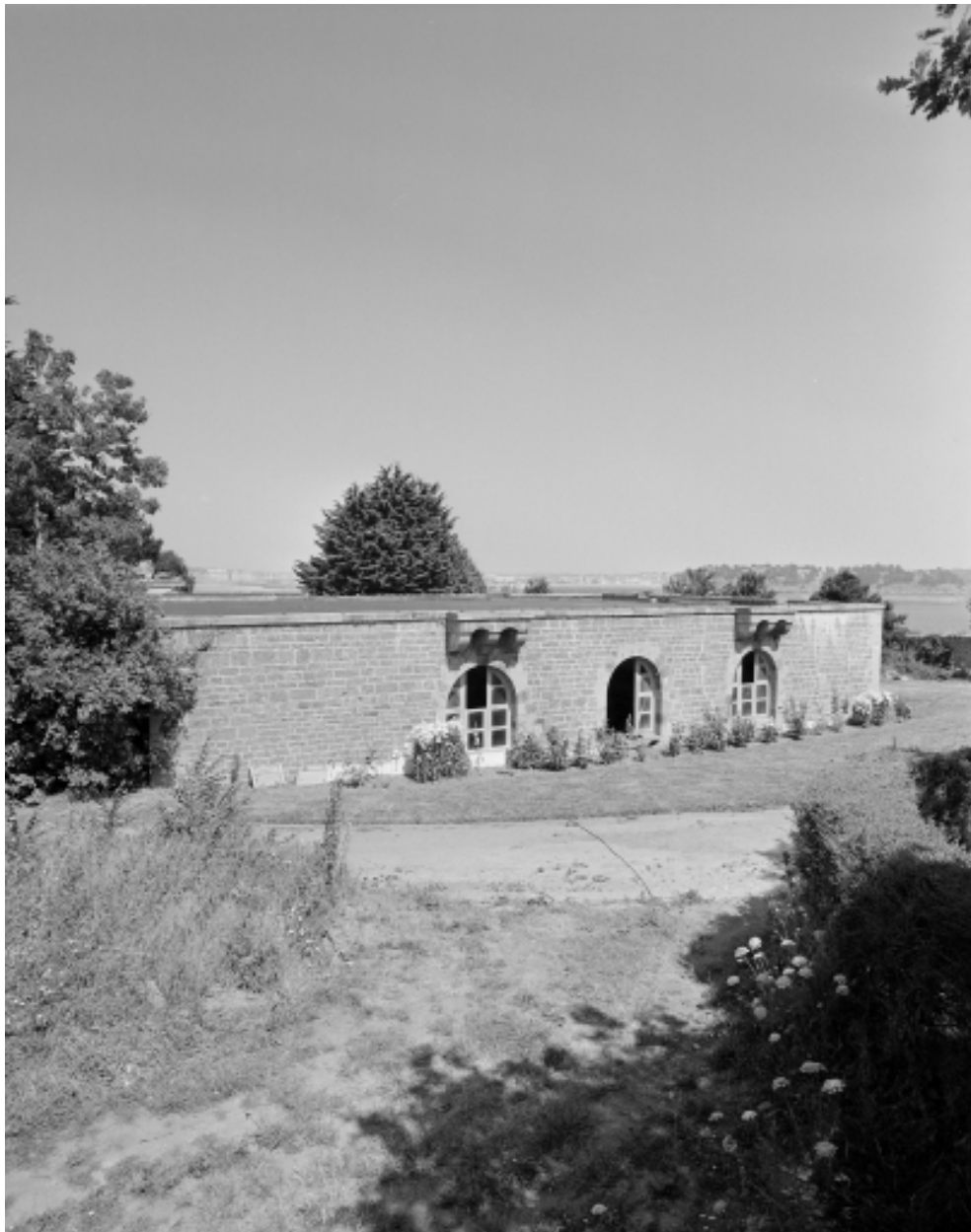
Vue générale de l'élévation ouest depuis le nord-ouest (état en 1996). Les baies sont élargies et le parapet de la plate-forme est arasé : seuls les corbeaux des mâchicoulis de pied des bretèches sont visibles
