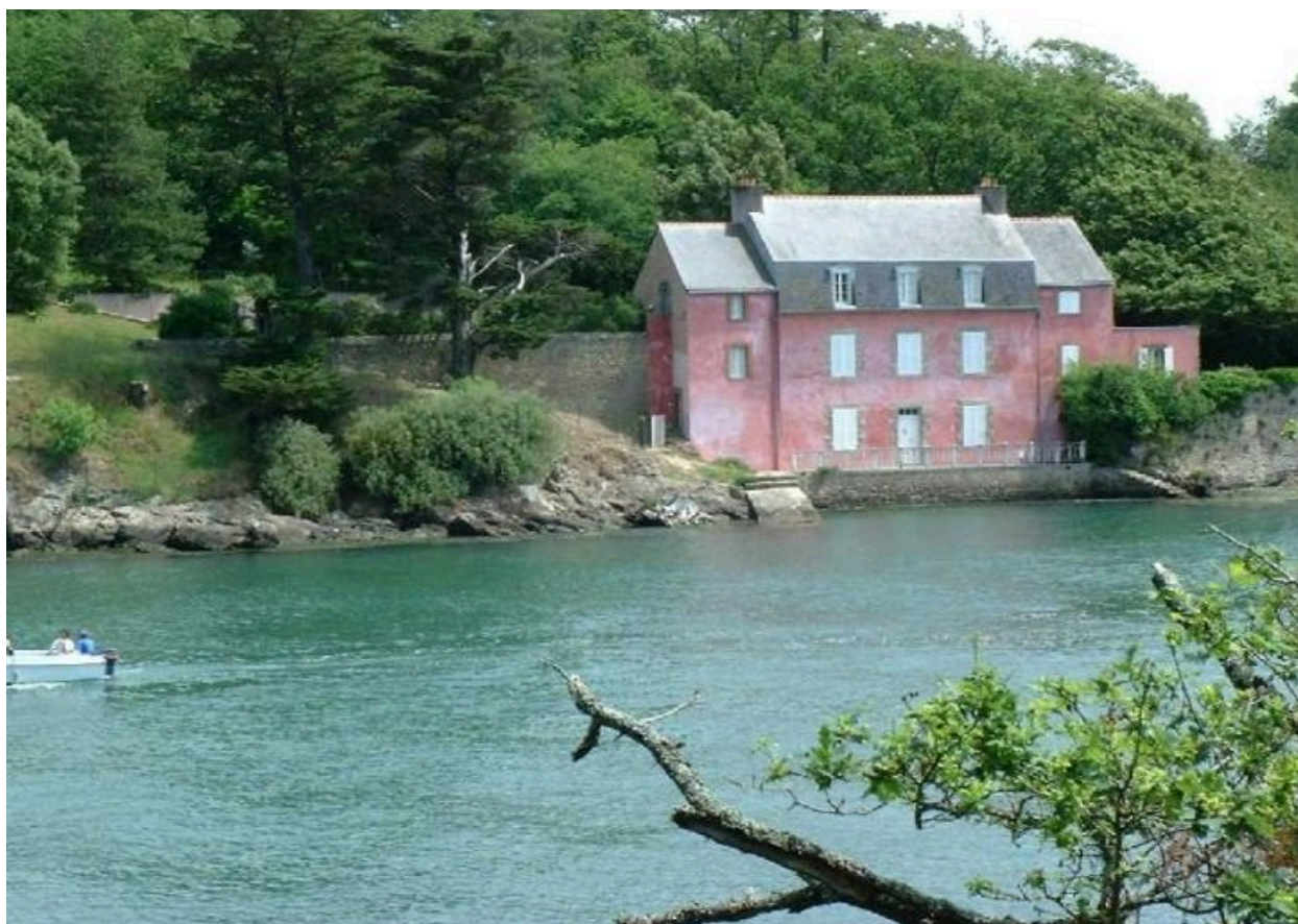
Vue générale du quai et de la cale de la maison rose
