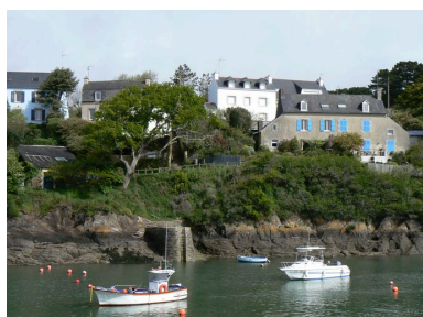
Vue d'ensemble du magasin et de la maison 'Joseph Tonnerre' Phot. Julien Amghar IVR53_20082908569NUCA
