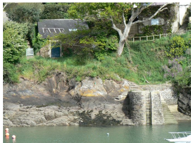
Vue générale du magasin 'Joseph Tonnerre' Phot. Julien Amghar IVR53_20082908571NUCA
