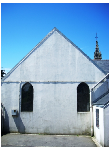
Ploudalmézeau, église de Portsall : élévation est
