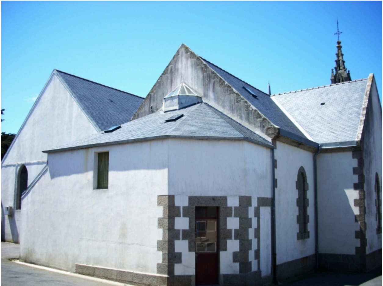
Ploudalmézeau, église de Portsall : vue générale nord-est
