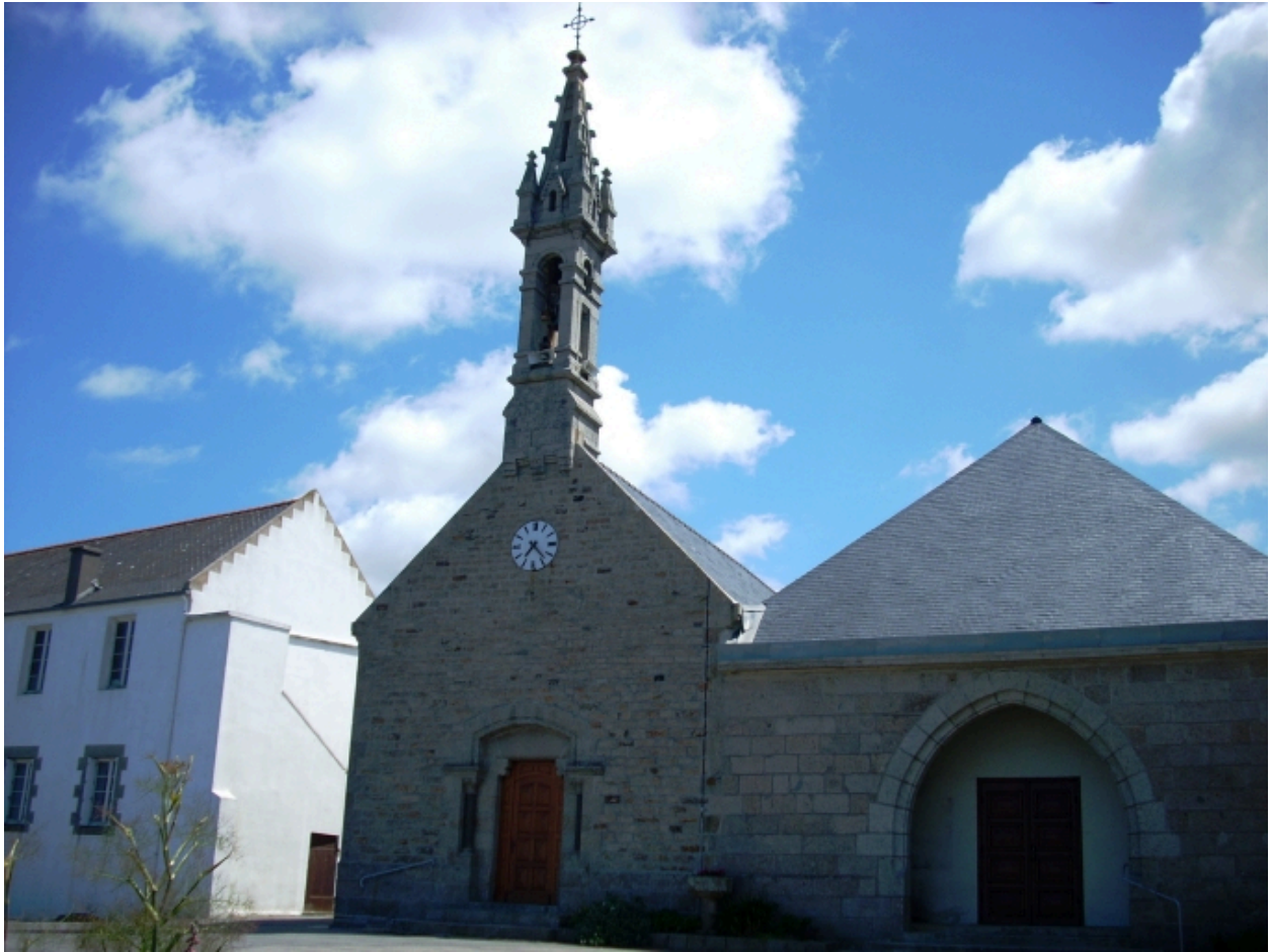
Ploudalmézeau, église de Portsall : vue générale ouest
