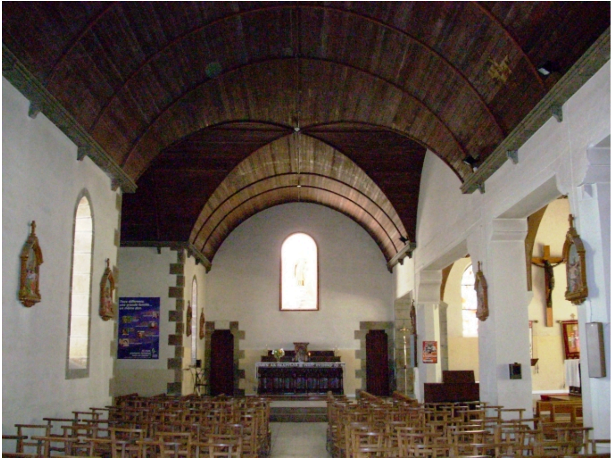
Ploudalmézeau, église de Portsall : vue axiale est de la chapelle latérale nord
