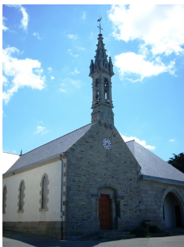
Ploudalmézeau, église de Portsall : vue générale nord-ouest Phot. Gwénaél Fauchille IVR53_20082906163NUCA
