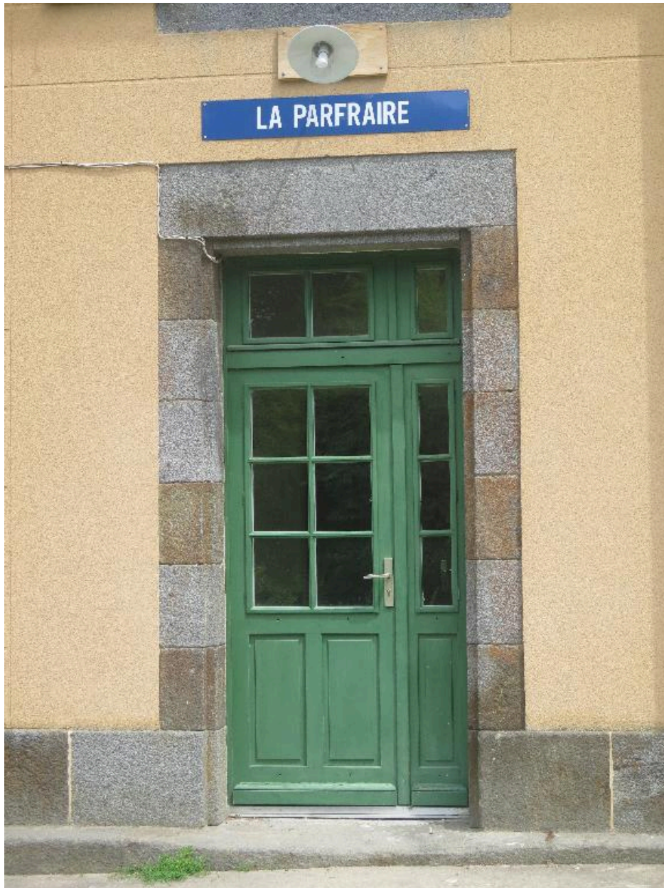
La porte avec imposte et encadrement en granite
