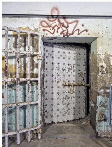
Vue d'une porte en bois cloutée à verrou, doublée d'une grille, dans la cage d'escalier au niveau du rez-de-chaussée. Il s'agit de clous à tête pointe de diamant
