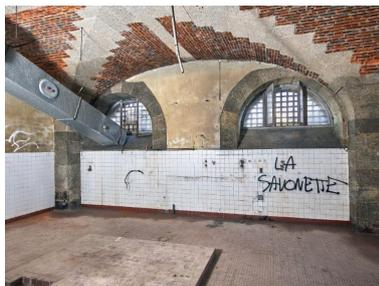
Vue de la pièce voûtée à deux travées du rez-de-chaussée, côté est : sa voûte complexe est en brique et en pierre de taille de granite gris. Elle servait de cuisine comme le montrent les murs et sols carrelés et le système d'aspiration
