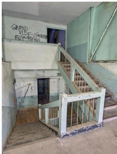
Vue de la cage d'escalier depuis le palier situé entre le troisième étage et le niveau de comble. L'escalier est en béton armé. Quoique repeints en vert clair, les murs conservent leur enduit en faux appareillage
