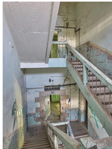
Vue de la cage d'escalier depuis le palier situé entre les premier (porte n° 17 ?) et deuxième étages. L'escalier est en béton armé. Quoique repeints en vert clair, les murs conservent leur enduit en faux appareillage
