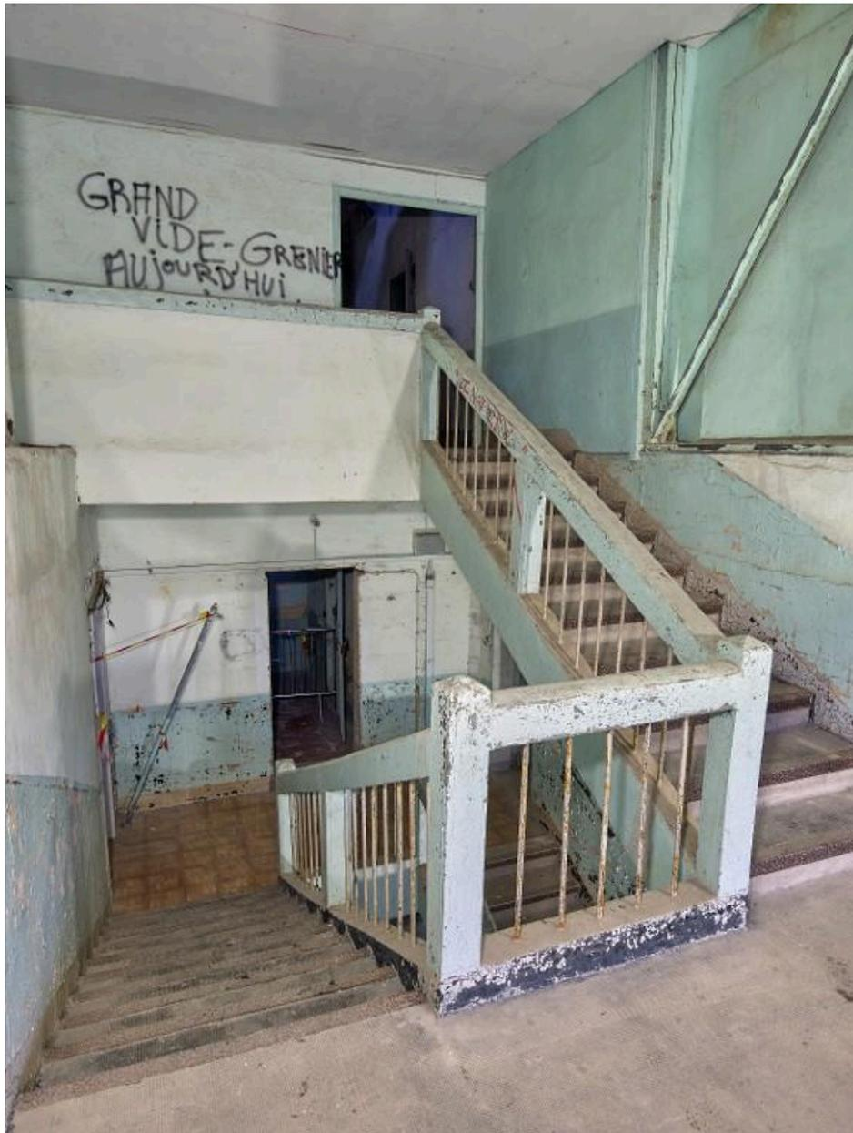
Vue de la cage d'escalier depuis le palier situé entre le troisième étage et le niveau de comble. L'escalier est en béton armé. Quoique repeints en vert clair, les murs conservent leur enduit en faux appareillage
