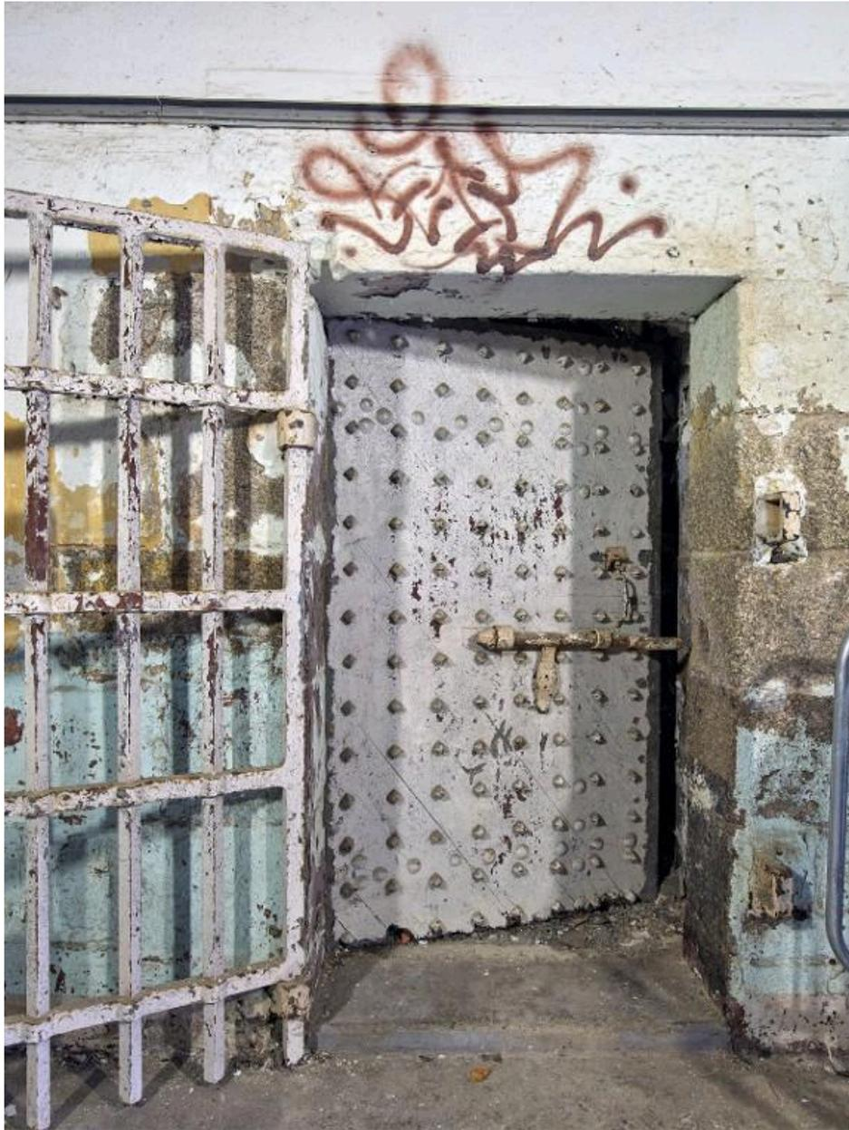
Vue d'une porte en bois cloutée à verrou, doublée d'une grille, dans la cage d'escalier au niveau du rez-de-chaussée. Il s'agit de clous à tête pointe de diamant
