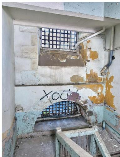
Vue du palier situé entre le rez-de-chaussée et le premier étage. L'escalier est en béton armé. Les baies ont perdu leurs carreaux en verre
