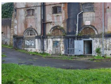
Vue de détail de l'élévation est du bâtiment carcéral : portes et baies en arc plein cintre dotées de grilles. Leurs gabarits ont été modifiés comme le montrent les piedroits et parpaings de béton. A gauche, une ancienne porte ; à droite, deux fenêtres
