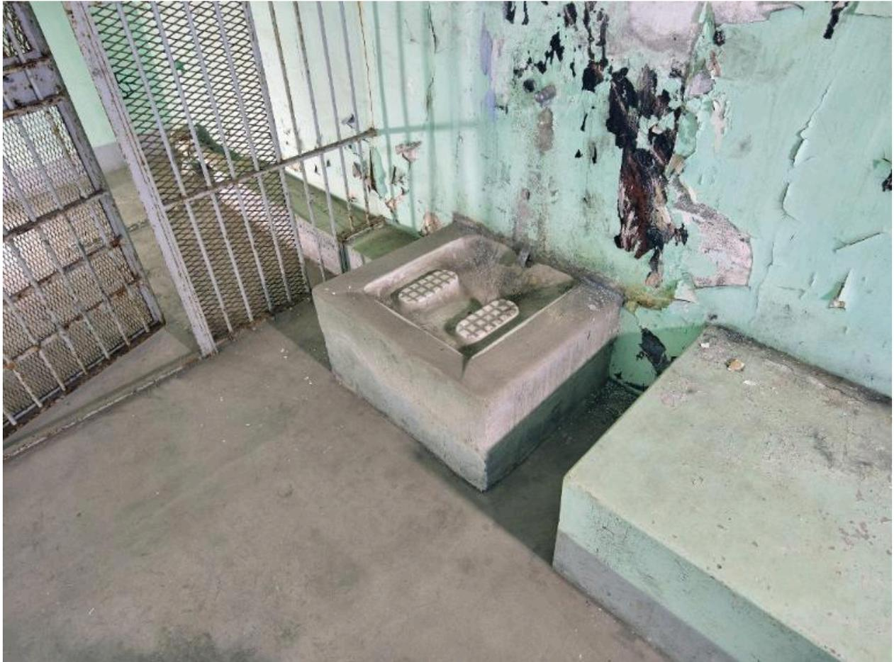
Vue de l'une des cellules du troisième étage avec grille faisant sas (cellule de punition). Au centre, toilette à la turque (sans cloison) ; à droite, soubassement en maçonnerie du lit
