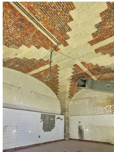
Vue de la pièce voûtée à deux travées du rez-de-chaussée, côté est : sa voûte complexe est en brique et en pierre de taille de granite gris. Elle servait de cuisine comme le montrent les murs et sols carrelés et le système d'aspiration
