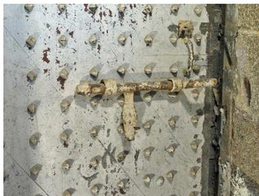
Vue de détail du verrou de la porte cloutée. Il s'agit de clous à tête pointe de diamant
