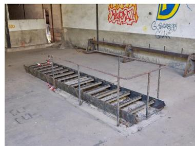
Vue du niveau de comble : extrémité sud, trémie d'escalier bouchée avec sa rampe en place et escalier droit métallique déposé. Contre les murs qui ont conservé leur enduit et leur peinture d'origine, installation pour mailler des filets de pêche
