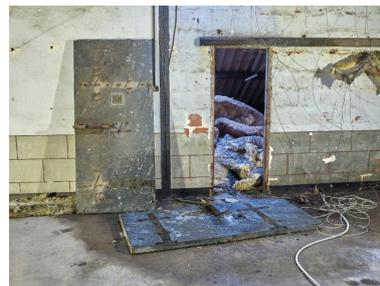
Vue du niveau de comble : extrémité nord, portes de cellule déposées. Elles ont perdu serrures et pentures ; seuls les verrous subsistent. Les murs conservent leur enduit et leur peinture d'origine
