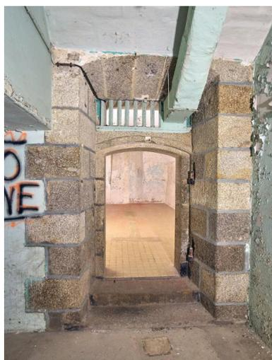
Vue de l'entrée de l'une des pièces voûtées du rez-de-chaussée (n° 3 en partie effacé). Son imposte est dotée de barreaux verticaux ; un conduit distribuait de l'air chaud dans la pièce
