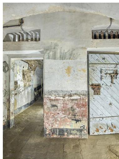
Vue de la pièce voûtée nord du rez-de-chaussée, côté ouest. Elle est divisée en deux petites cellules qui conservent : porte en bois à juda et verrou, impostes à barreaux, enduit et peinture avec traces d'un bat-flanc. Au sol, dallage en granite
