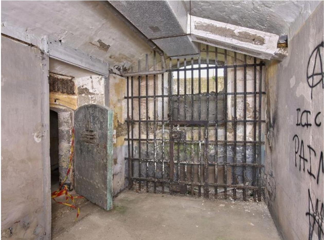
Vue de l'extrémité nord du couloir central voûté du rez-de-chaussée. La fenêtre semblait être à l'origine une porte, doublée d'une grille avec porte piétonne. A droite, la porte de la cellule nord, côté ouest. Suspendu au plafond, le système de chauffage
