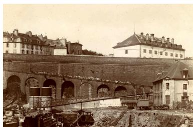
Vue générale en 1899 (avant surélévation du bâtiment carcéral). On peut voir : l'enduit de teinte claire qui recouvre les façades ; la couverture en pavillon en ardoise percée de lucarnes et souches de cheminée et couronnée de deux paratonnerres
