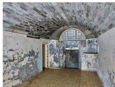
Vue de l'une des pièces voûtées du rez-de-chaussée (deuxième travée depuis le sud, n° 4). La porte donnant vers l'est est murée en parpaing de béton
