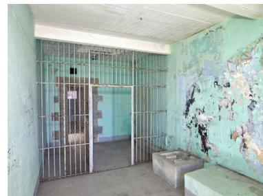
Vue du couloir central du troisième étage : de part et d'autre, des cellules. Les portes ont perdu serrure et verrou. La dalle du niveau de comble repose sur des poutres en béton ; le sol est en plancher bois
