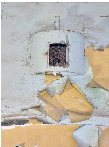
Vue du couloir central du deuxième étage, extrémité sud : boîte à lumière en place au-dessus d'une porte de cellule (murée, car transformé en logement)
