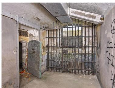
Vue de l'extrémité nord du couloir central voûté du rez-de-chaussée. La fenêtre semblait être à l'origine une porte, doublée d'une grille avec porte piétonne. A droite, la porte de la cellule nord, côté ouest. Suspendu au plafond, le système de chauffage
