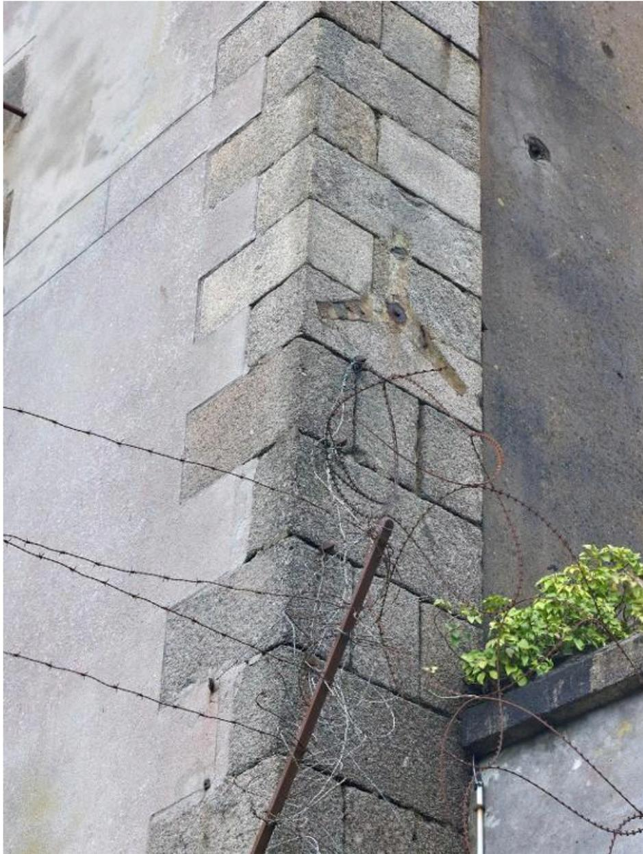
Vue de détail du pignon nord du bâtiment carcéral : chaîne d'angle en pierre de taille de granite gris. Les granites différents attestent d'une surélévation. On voit la trace d'un tirant disparu. A droite, impacts de tir
