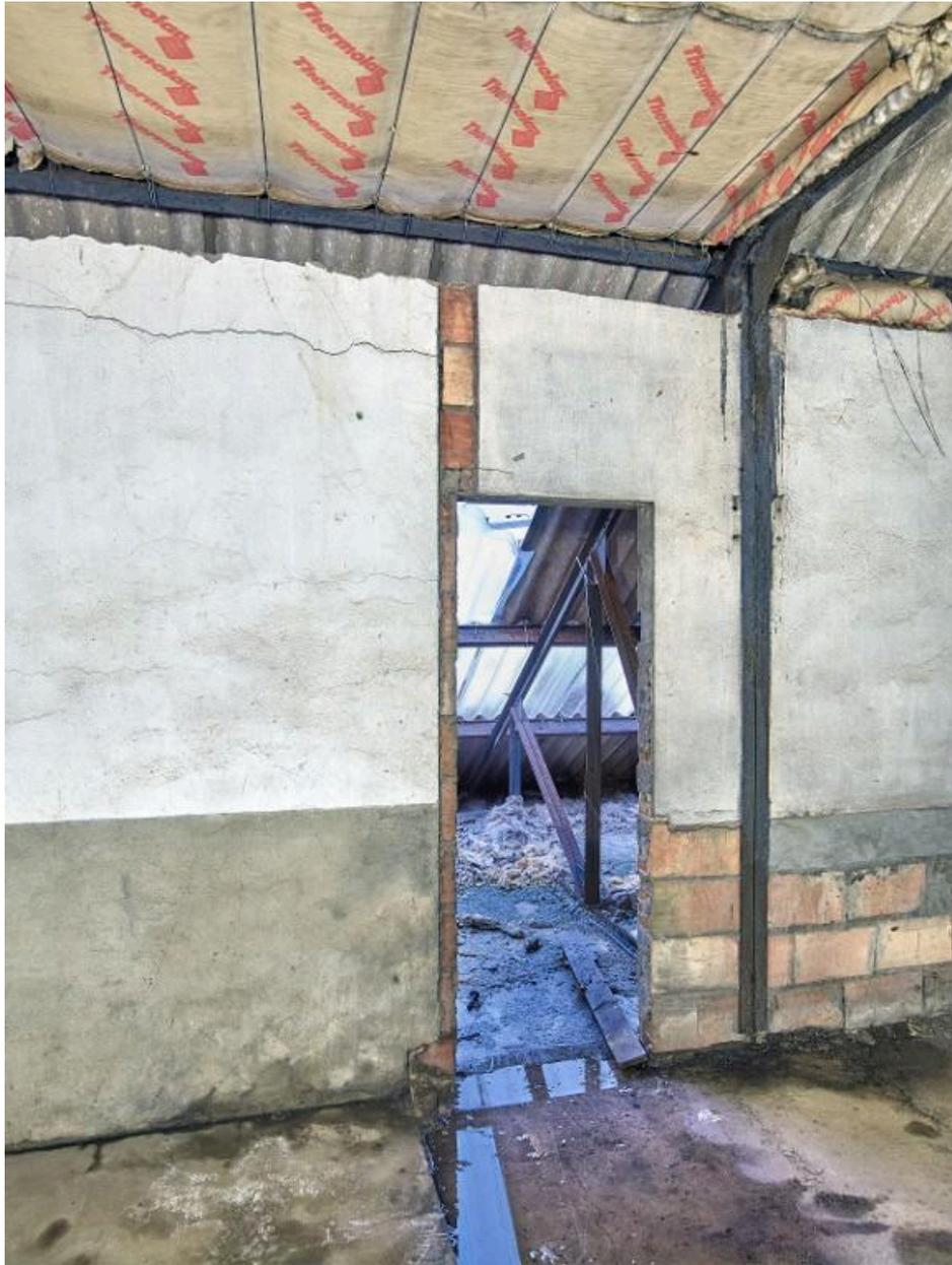
Vue du niveau de comble : les murs en brique conservent leur enduit et leur peinture d'origine. La charpente métallique porte des plaques de fibrociment et des plaques translucides
