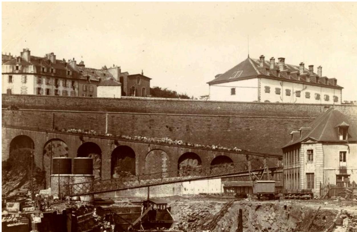
Vue générale en 1899 (avant surélévation du bâtiment carcéral). On peut voir : l'enduit de teinte claire qui recouvre les façades ; la couverture en pavillon en ardoise percée de lucarnes et souches de cheminée et couronnée de deux paratonnerres
