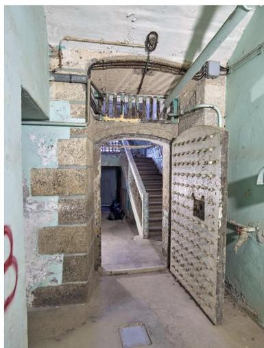
Vue de la porte en bois cloutée depuis le couloir central : elle donne sur le rez-de-chaussée de la cage d'escalier. L'imposte est dotée de barreaux verticaux
