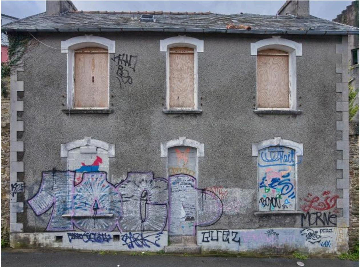
Vue du logement pour l'agent principal et sa famille. Ses ouvertures sont murées ou fermées. Entourages des ouvertures, chaînes d'angle et perron semblent en pierre de taille de granite. La maçonnerie de moellon est masquée par un enduit
