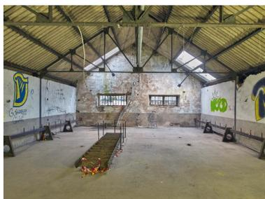
Vue du niveau de comble : extrémité sud, au centre, trémie d'escalier bouchée. Contre les murs qui ont conservé leur enduit et leur peinture d'origine, installation pour mailler des filets de pêche. La charpente métallique porte des plaques de fibrociment
