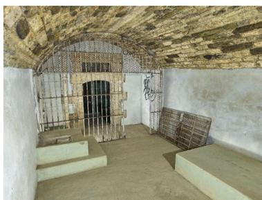
Vue de l'une des cellules voûtées du rez-de-chaussée, côté ouest avec grille faisant sas (cellule de punition). A gauche, les toilettes à la turque (sans cloison) ; à droite, le soubassement en maçonnerie du lit
