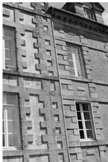
Détail du chaînage d'angle Phot. Bernard Bègne IVR53_20093502223Z
