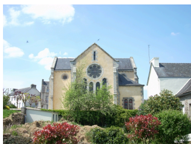
Collorec, église paroissiale Notre-Dame : élévation est Phot. Gwénaél Fauchille IVR53_20082905831NUCA
