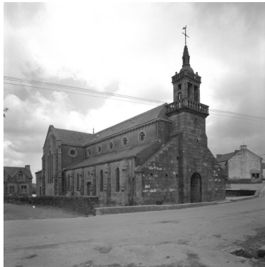
Collirec, église paroissiale Notre-Dame : vue générale nord-ouest, état en 1967 Phot. François Dagorn IVR53_19672900179V
