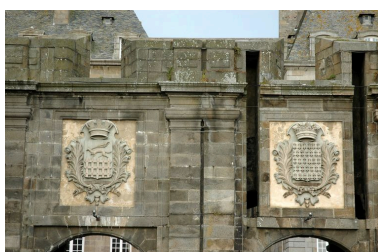
Vue de la porte Saint-Vincent : armoiries Phot. Guillaume Lécueillier IVR53_20063517673NUCA
