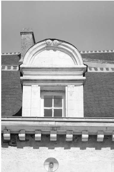
Façade principale, vue de détail de la lucarne. Phot. Guy Artur IVR53_19703500711V
