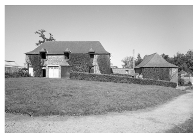
Vue générale. Phot. Guy Artur IVR53_19703500712V
