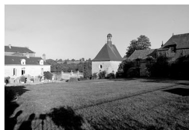
Cour intérieure, vue générale sud. Phot. Guy Artur IVR53_19703500704V
