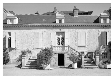
Façade principale, vue de détail du perron. Phot. Guy Artur IVR53_19703500717V
