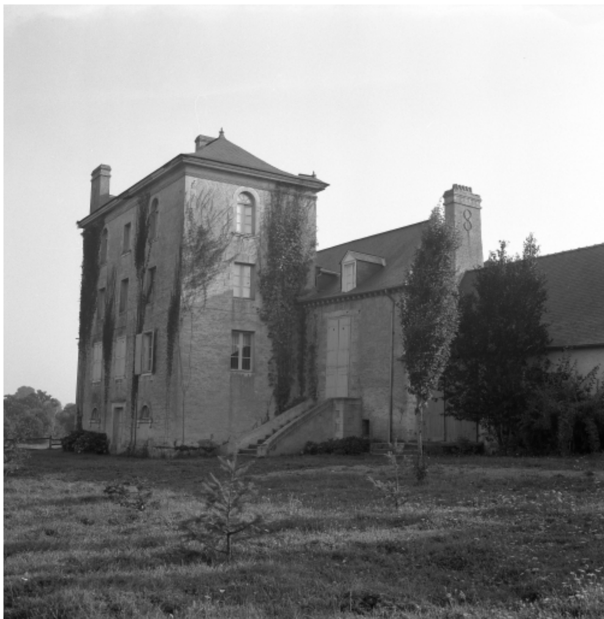
Corps de logis, vue nord est.
