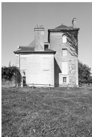
Corps de logis, élévation sud. Phot. Guy Artur IVR53_19703500705V
