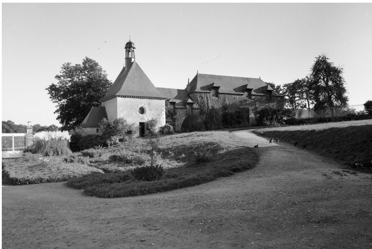
Cour intérieure, vue générale sud ouest.
