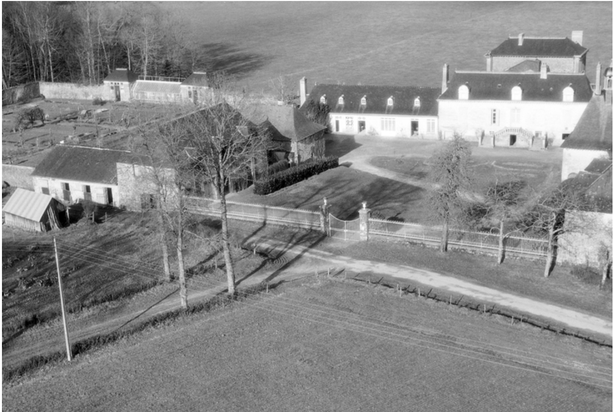
Vue aérienne sud ouest.
