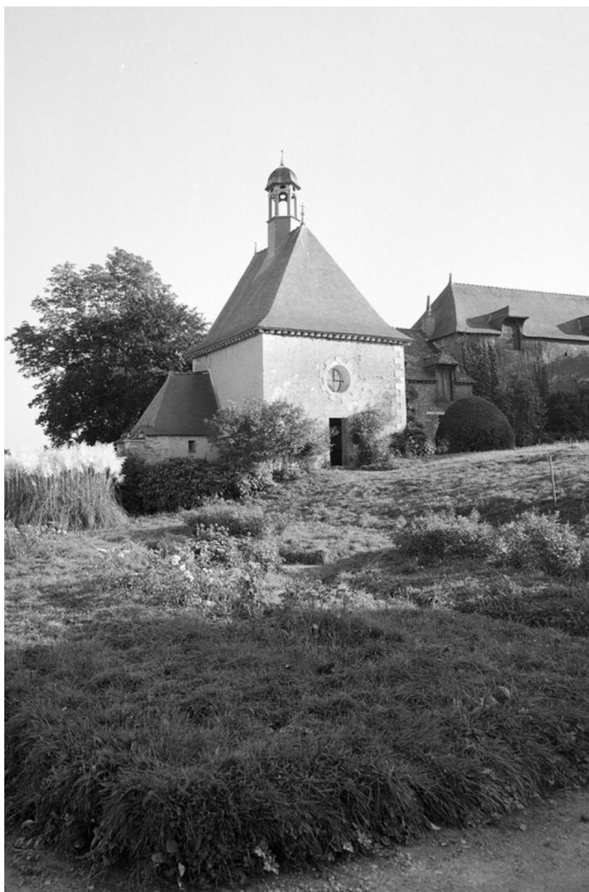
Chapelle, vue générale nord est.
