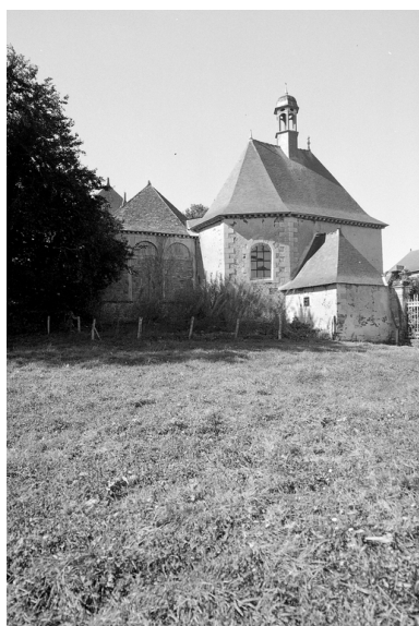
Chapelle, vue générale sud est. Phot. Guy Artur IVR53_19703500714V
