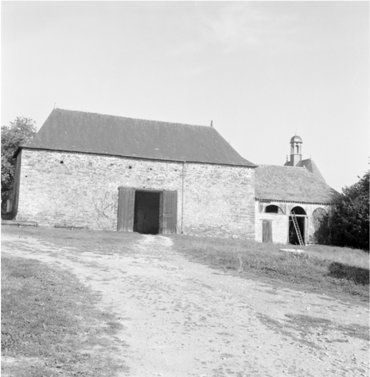
Dépendances, vue générale sud.
