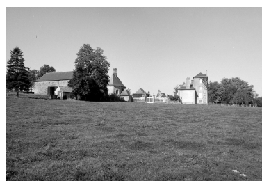
Vue de situation sud. Phot. Guy Artur IVR53_19703500708V
