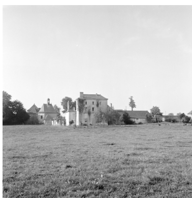
Vue de situation sud est. Phot. Guy Artur IVR53_19703500718X
