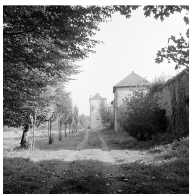
Vue générale nord.
