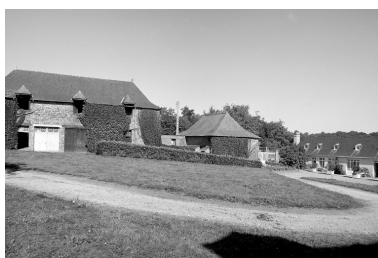
Cour intérieure, vue nord ouest. Phot. Guy Artur IVR53_19703500713V
