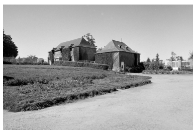
Cour intérieure, vue nord ouest. Phot. Guy Artur IVR53_19703500710V
