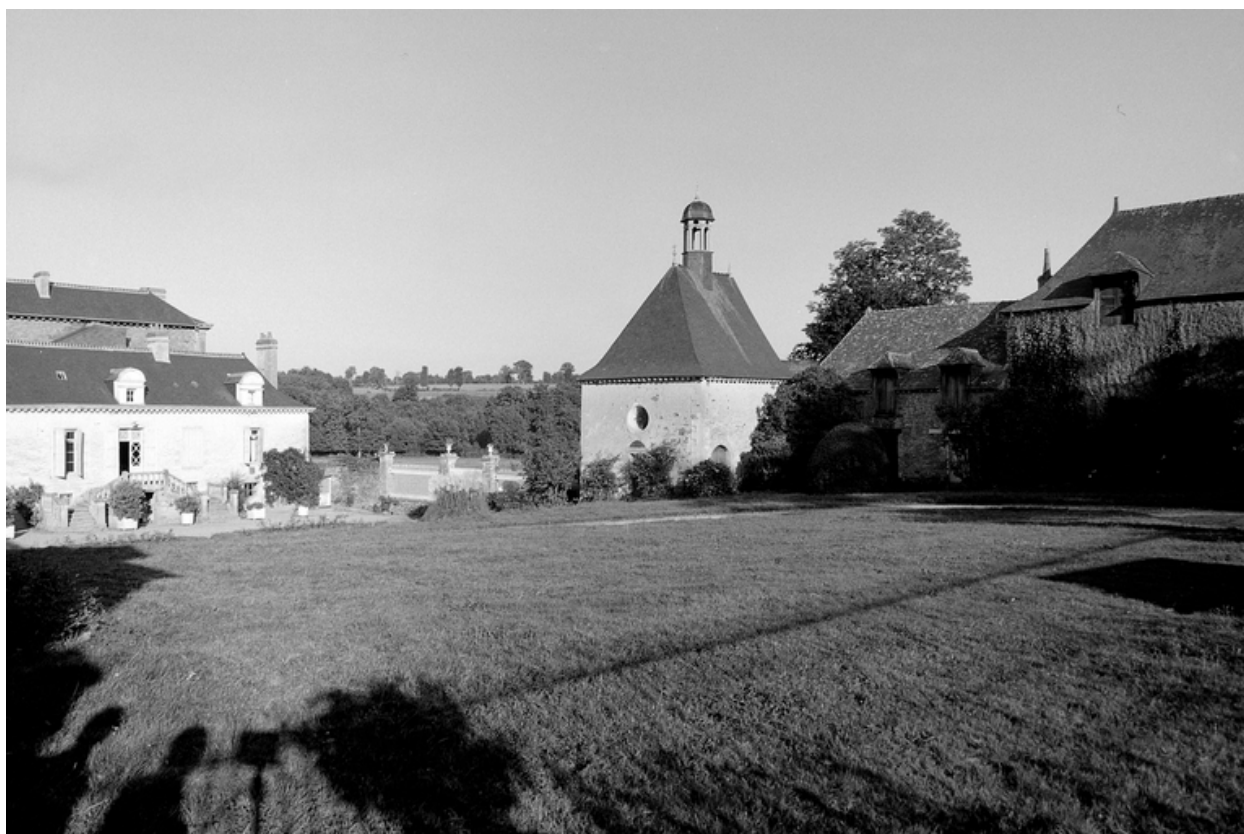
Cour intérieure, vue générale sud.
