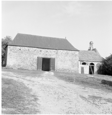
Dépendances, vue générale sud. Phot. Guy Artur IVR53_19703500720X
