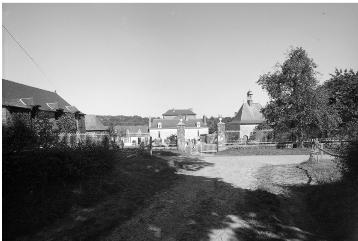
Vue de situation ouest.
