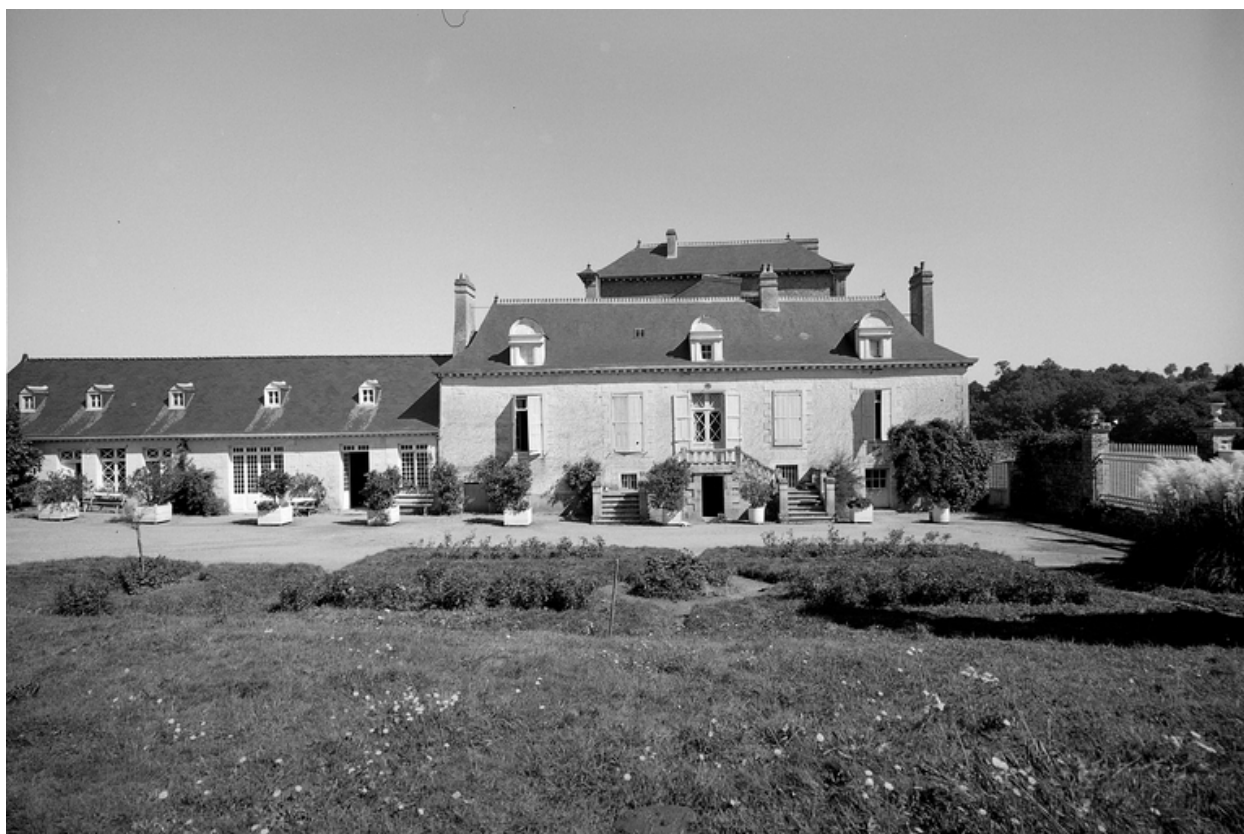
Façade principale, vue générale.
