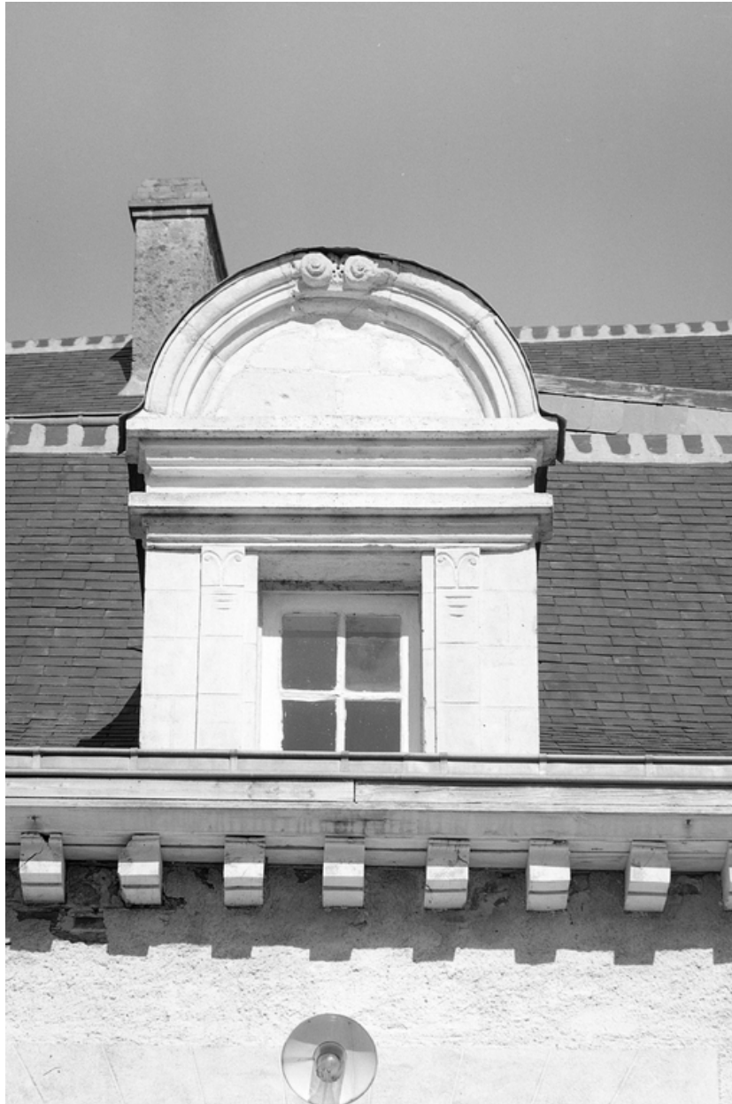
Façade principale, vue de détail de la lucarne.
