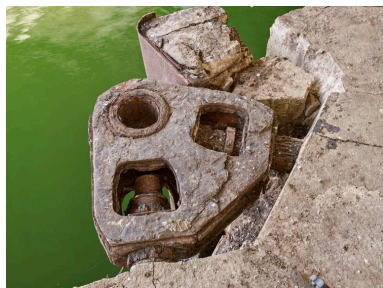
Vue de l'entrée de l'alvéole D : quai est n° 19, fixation haute de la porte d'écluse. Elle est maintenue par deux tiges filetées de réglage noyées dans le béton Phot. Bernard Bègne IVR53_20235600098NUCA
