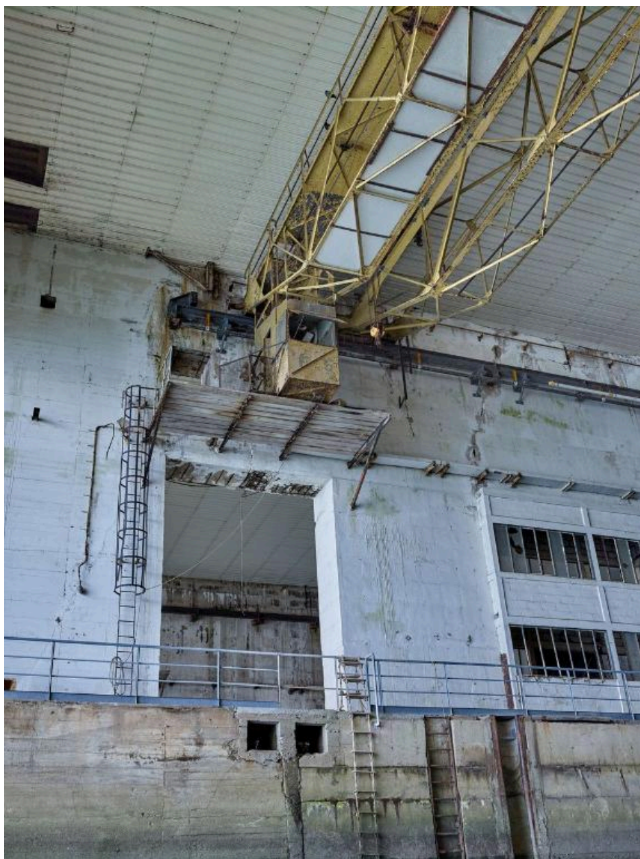
Vue de l'alvéole D : quai ouest n° 20 et pont roulant d'une capacité de 5 tonnes
