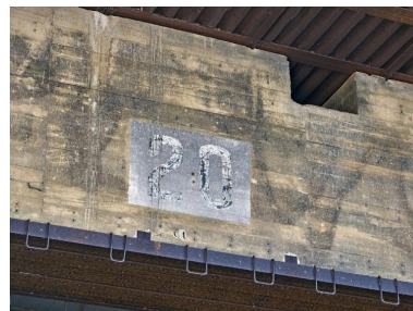
Vue de l'entrée de l'alvéole : numérotation du quai 20 sur le linteau (bassin abritant les emplacements 19, 19a et 20). On voit également les traces de la peinture camouflage Phot. Bernard Bègne IVR53_20235600584NUCA
