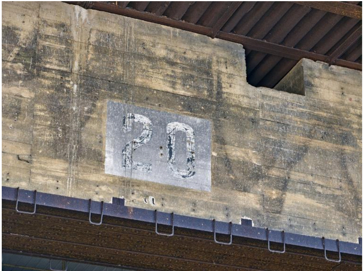
Vue de l'entrée de l'alvéole : numérotation du quai 20 sur le linteau (bassin abritant les emplacements 19, 19a et 20). On voit également les traces de la peinture camouflage
