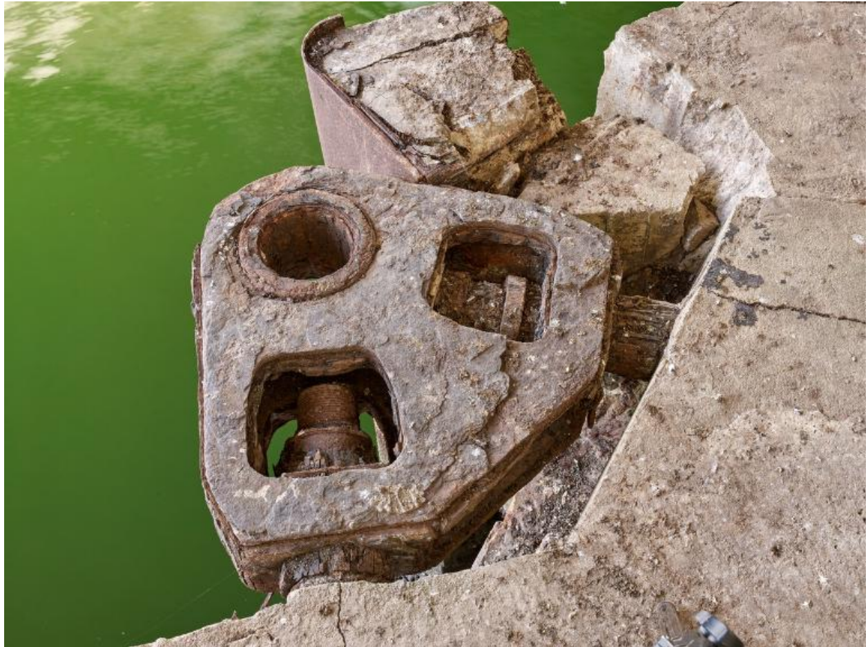
Vue de l'entrée de l'alvéole D : quai est n° 19, fixation haute de la porte d'écluse. Elle est maintenue par deux tiges filetées de réglage noyées dans le béton
