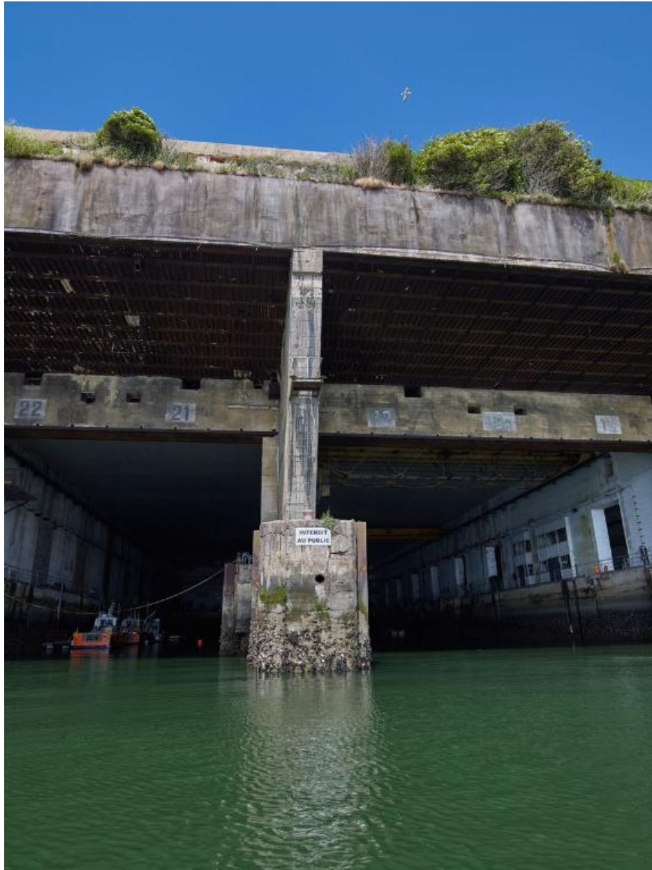
Vue de l'entrée des alvéoles C (n° 21 et 22) et D (n° 19, 19a et 20) : au centre, le contrefort du mur de refend
