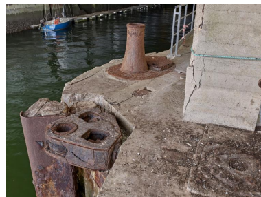
Vue de l'entrée de l'alvéole D : quai est n° 19 avec cabestan, fixation haute de la porte d'écluse. Elle est maintenue par deux tiges filetées de réglage noyées dans le béton Phot. Bernard Bègne IVR53_20235600099NUCA
