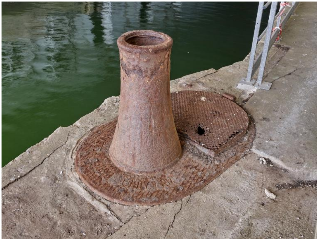
Vue de l'entrée de l'alvéole D : quai est n° 19 avec cabestan motorisé
