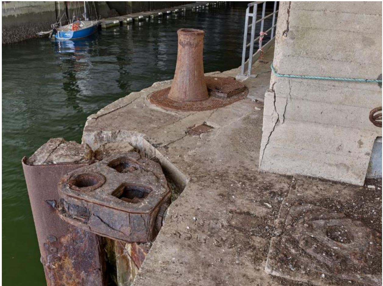
Vue de l'entrée de l'algéole D : quai est n° 19 avec cabestan, fixation haute de la porte d'écluse. Elle est maintenue par deux tiges filetées de réglage noyées dans le béton
