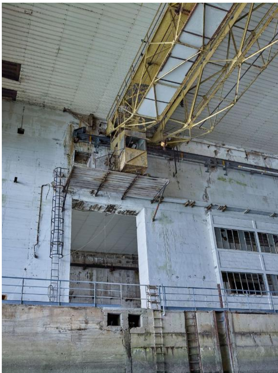
Vue de l'alcôve D : quai ouest n° 20 et pont roulant d'une capacité de 5 tonnes
