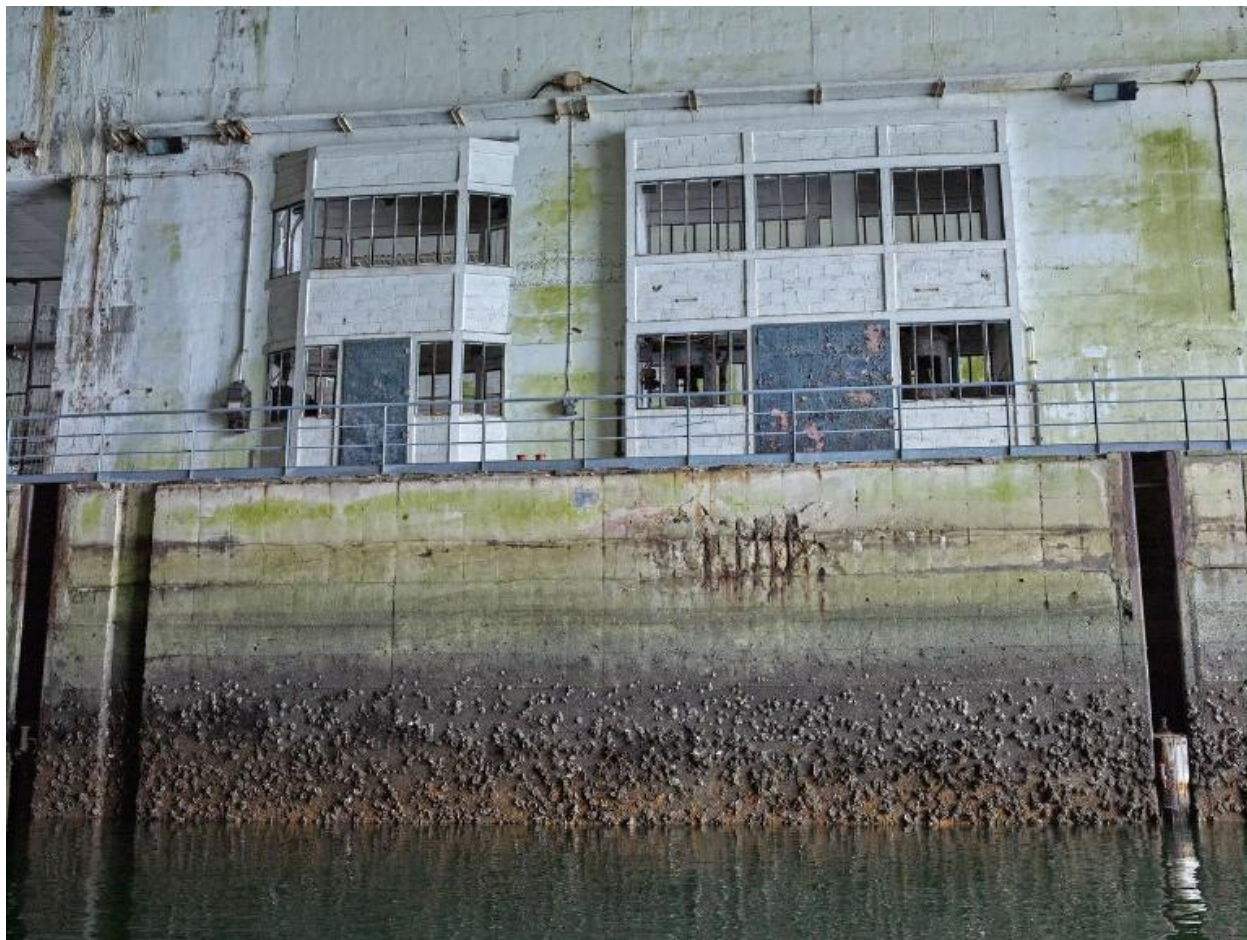
Vue de l'algéole D : quai est (quai n° 19). Dans l'épaisseur du mur de refend entre les algéoles D et E se trouvent les salles des pompes d'épuisement et d'assèchement
