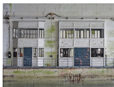
Vue générale des salles des pompes aménagées dans l'épaisseur du mur de refend entre les alvéoles D et E. Au premier plan, le quai n° 19 Phot. Bernard Bègne IVR53_20235600110NUCA
