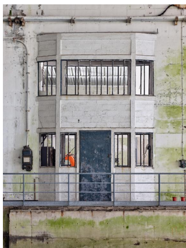
Vue de la salle des pompes aménagée dans l'épaisseur du mur
