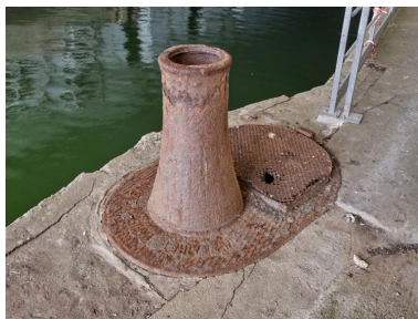
Vue de l'entrée de l'alvéole D : quai est n° 19 avec cabestan motorisé Phot. Bernard Bègne IVR53_20235600097NUCA
