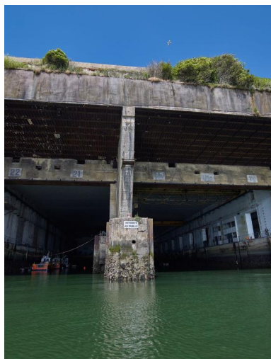
Vue de l'entrée des alvéoles C (n° 21 et 22) et D (n° 19, 19a et 20) : au centre, le contrefort du mur de refend Phot. Bernard Bègne IVR53_20215600504NUCA
