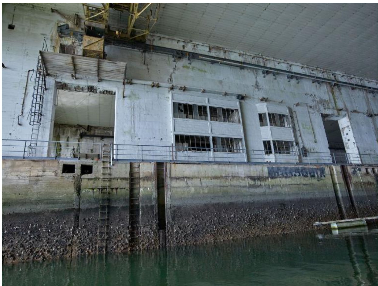
Vue de l'algéole D : quai ouest n° 20. Dans l'épaisseur du mur de refend entre les algéoles C et D se trouvent les salles des pompes d'épuisement et d'assèchement
