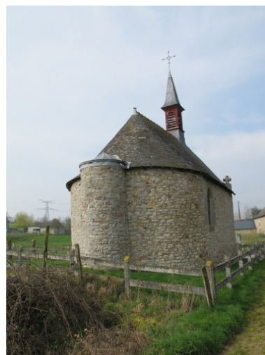
Vue nord-est Phot. Sabrina Dalibard IVR53_20113505717NUCA
