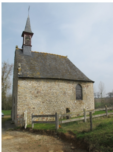
Vue générale sud Phot. Sabrina Dalibard IVR53_20113505716NUCA
