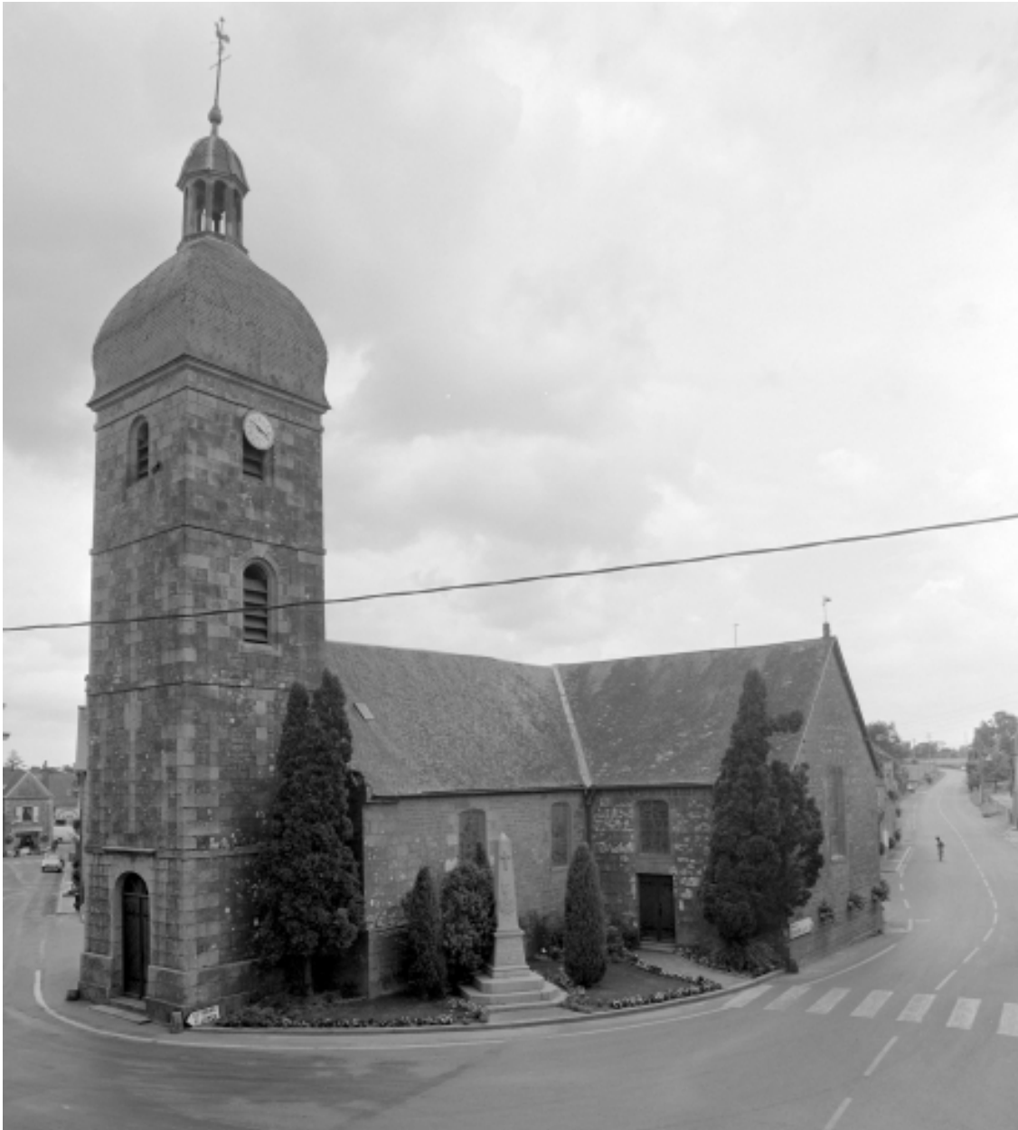
Elévation Sud-Ouest : vue générale
