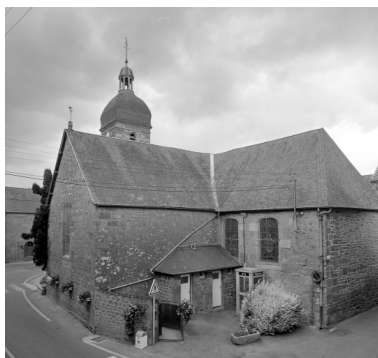
Elévation Sud-Est : vue générale Phot. Guy Artur, Phot. Norbert Lambart IVR53_19943501315X
