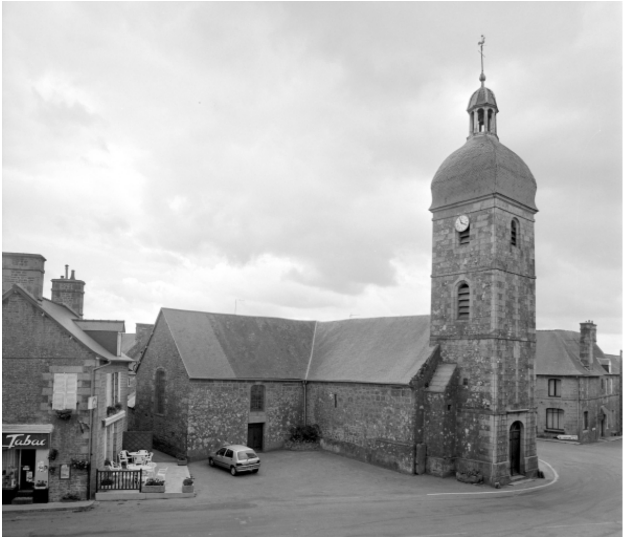
Elévation Nord-Ouest : vue générale
