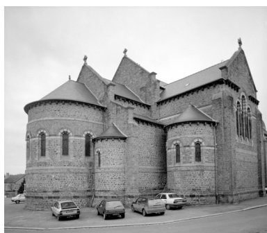
Elévation Sud-Est : vue générale Phot. Bernard Bègne, Phot. M. Loyon IVR53_19943500123X
