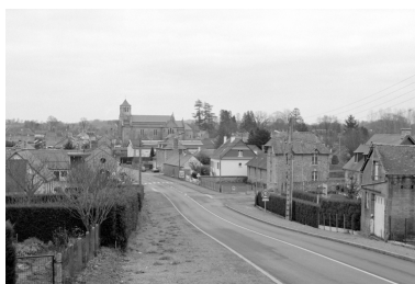
Elévation Ouest : vue de situation Phot. Bernard Bègne, Phot. M. Loyon IVR53_19943500128X
