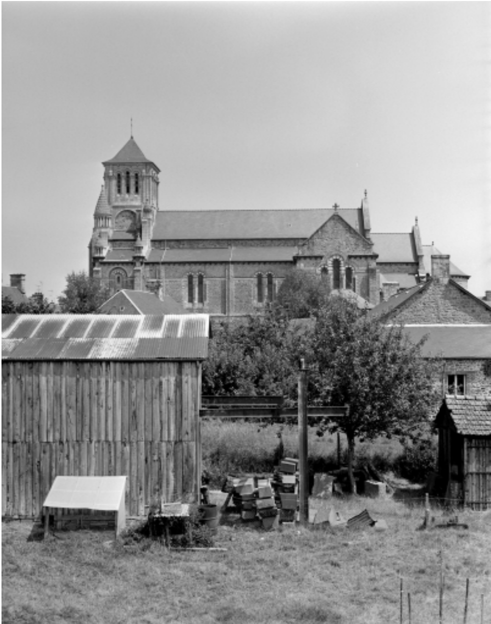
Elévation Ouest : vue générale
