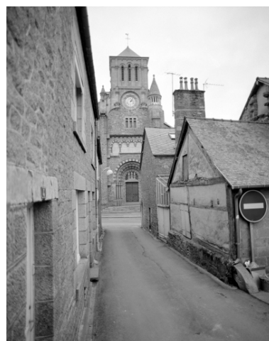
Elévation Nord : vue générale Phot. Bernard Bègne, Phot. M. Loyon IVR53_19943500125X
