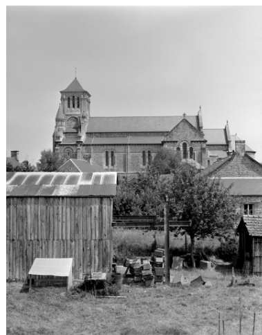
Elévation Ouest : vue générale
