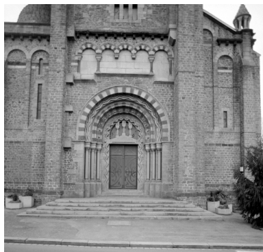
Elévation Nord, porte principale : vue générale Phot. Bernard Bègne, Phot. M. Loyon IVR53_19943500126X
