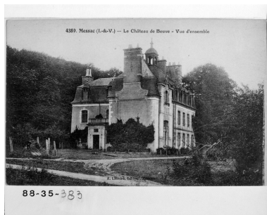
Vue générale depuis l'arrivée Repro. Guy Artur, Repro. Norbert Lambart, Autr. Alexandre Lamiré IVR53_19883500383X
