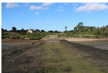
Vue générale depuis l'extrémité orientale. Le réservoir d'eau douce surplombe le site Phot. Guillaume Lécueillier IVR53_20242911153NUCA
