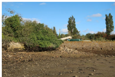
Vue de la liaison avec la parcelle agricole. Des murs de soutènement - partiellement ruiniformes - sont visibles à gauche Phot. Guillaume Lécueillier IVR53_20242911145NUCA
