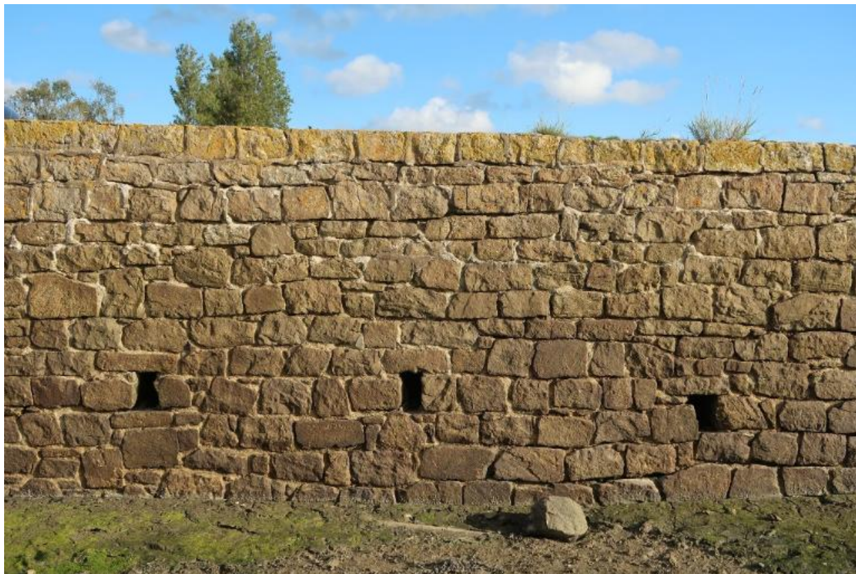
Vue de détail de l'élévation sud : maçonnerie de moellon de granite
