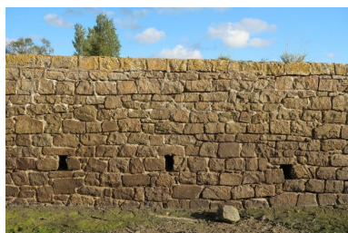
Vue de détail de l'élévation sud : maçonnerie de moellon de granite Phot. Guillaume Lécueillier IVR53_20242911147NUCA
