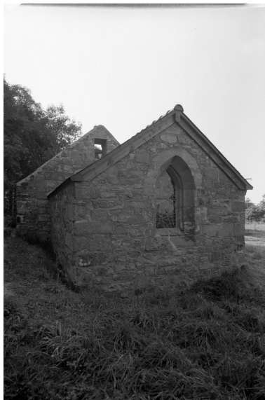
Vue générale prise de l'angle sud est Phot. Guy Artur IVR53_19712200131V
