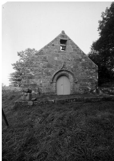
Face ouest : vue générale Phot. Guy Artur IVR53_19712200130V
