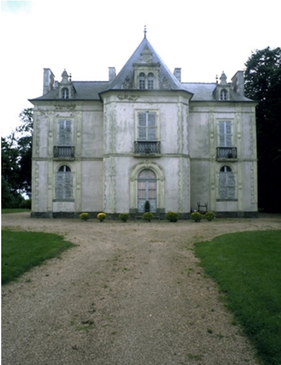
La façade principale : vue générale nord
