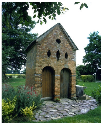
Latrines du château : vue générale est Phot. Guy Artur, Phot. Norbert Lambart IVR53_19993501281XA
