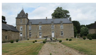
Vue générale sur cour Phot. Véronique Orain IVR53_20142209888NUCA
