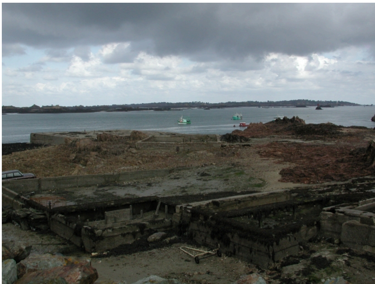
Vue des premiers viviers fixes à l'extérieur du port
