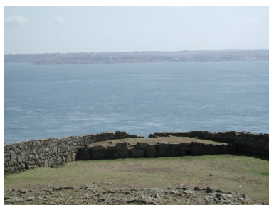
La batterie du fort de l'Île aux Moines Phot. Guy Prigent IVR53_20062208711NUCA
