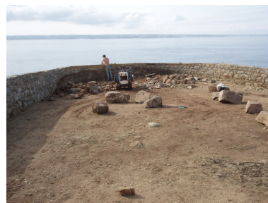
La poterne en cours de restauration (collection particulière) Phot. Guy Prigent, Autr. Nicole Bihan IVR53_20072205700NUCB
