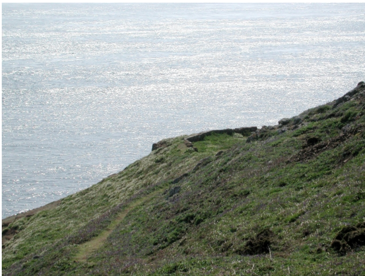
Vue de la batterie sud-ouest de l'Ile aux Moines, comportant une niche à munitions datant de la guerre 1914-18
