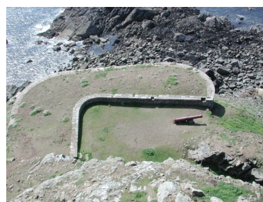
La grande batterie au nord du fort et son mur défensif : la batterie du Veau Phot. Guy Prigent IVR53_20062208712NUCA
