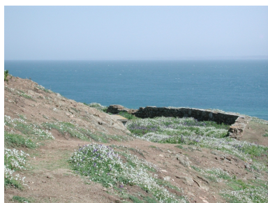
Vue de la batterie de côte au sud de l'Île aux Moines Phot. Guy Prigent IVR53_20062208837NUCA
