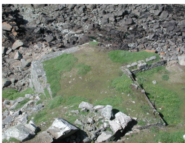
Site de la batterie nord-ouest : vestiges de la plate-forme qui défendait le chenal entre l'Île aux Moines et l'Île Plate Phot. Guy Prigent IVR53_20062208713NUCA
