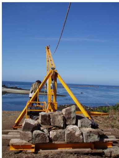
Utilisation d'une grue treuil en aplomb de la falaise (collection particulière) Phot. Guy Prigent, Autr. Nicole Bihan IVR53_20072205702NUCB
