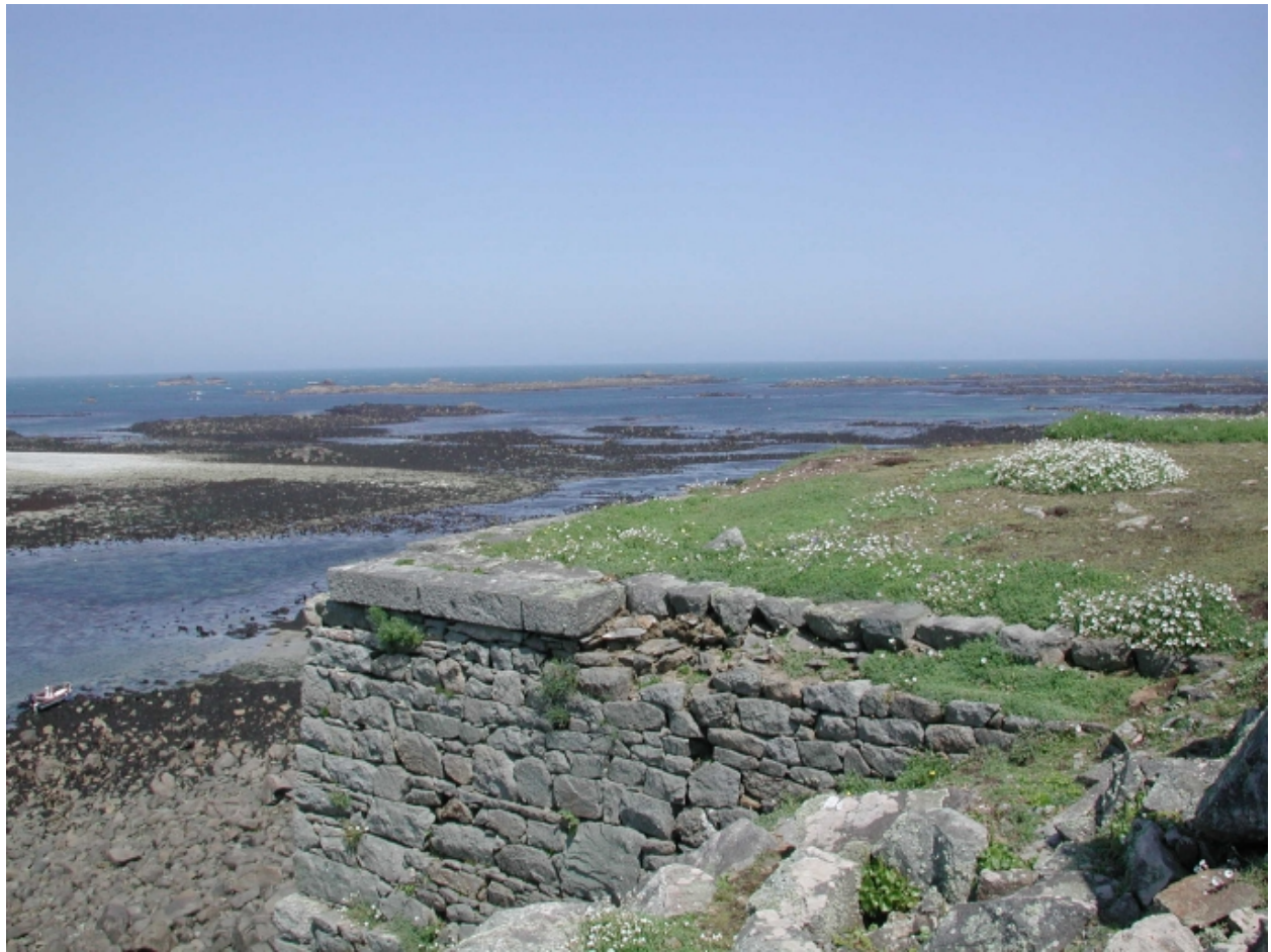
Vue générale du site de la batterie n° 2, au nord-ouest de l'Île aux Moines
