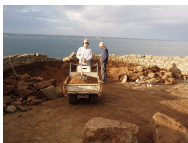
Acheminement des matériaux (collection particulière) Phot. Guy Prigent, Autr. Nicole Bihan IVR53_20072205699NUCB
