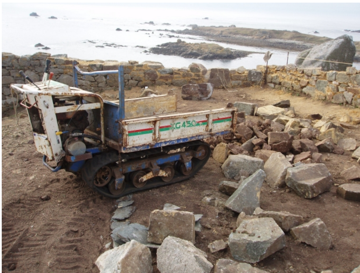
Utilisation d'un transporteur à chenilles (collection particulière)
