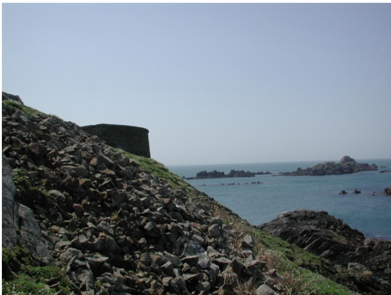
Vue générale de la batterie nord-est de l'Île aux Moines et au 1er plan : déchets de carrière
