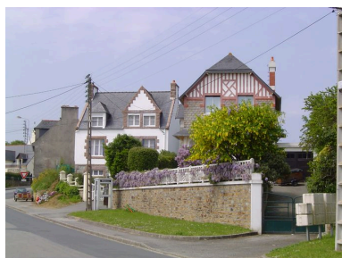
Vue générale des villas de l'entrée du Fret Phot. Clotilde Buhot IVR53_20062908541NUCA
