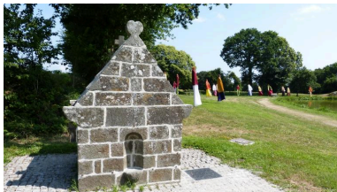
Vue sud de la fontaine Saint Fiacre (Les Iffs) Phot. Laurence Marquet IVR53_20253510436NUCA
