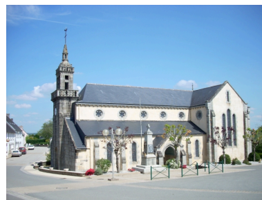
Vue générale sud-ouest, état en 2008. Phot. Gwénaél Fauchille IVR53_20082905830NUCA
