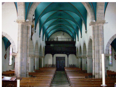
Vue axiale ouest. Phot. Gwénaél Fauchille IVR53_20082905834NUCA
