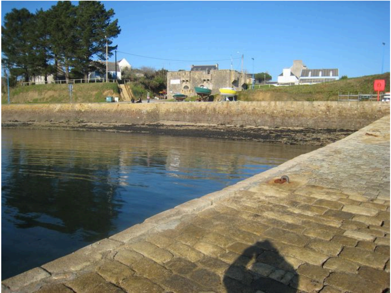
Partie du débarcadère au fond du port
