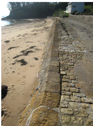
Partie du débarcadère au fond du port Phot. Françoise Péron IVR53_20072908930NUCA
