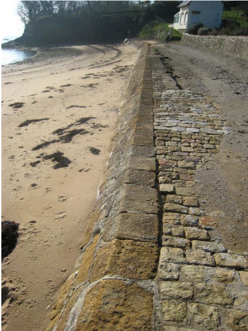
Partie du débarcadère au fond du port
