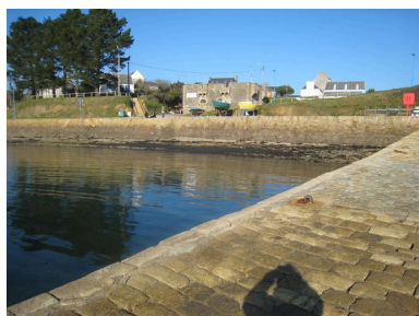
Partie du débarcadère au fond du port Phot. Françoise Péron IVR53_20072908928NUCA
