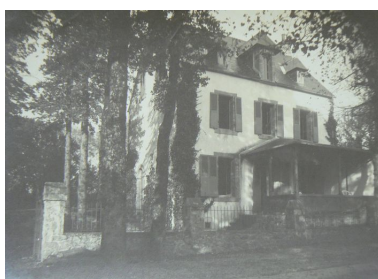
Vue ancienne de la villa Les Ormes Phot. Archives municipales de Brest IVR53_20072908644NUC
