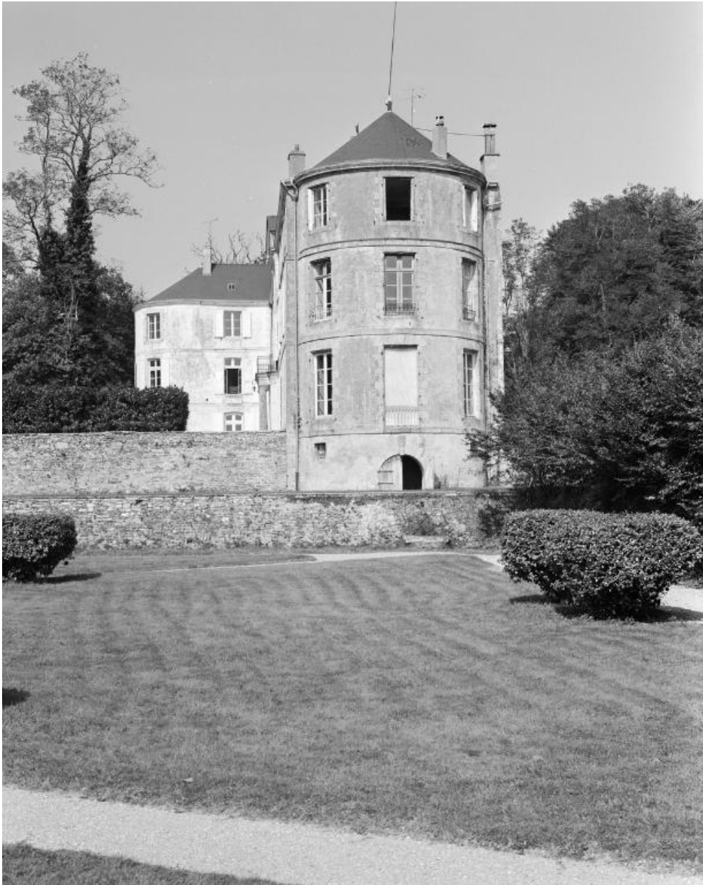
Château, élévation sud.
