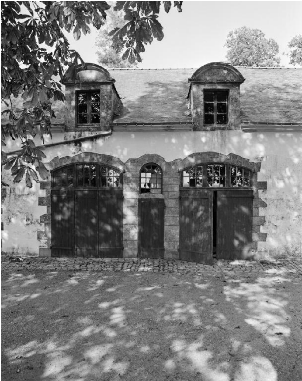
Château, écuries, élévation sud, partie centrale.
