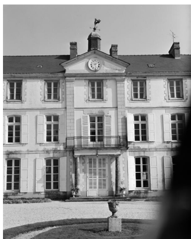
Château, élévation ouest, partie centrale. Phot. Guy Artur, Phot. Norbert Lambart IVR53_19885601309X
