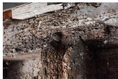
Deuxième étage, cheville maintenant un assemblage à tenon et mortaise.
