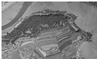
Vue aérienne de la pointe de Cesson avant la construction du polder du port de commerce du Légué (15/07/1951) Repro. Erwana L'Haridon IVR53_20262210048NUCB
