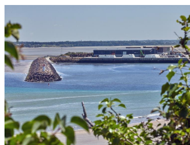
Le port de commerce du Légué et la jetée de Cesson Phot. Bernard Bègne IVR53_20262200554NUCA
