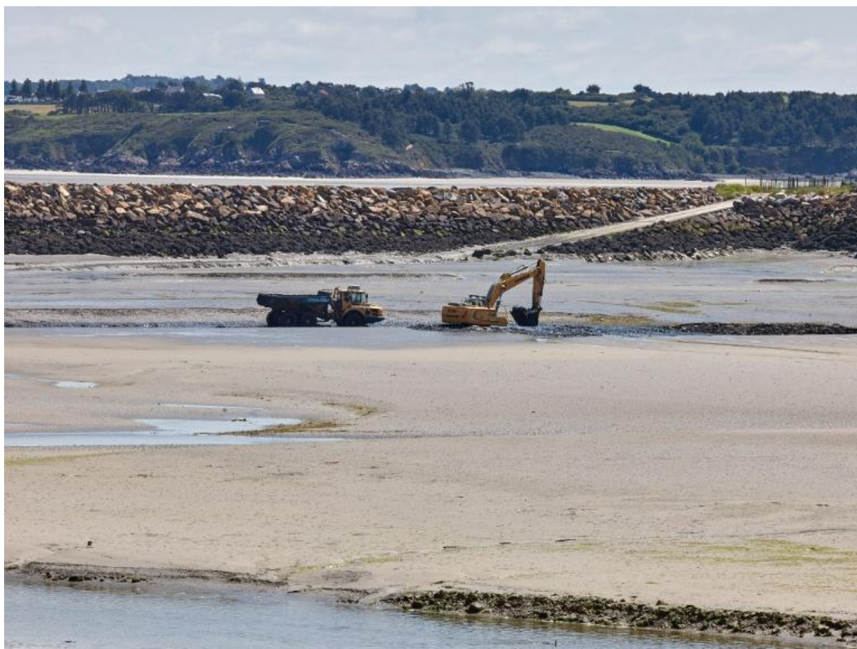
Intervention de dragage sur le chenal
