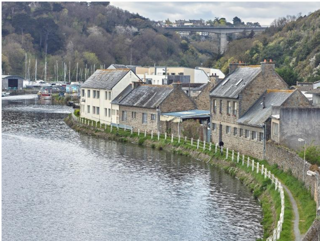
Les bâtiments de l'ancien centre technique et le bassin à flot, en arrière-plan de viaduc de la R.N.12
