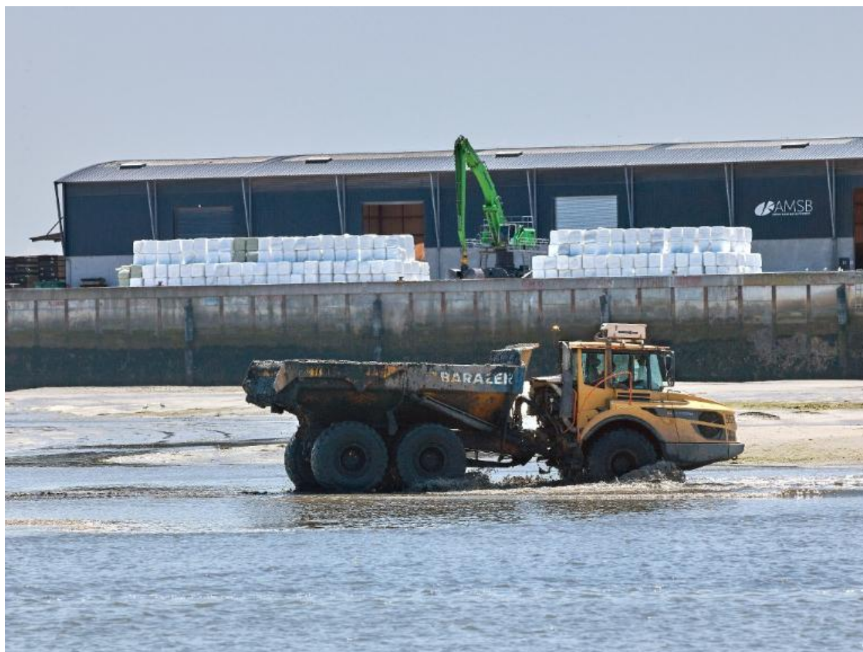
Intervention sur le chenal
