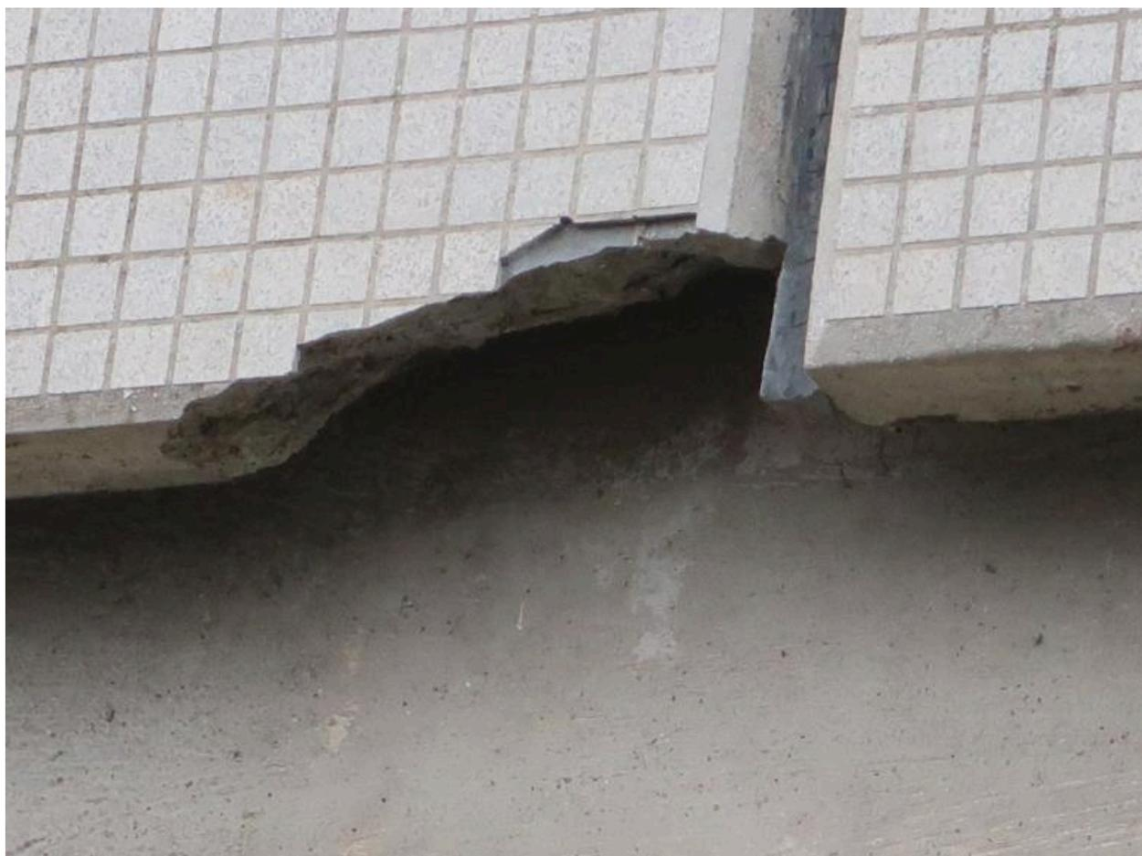
Détail de la modénature d'une barre de 1966 : panneau de béton préfabriqué recouvert de carreaux de grès.
