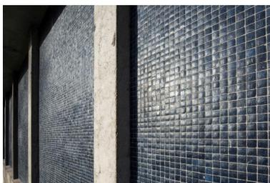
Détail de la modénature, poteaux de béton brut et panneaux de béton recouverts de mosaïques de grès : bâtiment E (externat, ancien internat des filles), pignon sud-est.
