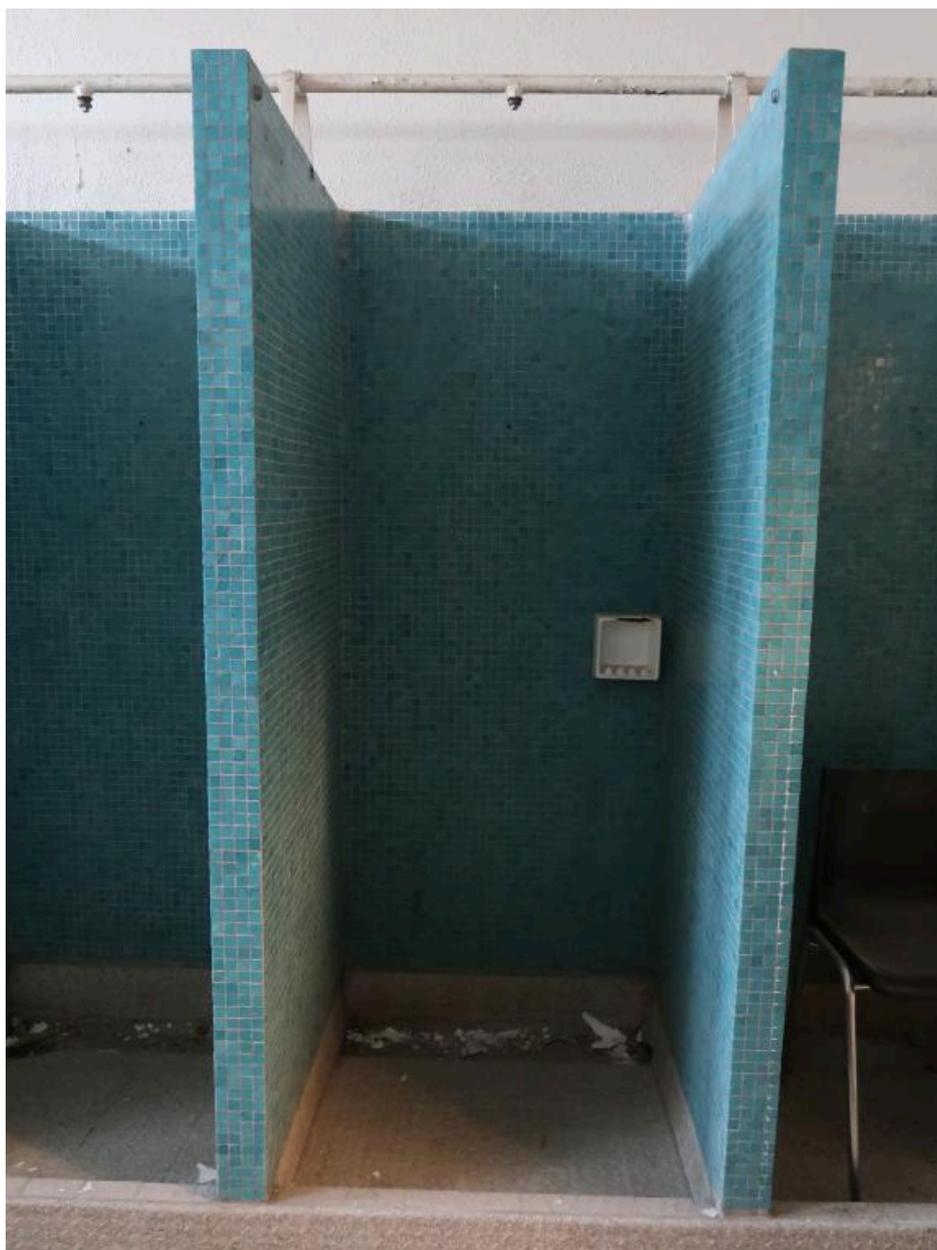
Détail sur une cellule de douche dans l'ancien internat de garçons. Probablement en l'état d'origine. Noter l'unique réseau de distribution et d'évacuation des eaux usées..
