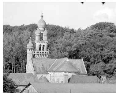
Elévation Sud : vue générale Phot. Guy Artur, Phot. Norbert Lambart IVR53_19923500721X
