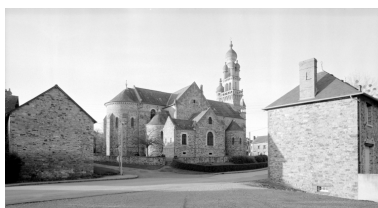
Elévation Sud-Ouest : vue générale Phot. Bernard Bègne IVR53_19943500153X
