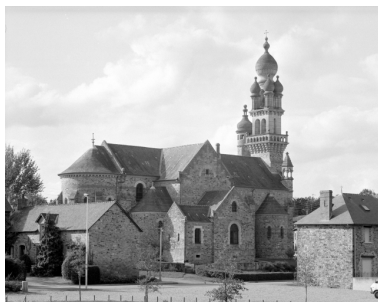
Elévation Sud-Est : vue générale Phot. Bernard Bègne IVR53_19923500720X
