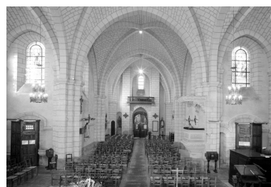
Intérieur, nef : vue générale. Phot. Bernard Bègne IVR53_19943500150X
