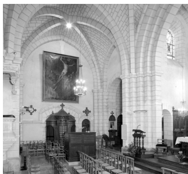
Elévation Sud-Ouest : vue générale Phot. Bernard Bègne IVR53_19943500151X
