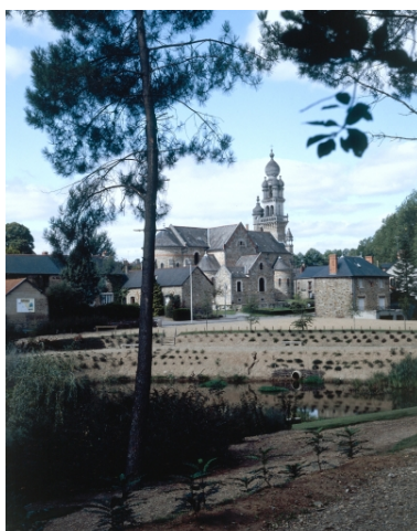
Elévation Ouest : vue générale Phot. Bernard Bègne IVR53_19953500007XA
