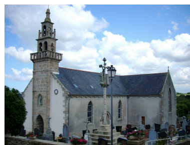
Tréglonou, église paroissiale : vue générale sud-ouest Phot. Gwénaél Fauchille IVR53_20082906140NUCA
