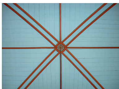
Tréglonou, église paroissiale : détail du lambris à la croisée du transept Phot. Gwénaél Fauchille IVR53_20082906144NUCA
