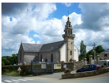
Tréglonou, église paroissiale : vue générale nord-ouest Phot. Gwénaél Fauchille IVR53_20082906139NUCA
