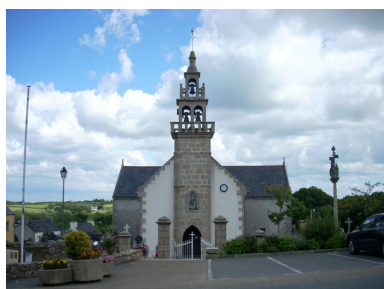
Tréglonou, église paroissiale : élévation ouest Phot. Gwénaél Fauchille IVR53_20082906138NUCA
