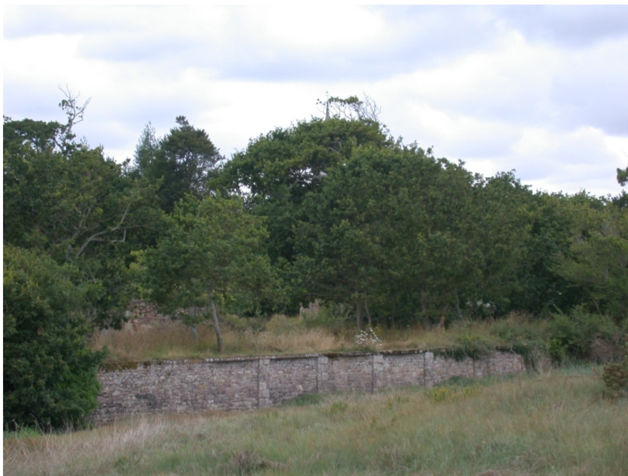
Vue du mur de soutènement de l'ancienne voie ferrée
