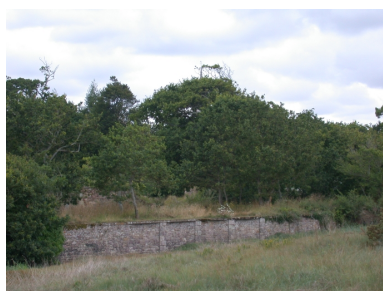
Vue du mur de soutènement de l'ancienne voie ferrée Phot. Guy Prigent IVR53_20092212631NUCA
