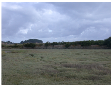
Vue du mur intérieur de quai qui endigue une partie de l'ancien port de Beauport-Cruckin Phot. Guy Prigent IVR53_20092212642NUCA
