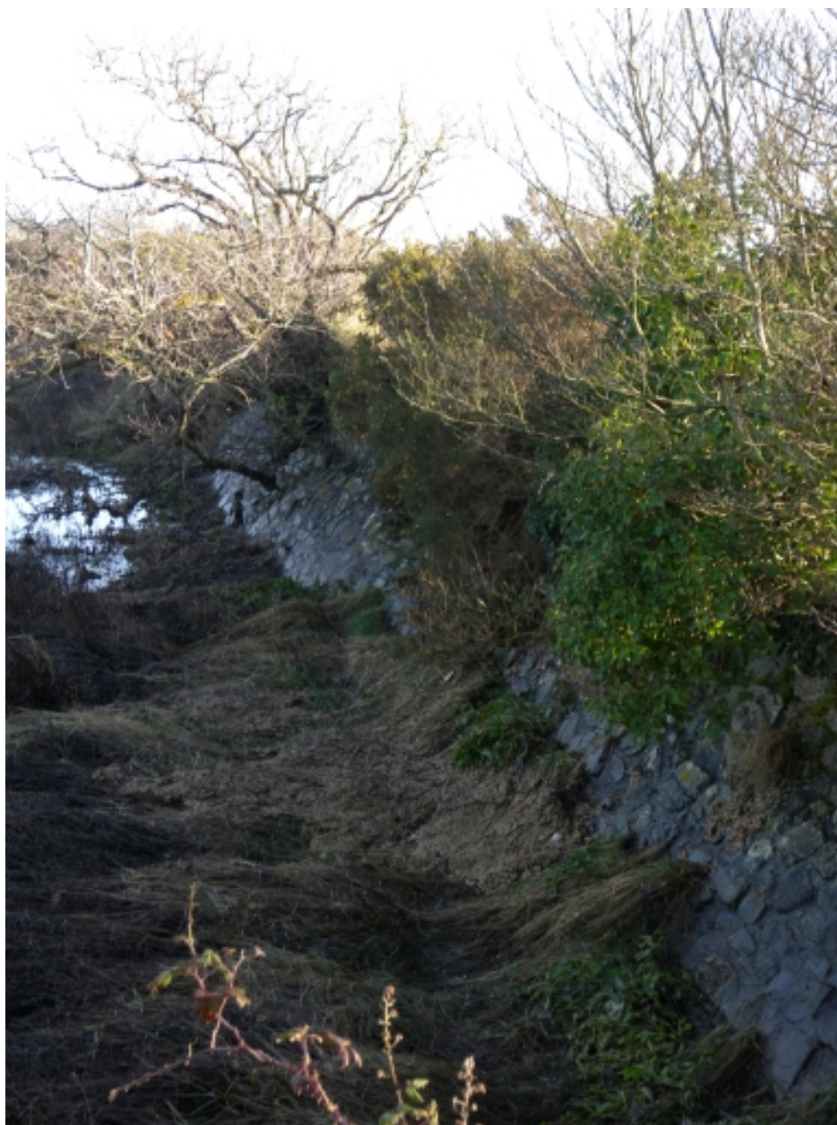
Vue du mur intérieur de quai avec un fruit assez prononcé du bassin de Beauport, à usage de port
