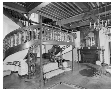
Vue générale du hall d'entrée après restauration. Phot. Guy Artur IVR53_19973502142X
