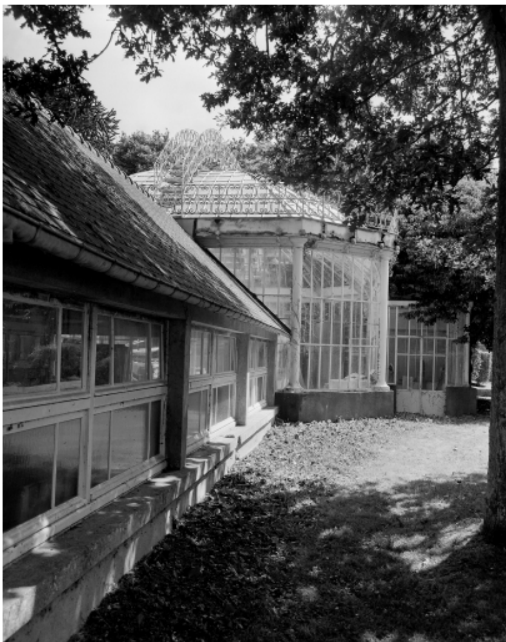
Au sud de la parcelle : vue de la serre - solarium.
