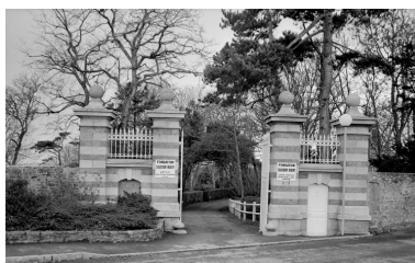
Vue générale du portail d'entrée du château. Phot. Guy Artur IVR53_19973502097X
