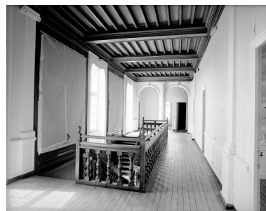
Palier du premier étage vue d'ensemble d'est vers ouest. Phot. Guy Artur IVR53_19963501331X
