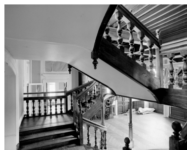
Escalier central du hall d'entrée, palier de repos et 2e volée. Phot. Guy Artur IVR53_19963501328X
