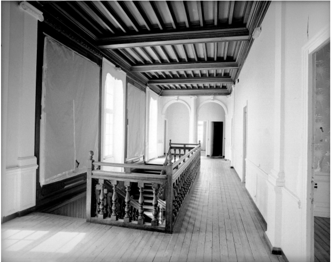
Palier du premier étage vue d'ensemble d'est vers ouest.
