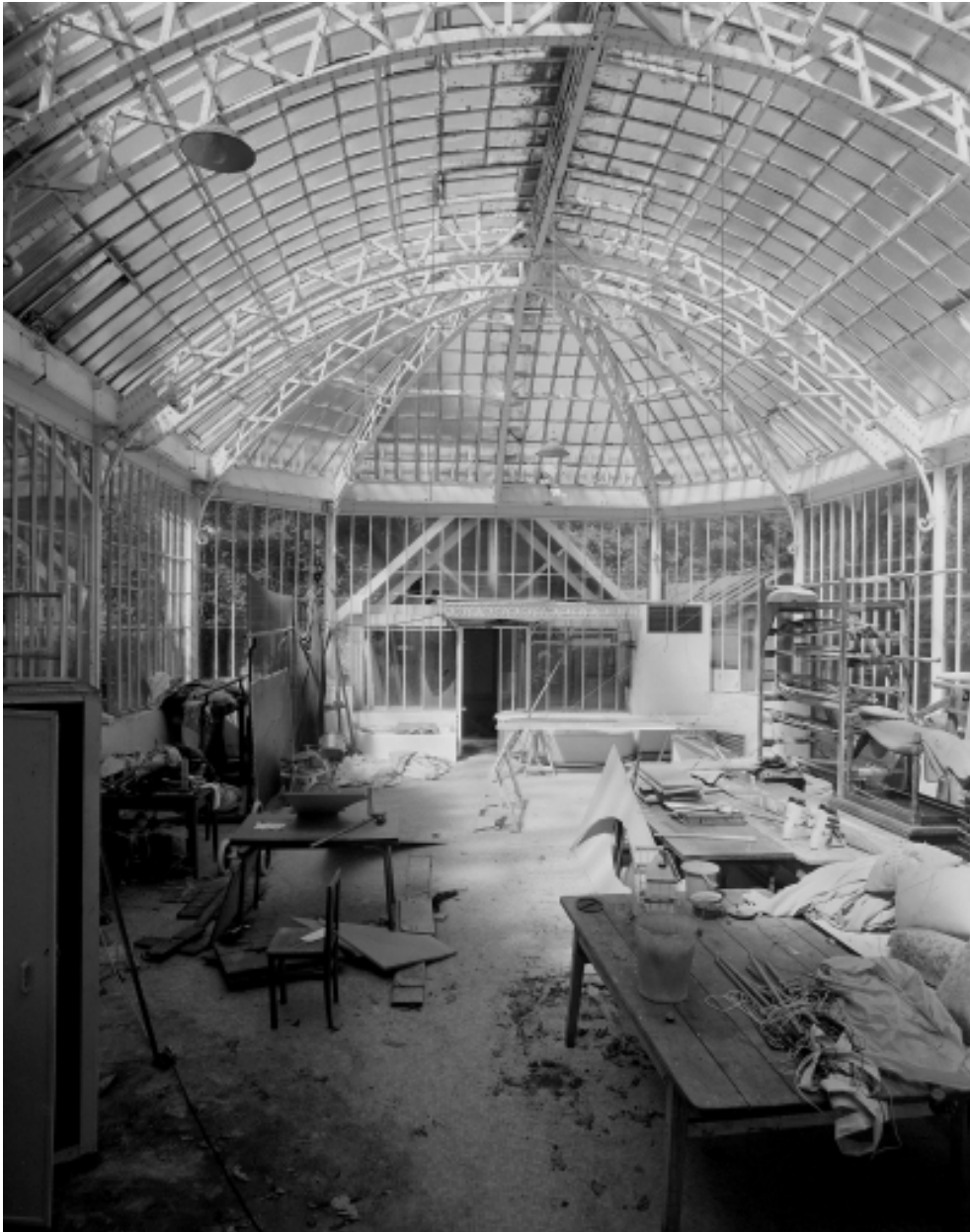
Vue intérieure de la serre (parcelles n°9 et 10, section A 1982).
