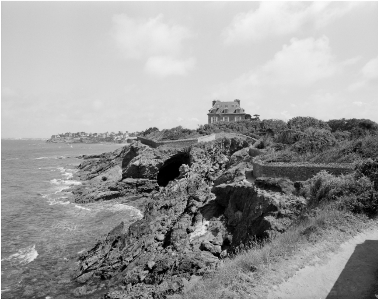
Vue de situation prise de l'ouest, chemin côtier.
