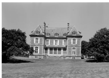
Vue générale de la façade sud-ouest sur jardin. Phot. Guy Artur, Phot. Norbert Lambart IVR53_19963501188X
