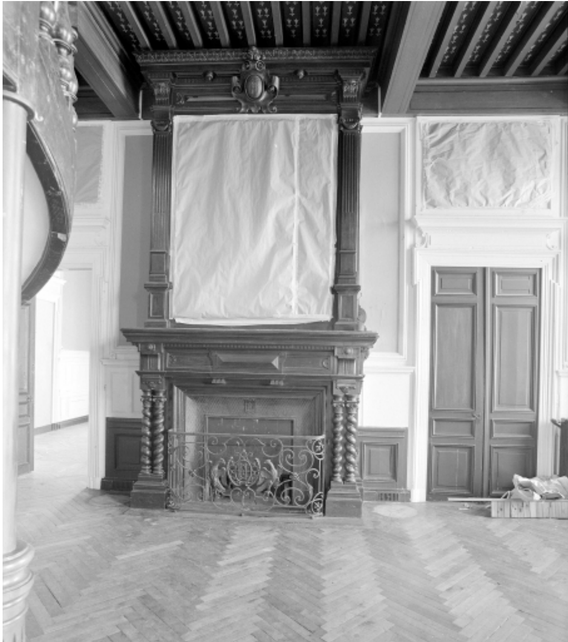
Vue générale de la cheminée de la grande salle.
