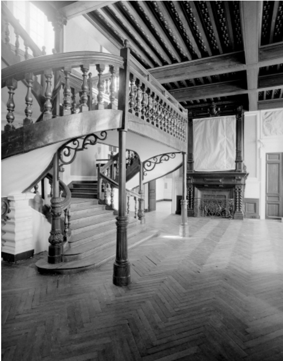
Escalier central du hall d'entrée avant restauration.
