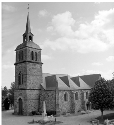
Elévation Sud-Ouest : vue générale Phot. Guy Artur, Phot. Norbert Lambart IVR53_19943501336X
