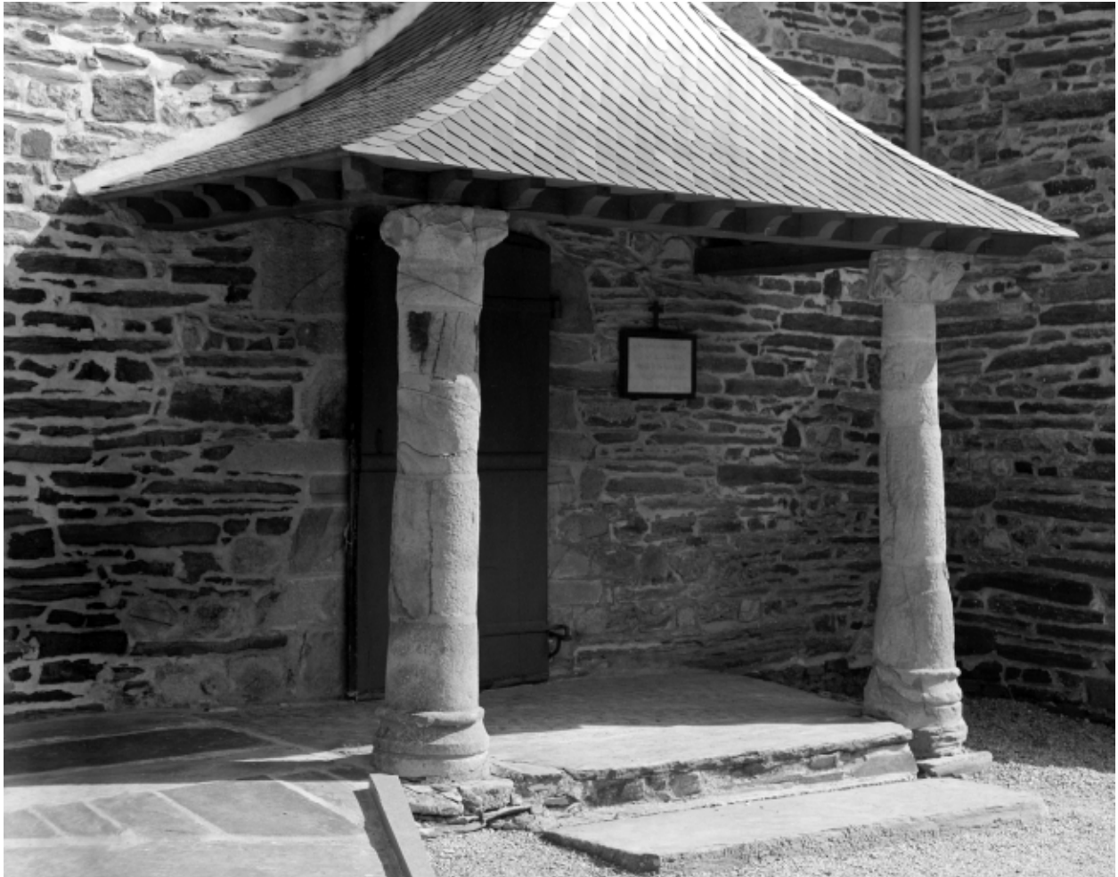
Elévation Sud, porte : vue générale
