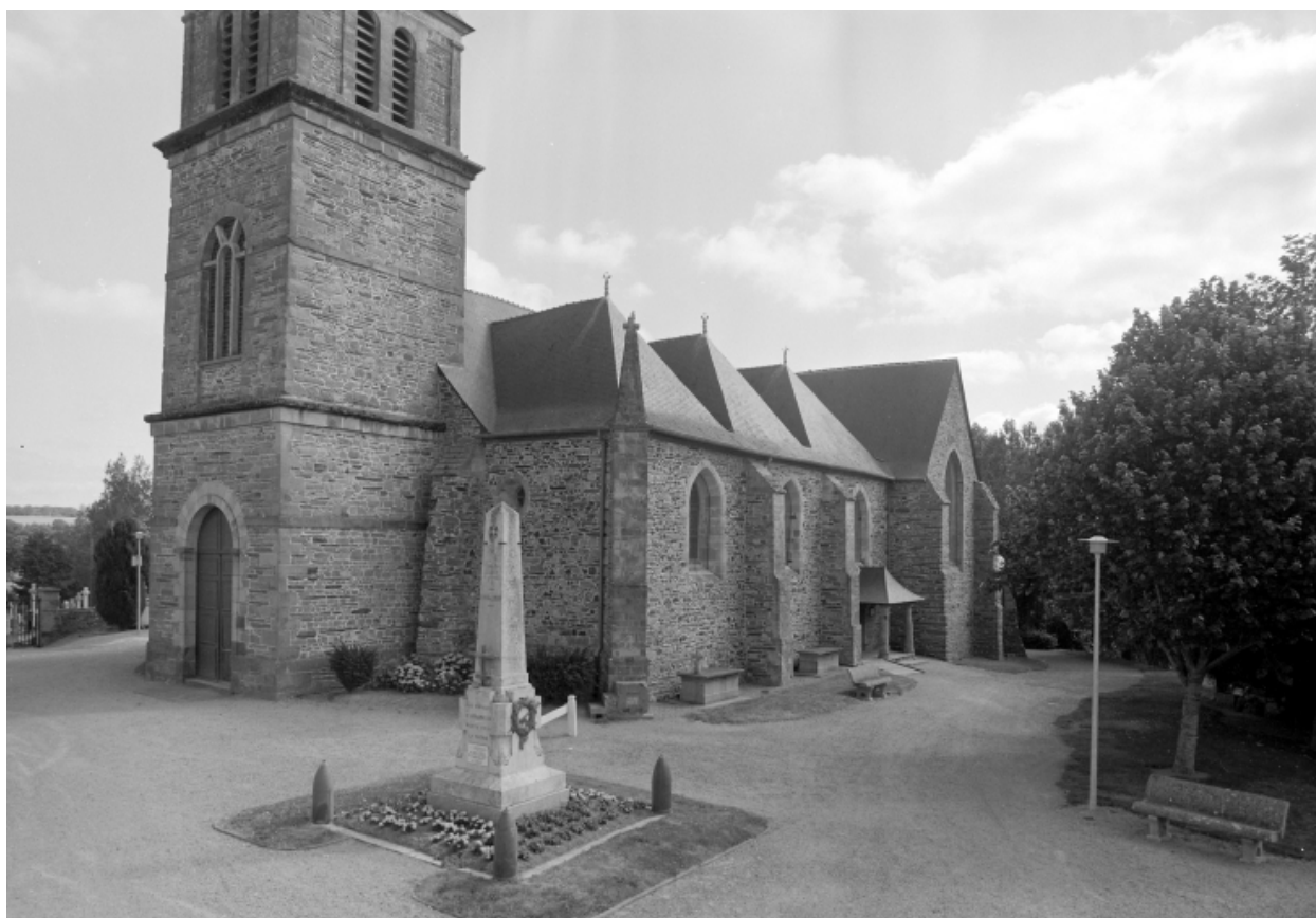
Elévation Sud : vue générale
