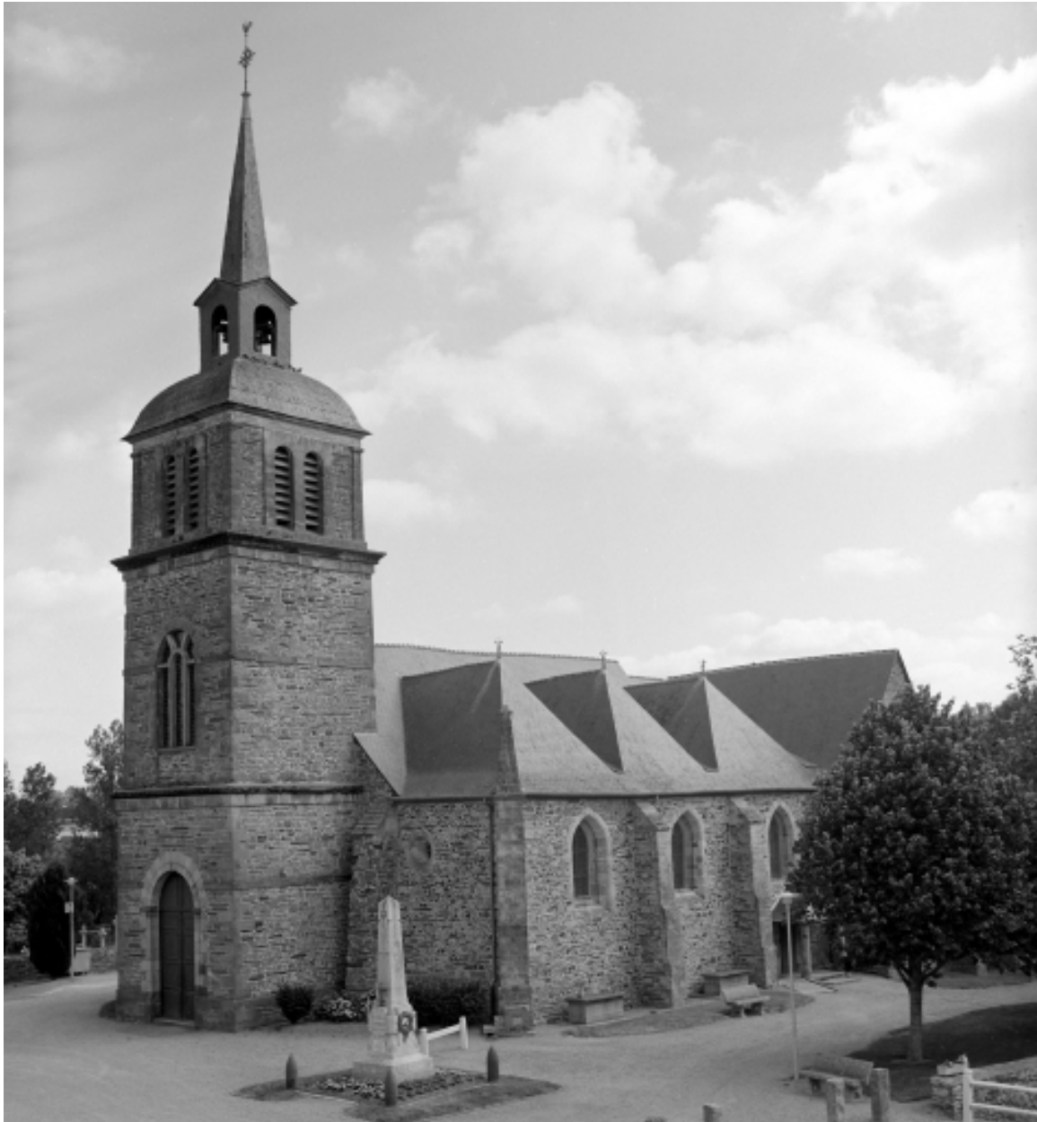
Elévation Sud-Ouest : vue générale
