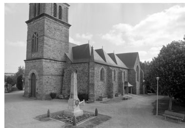
Elévation Sud : vue générale Phot. Guy Artur, Phot. Norbert Lambart IVR53_19943501337X
