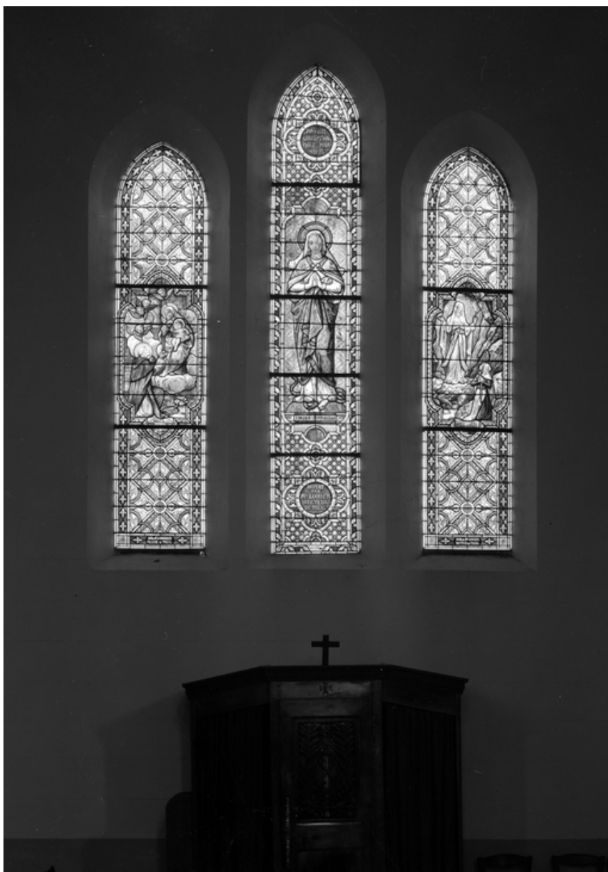
Verrières du bras nord du transept (état en 1983)
