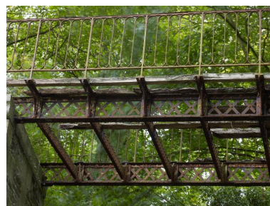
Passerelle métallique. Tablier vu du dessous : poutres rivetées fixées sur les poutres en treillis Phot. Bernard Bègne IVR53_20142201528NUCA
