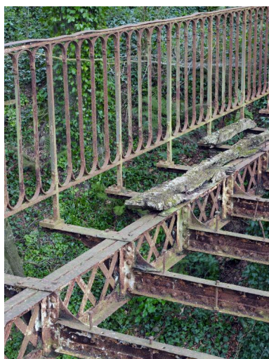
Passerelle métallique. Détail du parapet fixé à la poutre en treillis Phot. Bernard Bègne IVR53_20152200432NUCA
