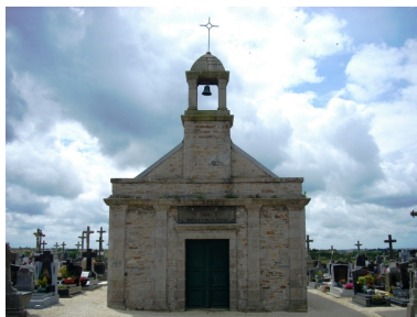
Plouguerneau, chapelle du cimetière : élévation ouest Phot. Gwénaél Fauchille IVR53_20082906107NUCA
