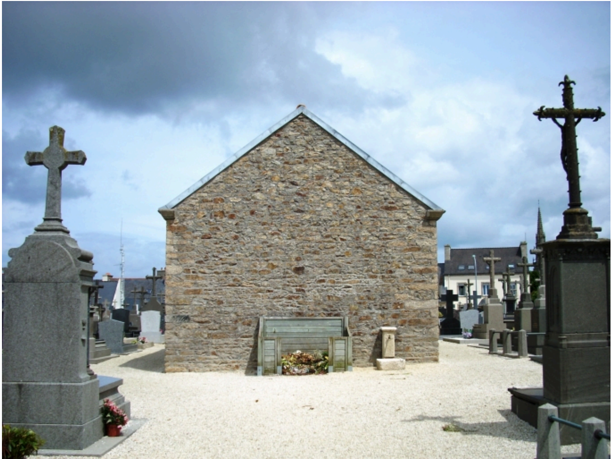
Plouguerneau, chapelle du cimetière : élévation est
