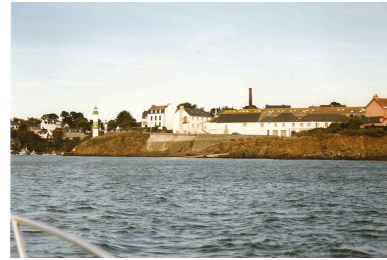
Vue depuis la mer de la zone d'activité portuaire industrielle liée à l'ancienne conserverie Capitaine Cook Phot. Evelyne Dumont IVR53_20082908684NUCA
