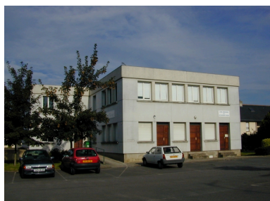
Ancien presbytère Phot. Aline Carpentier IVR53_20013522561NUCA
