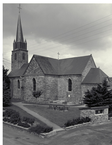
Vue générale sud-est Phot. Guy Artur, Phot. Norbert Lambart IVR53_19943501040X
