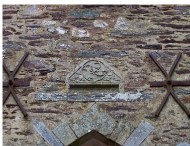
Pierre de remploi au dessus du portail : détail Phot. Xavier Gilbert IVR53_19993504149NUCA
