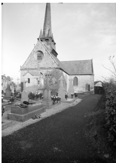
Elévation ouest : vue de situation
