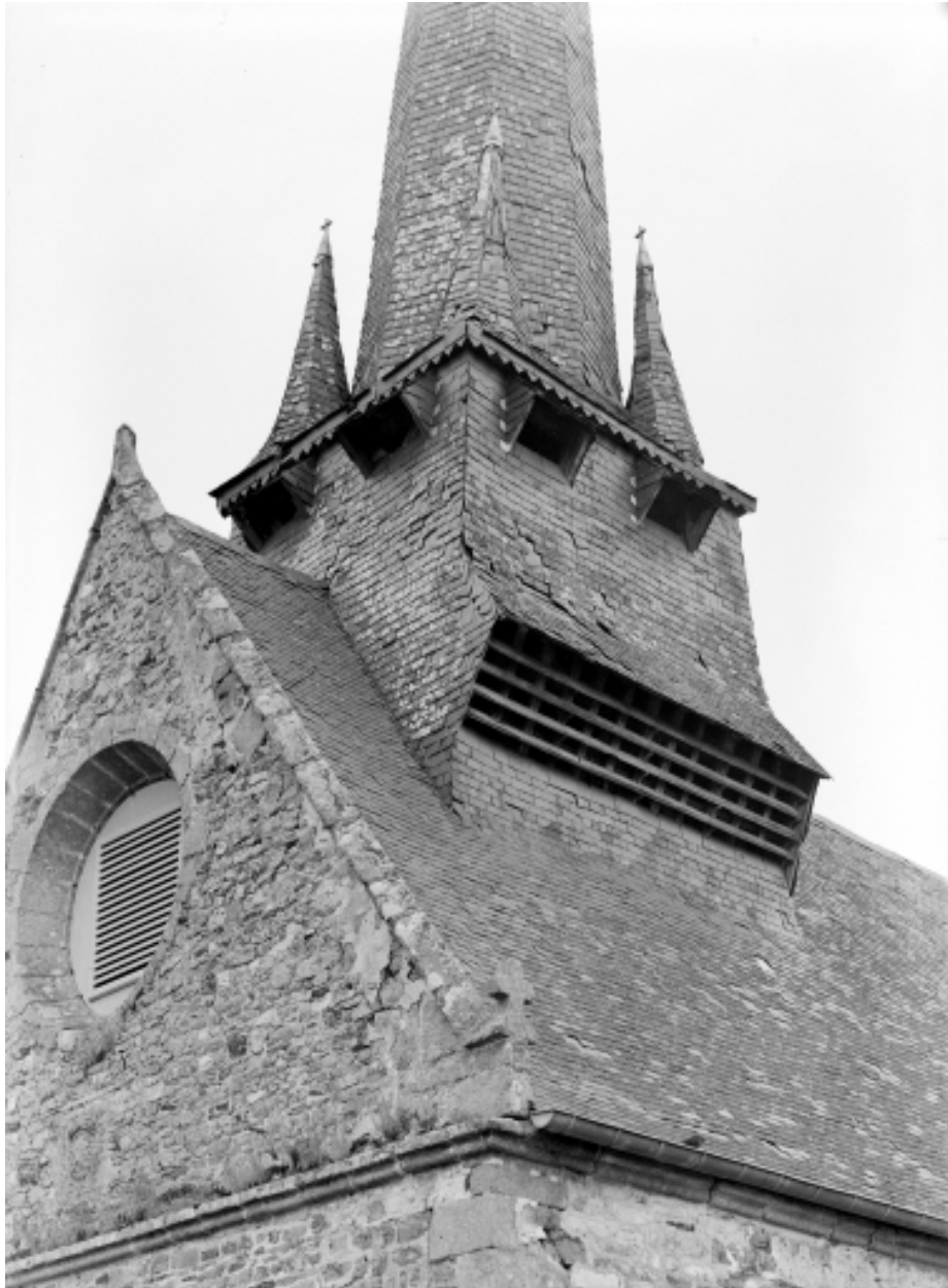
Clocher, chambre des cloches, partie sud-ouest : vue générale
