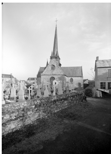
Elévation ouest : vue de situation
