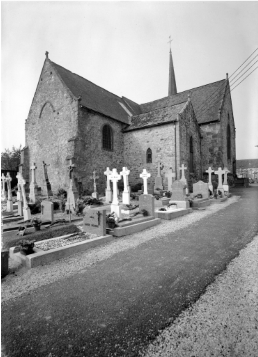
Elévation Nord-Est : vue générale
