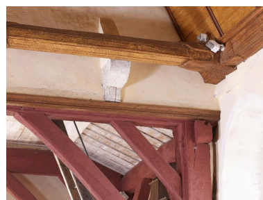
Détail d'un engoulant de la charpente Phot. Bernard Bègne IVR53_20133501903NUCA
