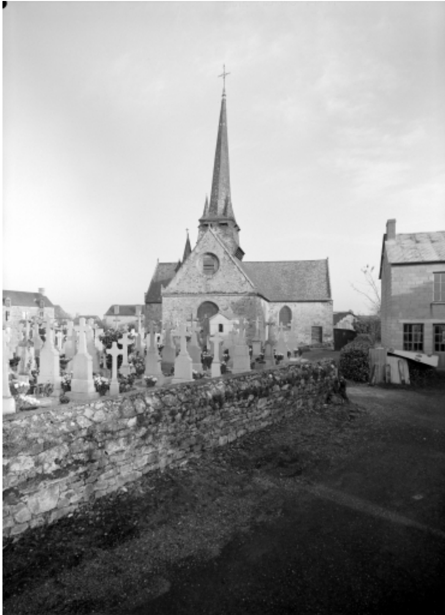
Elévation ouest : vue de situation
