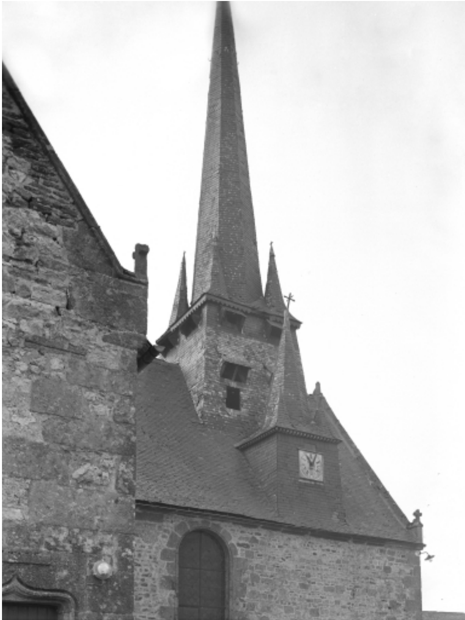
Clocher, chambre des cloches et clocheton, partie Nord : vue générale
