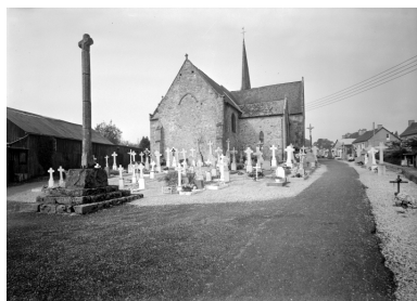
Elévation Nord-Est : vue générale Phot. François Dagorn IVR53_19723500358V
