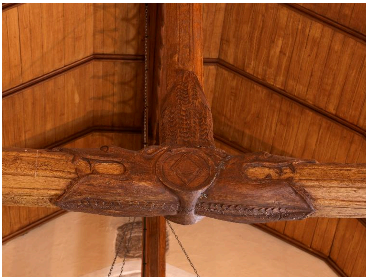
Engoulants de la charpente
