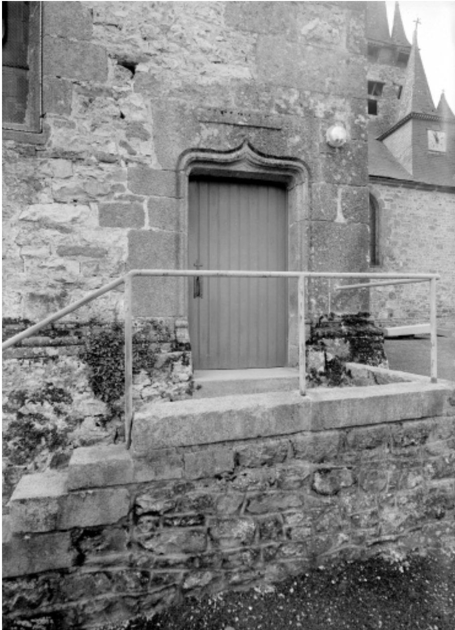
Elévation nord, transept, porte : vue générale
