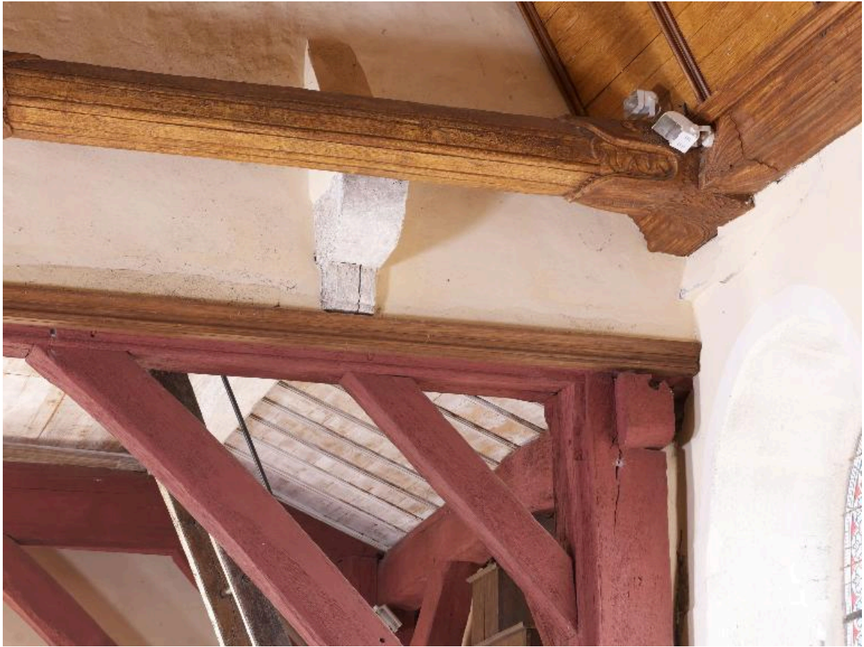
Détail d'un engoulant de la charpente
