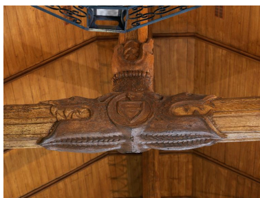
Engoulants de la charpente Phot. Bernard Bègne IVR53_20133501899NUCA
