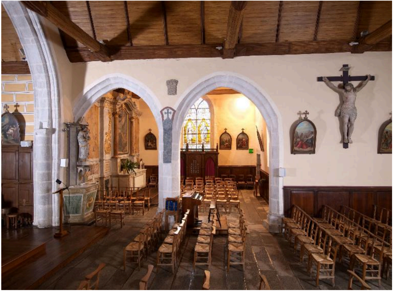
Vue générale transept Sud
