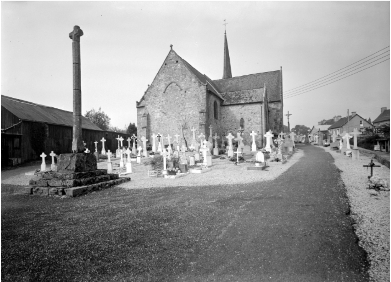
Elévation Nord-Est : vue générale
