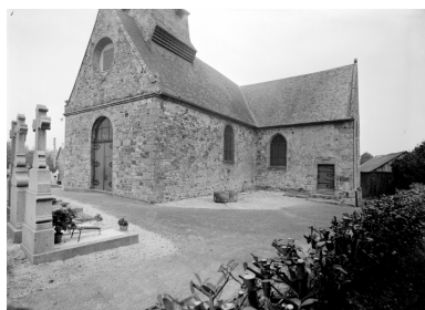
Elévation sud-ouest : vue générale Phot. François Dagorn IVR53_19723500361V
