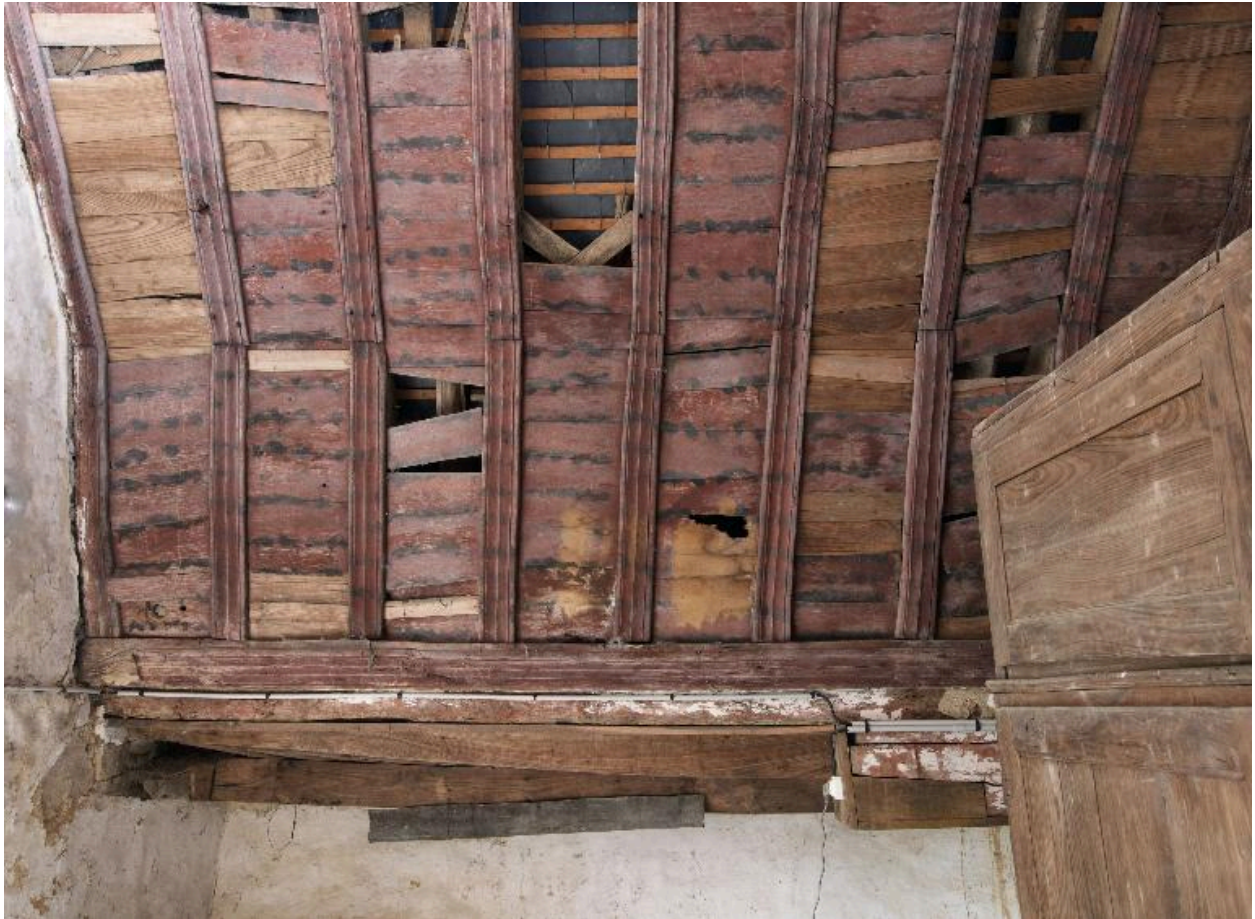
Charpente de la sacristie Sud
