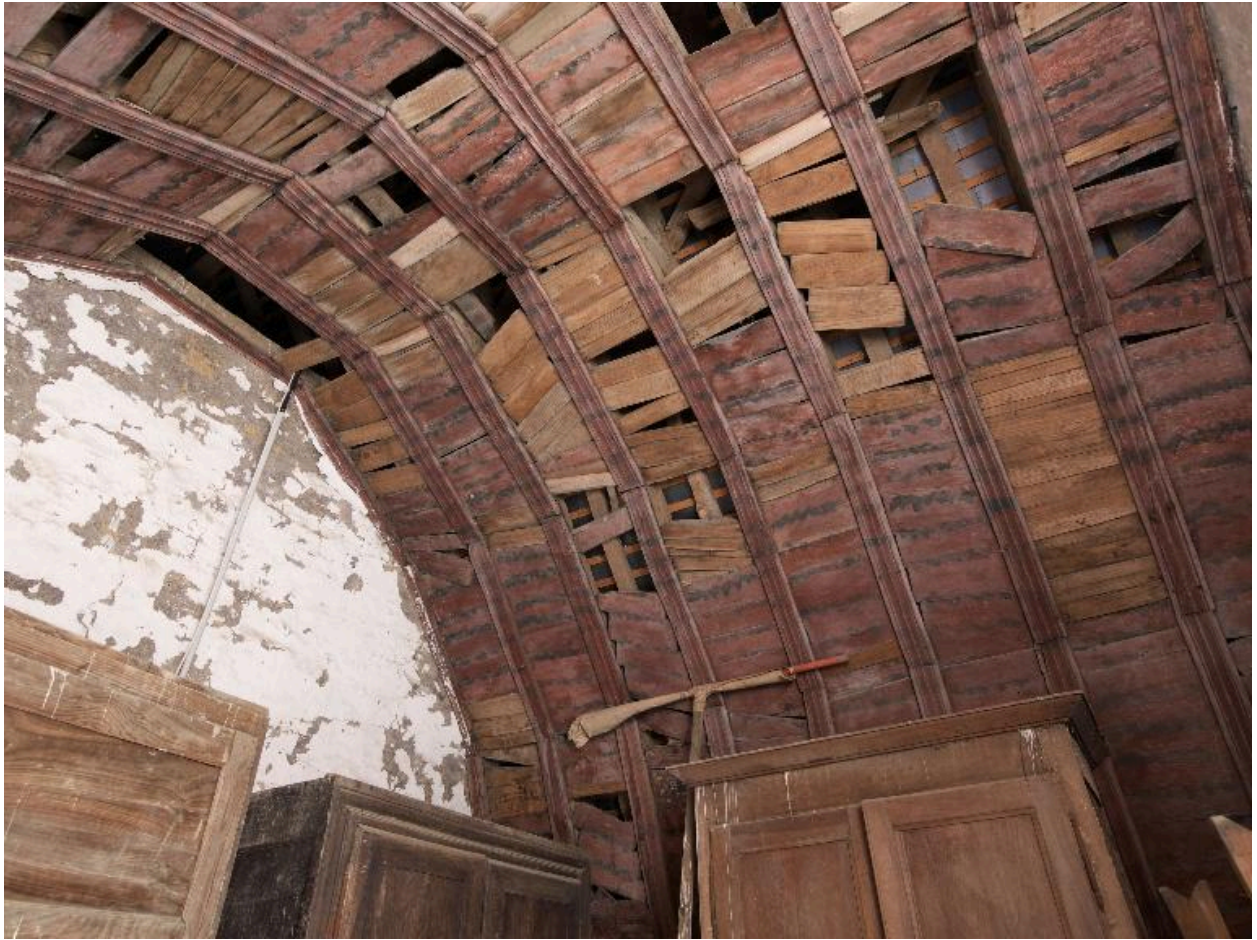
Charpente de la sacristie Sud
