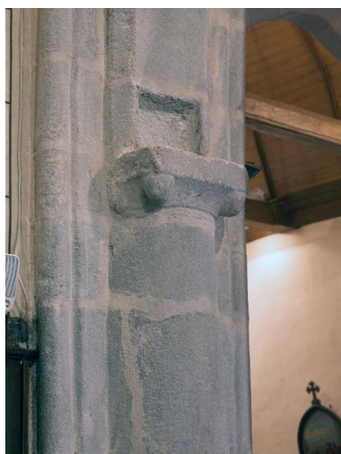
Emplacement possible de la poutre de gloire Phot. Bernard Bègne IVR53_20133501916NUCA
