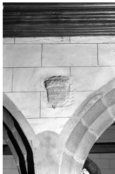
Intérieur, arcades Sud : détail de l'écu. Phot. François Dagorn IVR53_19723500511V
