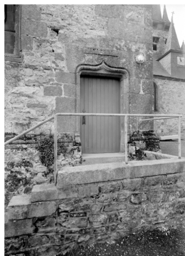
Elévation nord, transept, porte : vue générale Phot. François Dagorn IVR53_19723500365V
