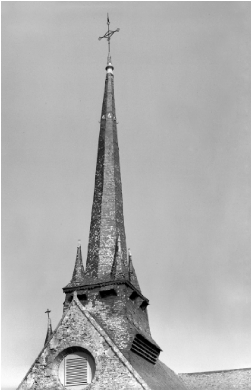
Elévation Est, clocher : vue générale
