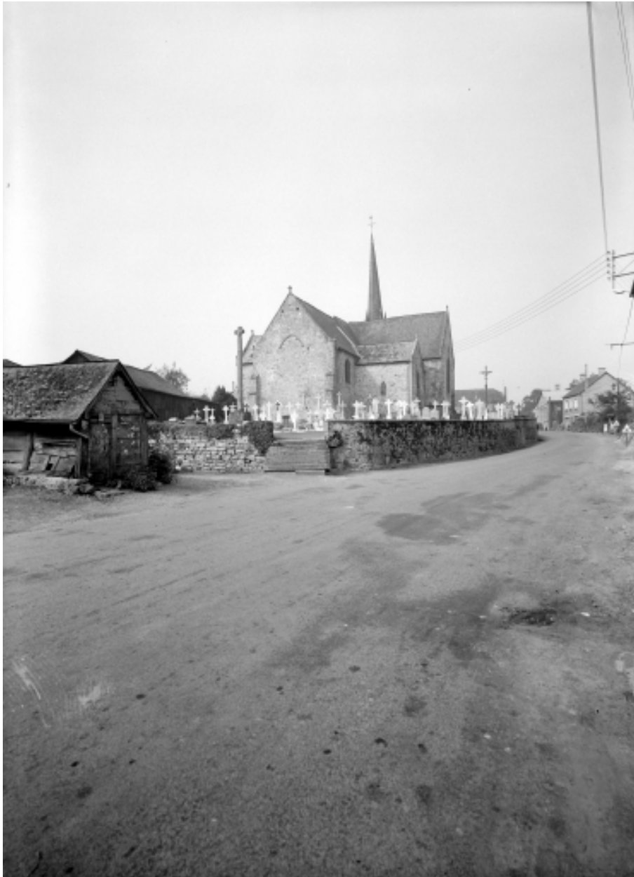
Elévation nord-est : vue de situation.
