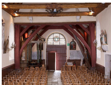
Vue générale de la nef et de la base du clocher Phot. Bernard Bègne IVR53_20133501907NUCA
