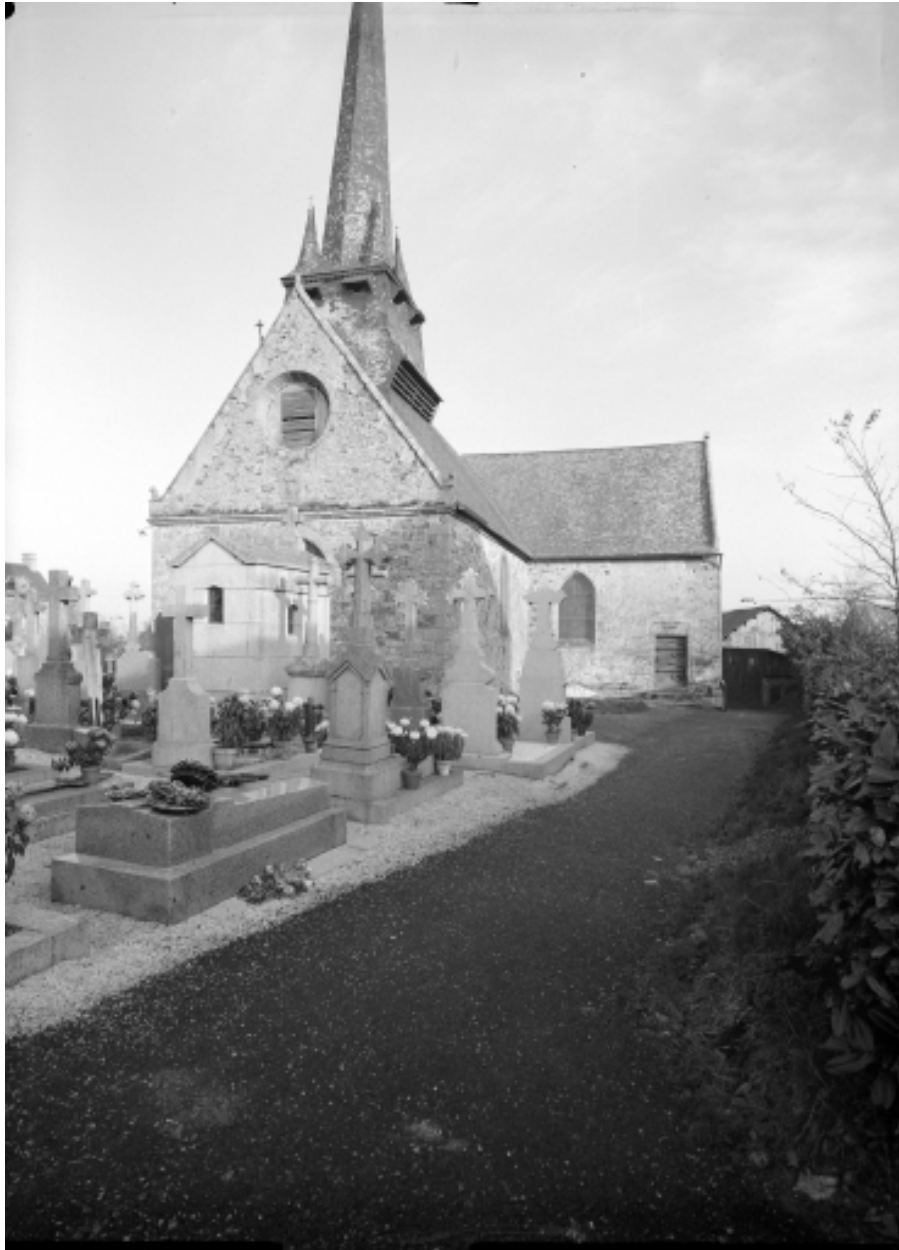
Elévation ouest : vue de situation
