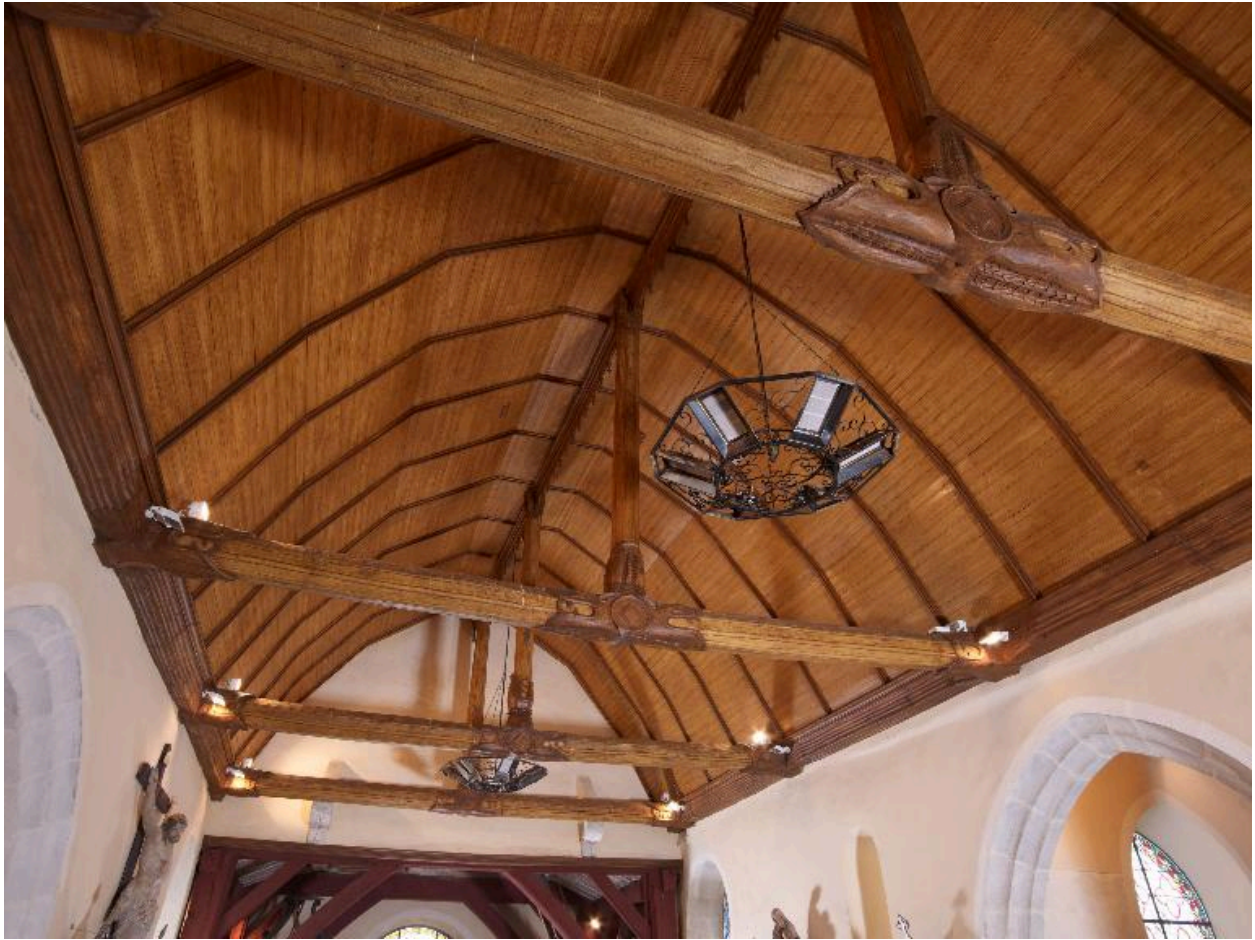
Charpente de la nef
