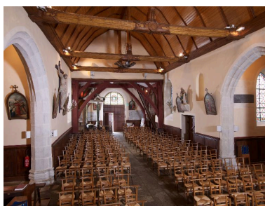
Vue générale de la nef Phot. Bernard Bègne IVR53_20133501908NUCA
