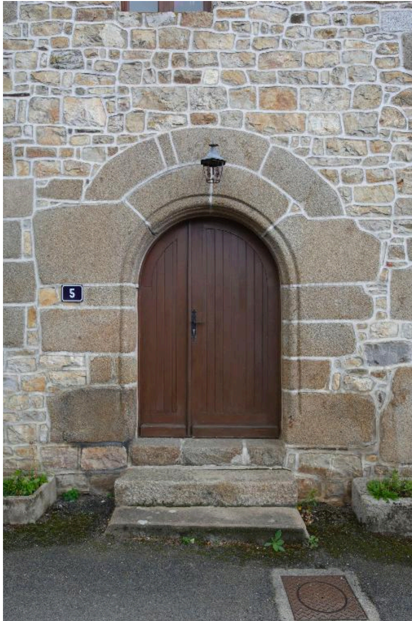
Détail de la porte en plein cintre située dans la partie nord de la nef
