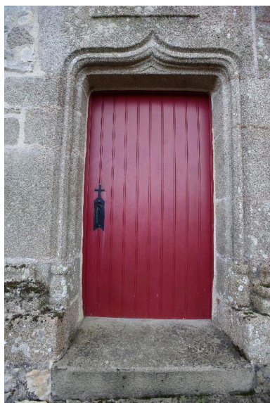
Détail de la porte du transept nord Phot. Norbert Lambart IVR53_20133502003NUCA
