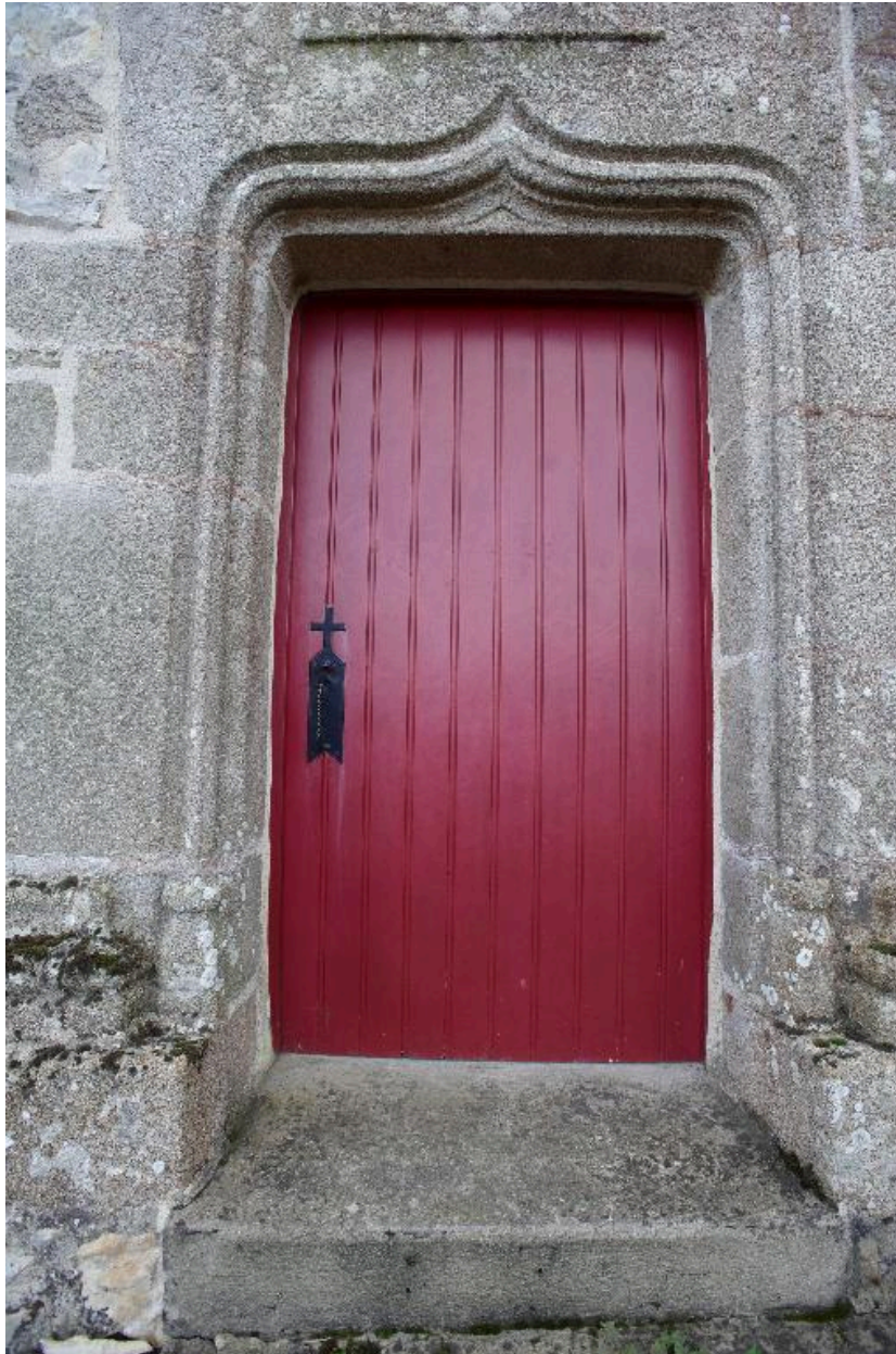
Détail de la porte du transept nord
