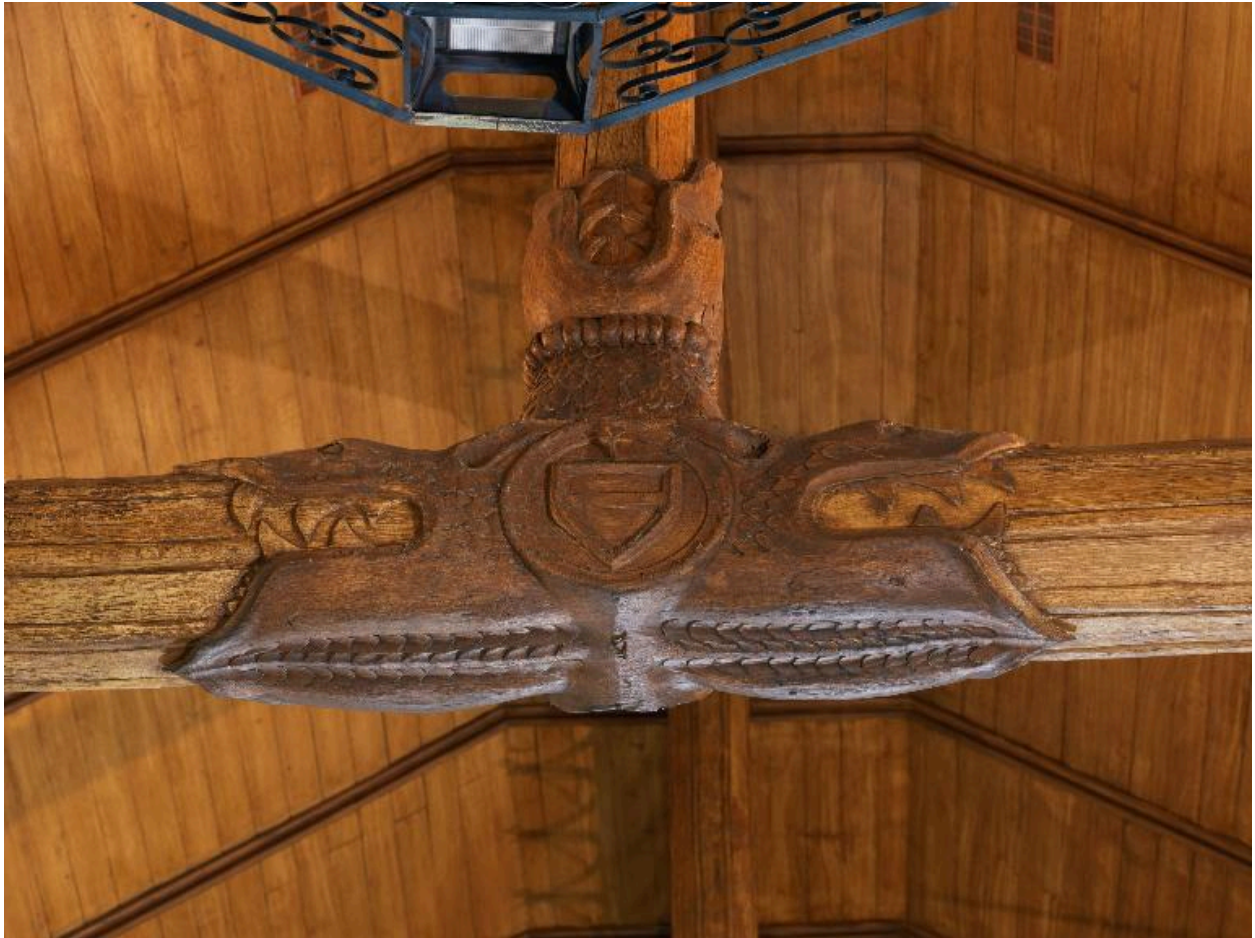
Engoulants de la charpente
