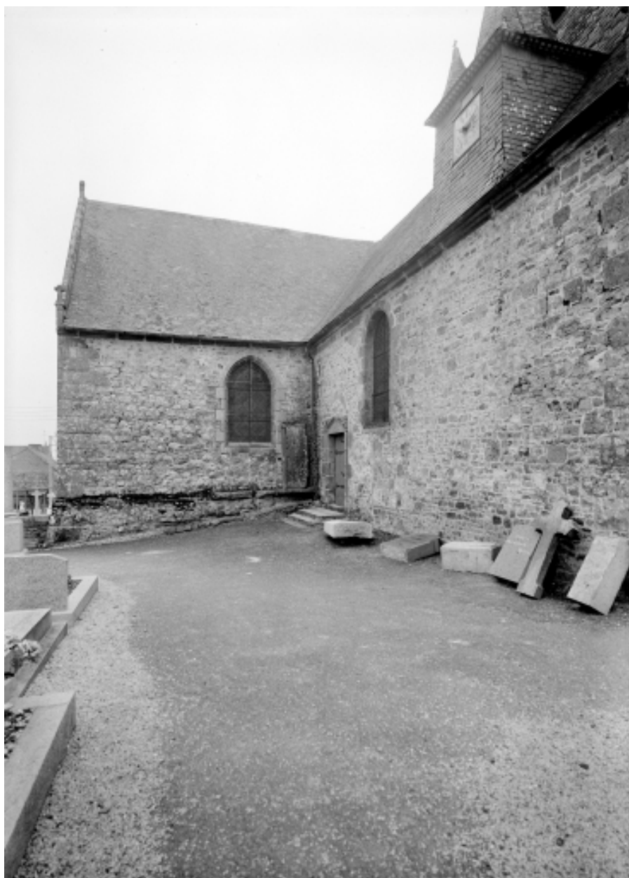
Elévation nord, angle de la nef et du transept : vue générale
