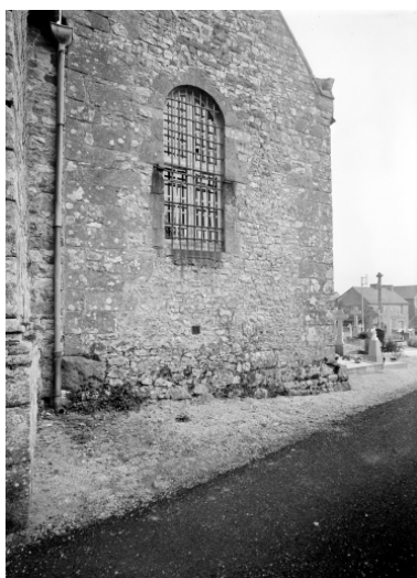
Elévation sud, sacristie, mur sud : vue générale Phot. François Dagorn IVR53_19723500363V
