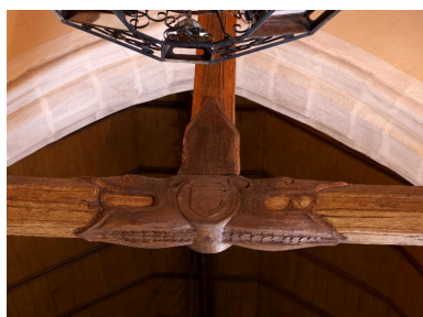
Engoulants de la charpente Phot. Bernard Bègne IVR53_20133501901NUCA
