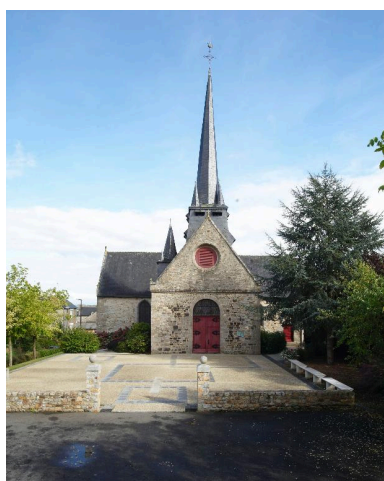
Vue générale Ouest Phot. Norbert Lambart IVR53_20133501986NUCA
