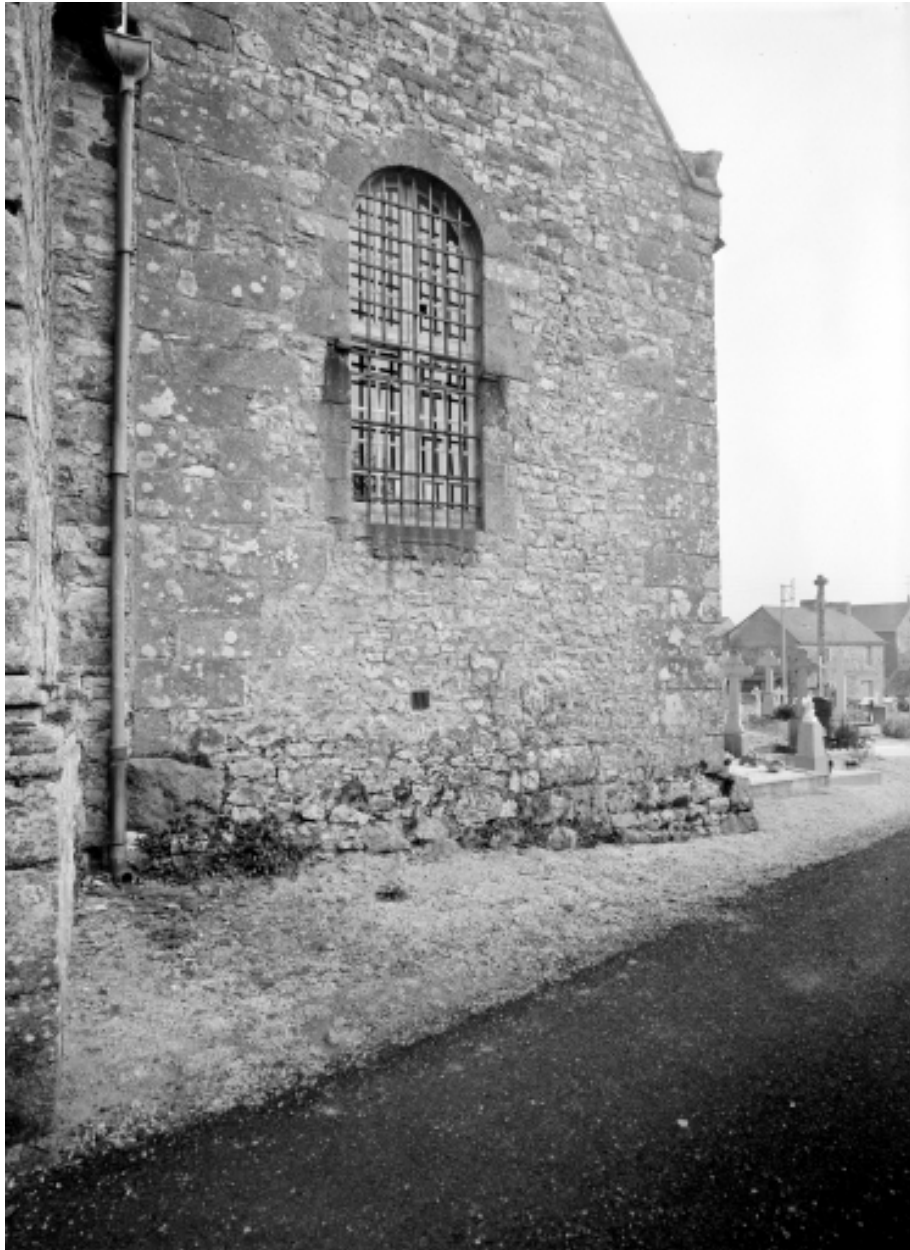
Elévation sud, sacristie, mur sud : vue générale
