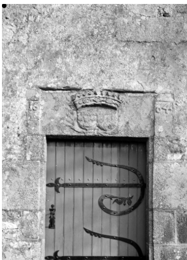
Elévation sud, bras du transept, porte : détail du linteau Phot. Guy Artur, Phot. Norbert Lambart IVR53_19683500788V
