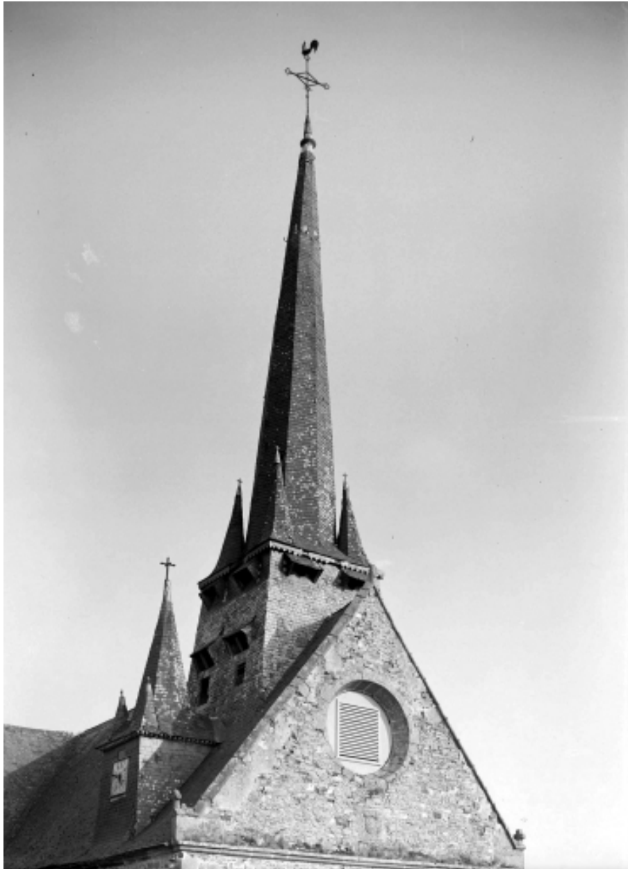
Elévation est, clocher : vue générale.
