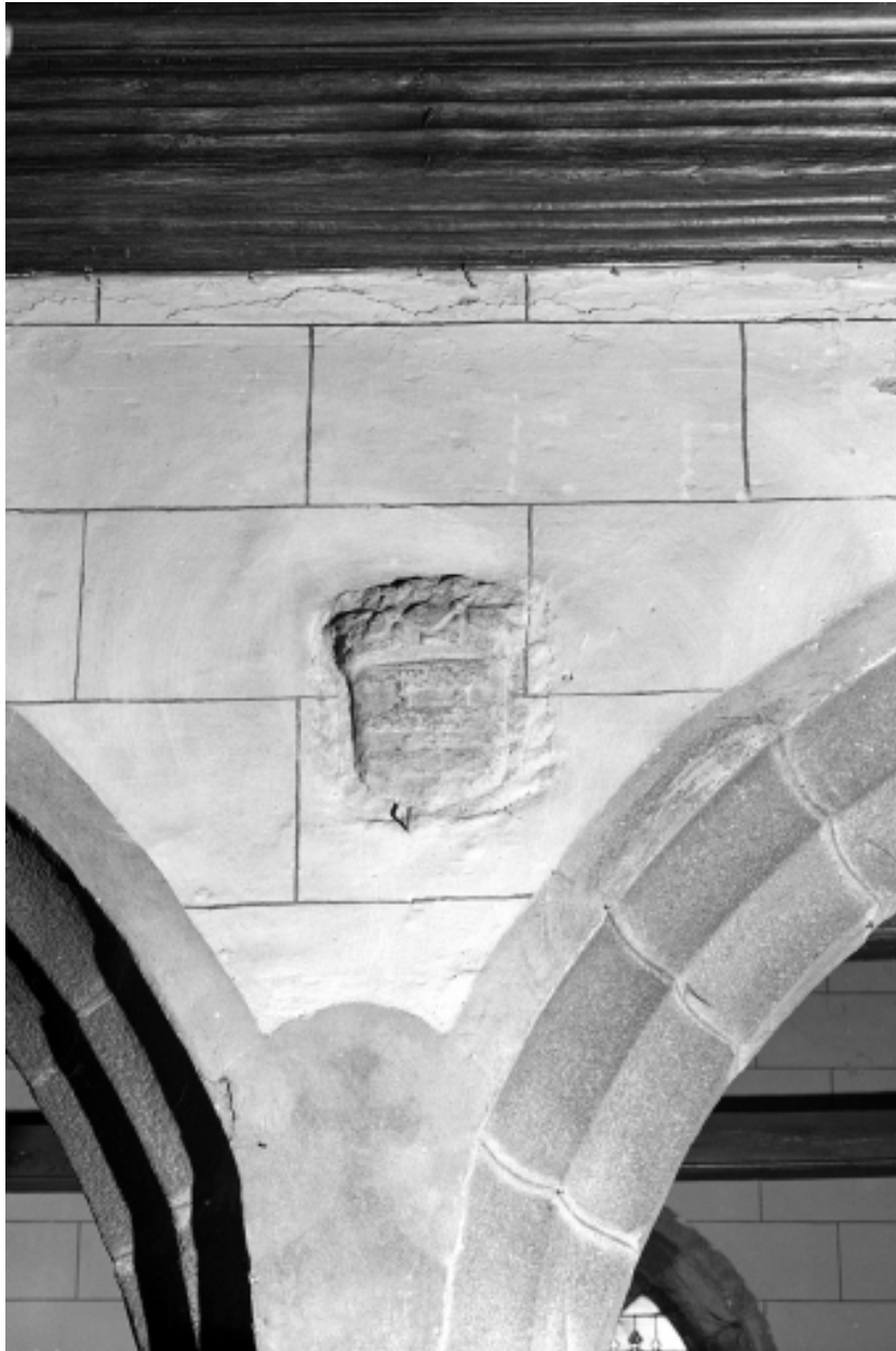
Intérieur, arcades Sud : détail de l'écu.
