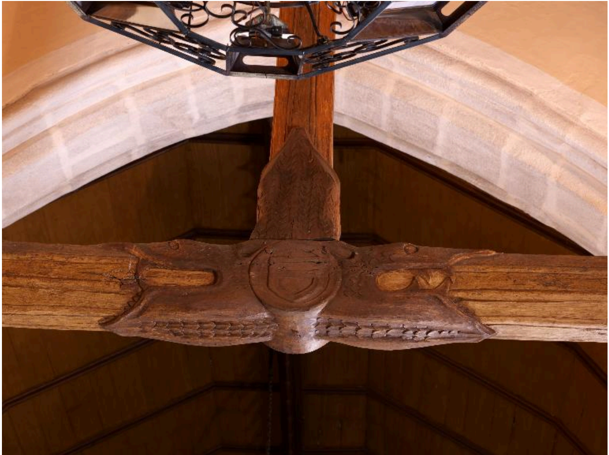
Engoulants de la charpente
