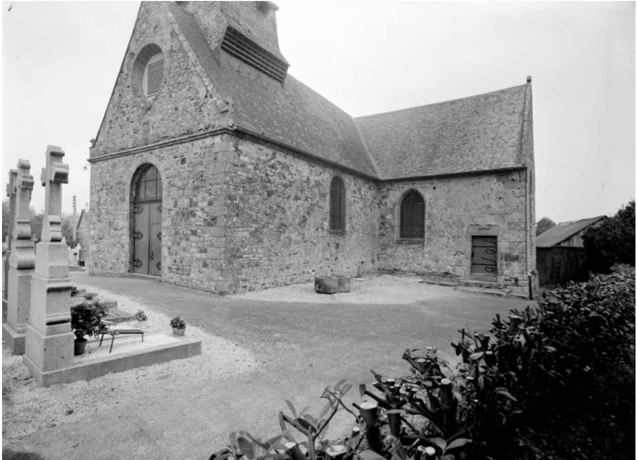
Elévation sud-ouest : vue générale
