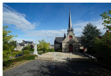
Vue générale Ouest Phot. Norbert Lambart IVR53_20133501985NUCA
