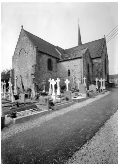
Elévation Nord-Est : vue générale Phot. François Dagorn IVR53_19723500360V
