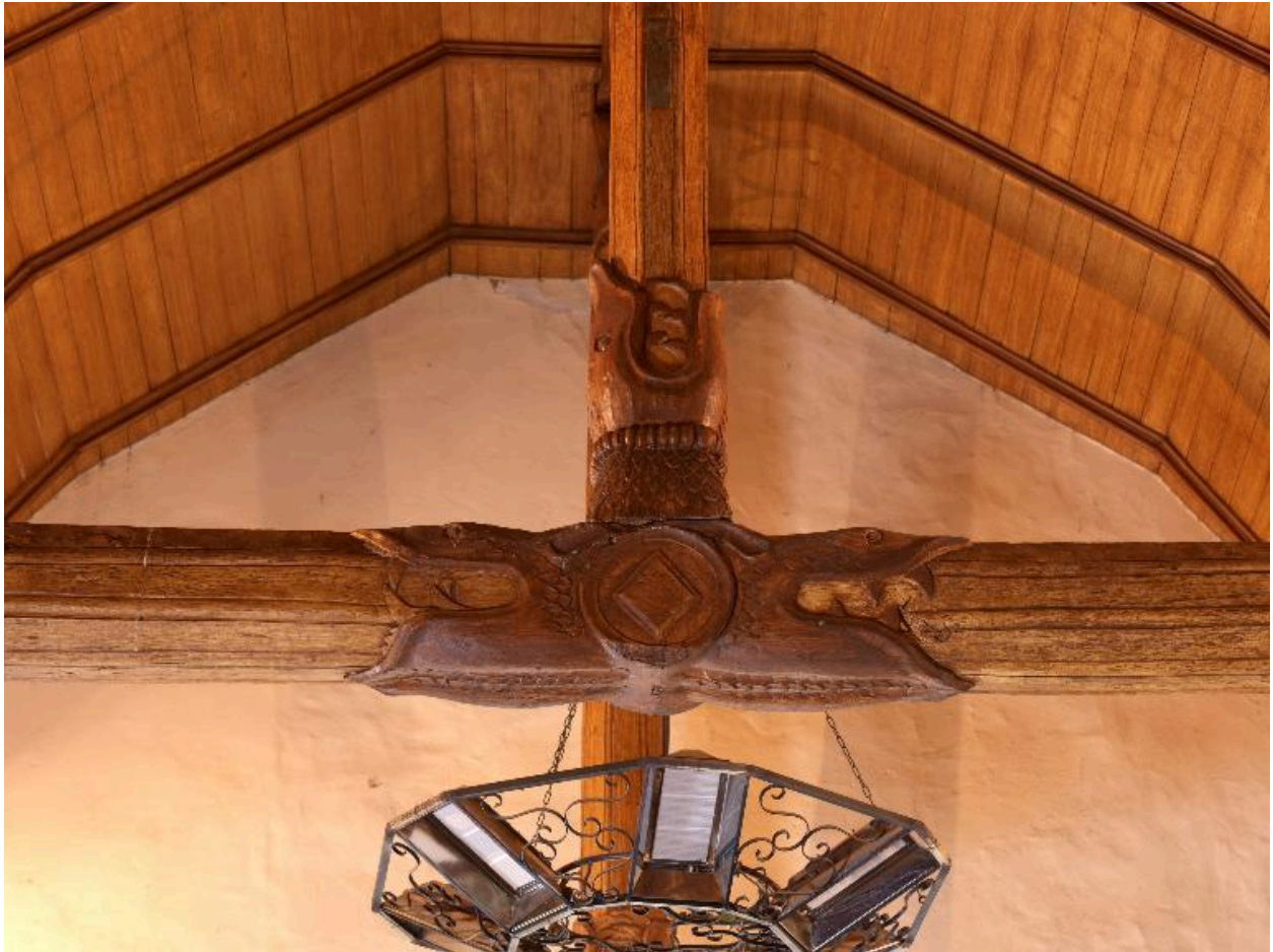
Engoulants de la charpente
