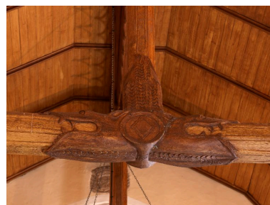
Engoulants de la charpente Phot. Bernard Bègne IVR53_20133501900NUCA
