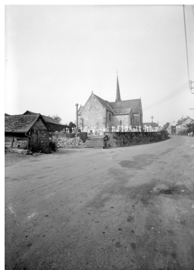
Elévation nord-est : vue de situation. Phot. François Dagorn IVR53_19723500357V
