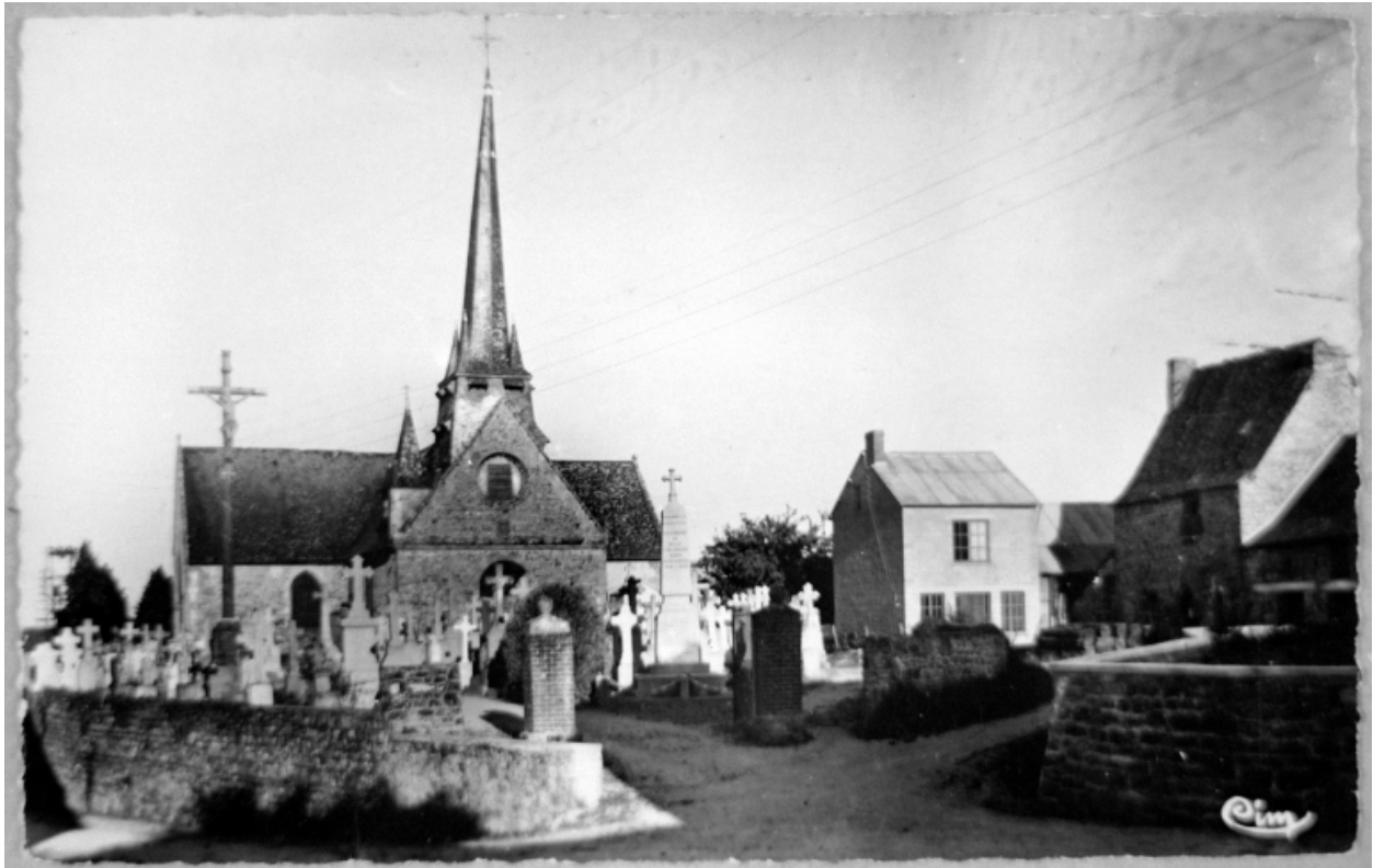
Elévation Sud : vue de situation (Carte postale ancienne, APIB)
